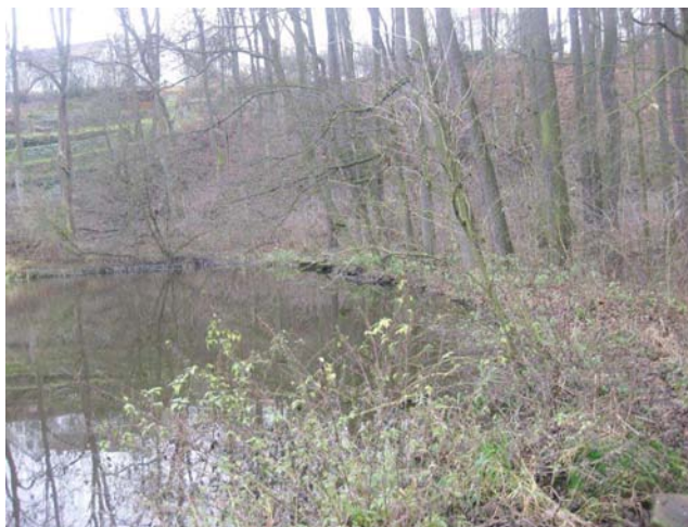
Pohled do nadjezí
