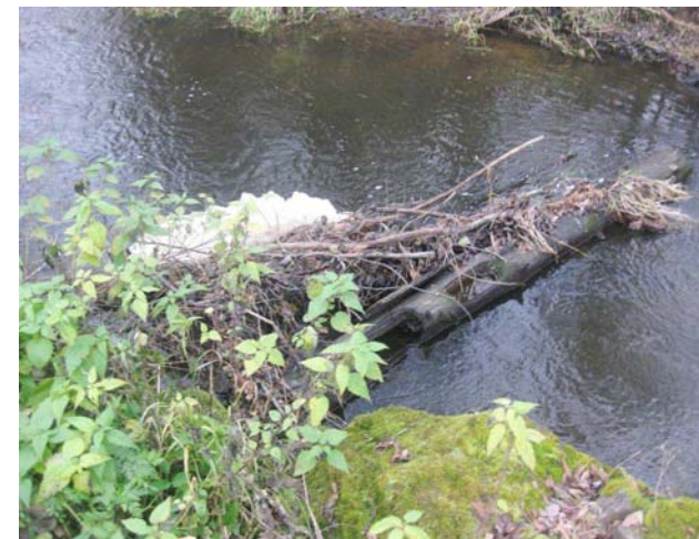
Zbytky původní konstrukce jezu
