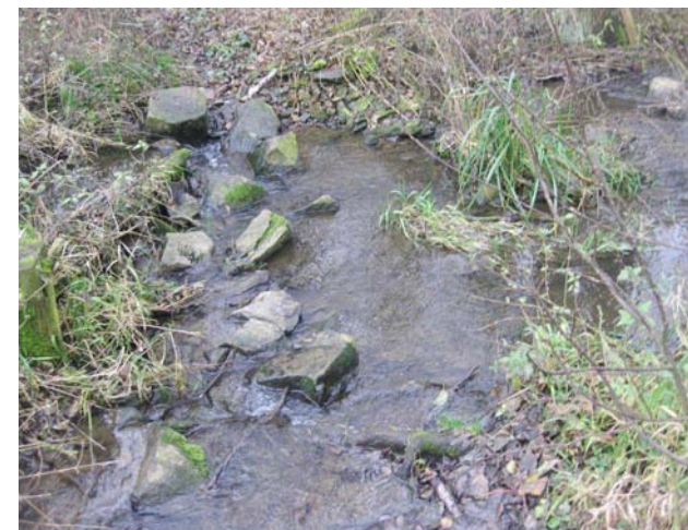
Průpich přes jez
