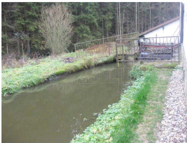
Náhon s objektem vtoku do MVE
