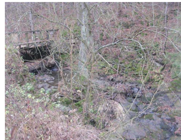
Vrchní část bezpečnostního přelivu
