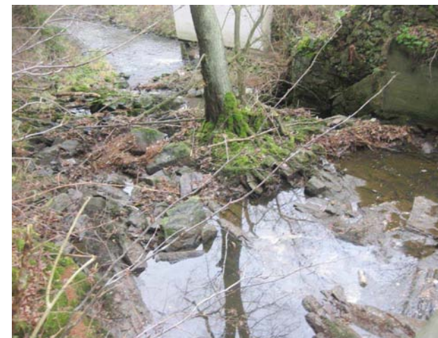
Bezpečnostní přeliv nalevé straně, na pravé straně MVE
