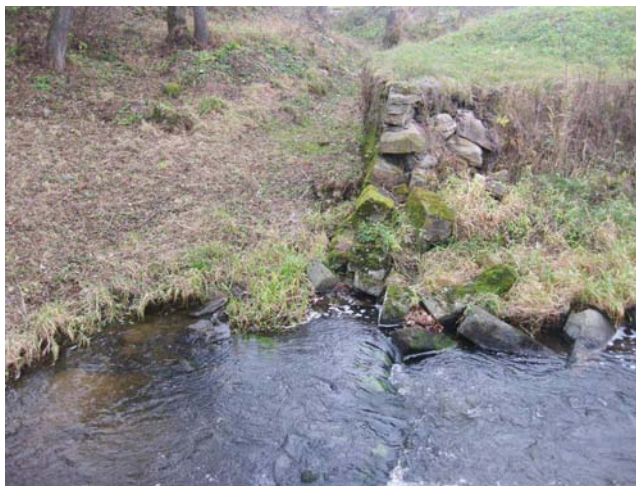
Detail zbytku konstrukce jezu a začátku náhonu
