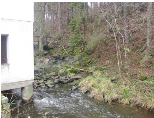
Pohled na bezpečnostní přeliv odspodu
