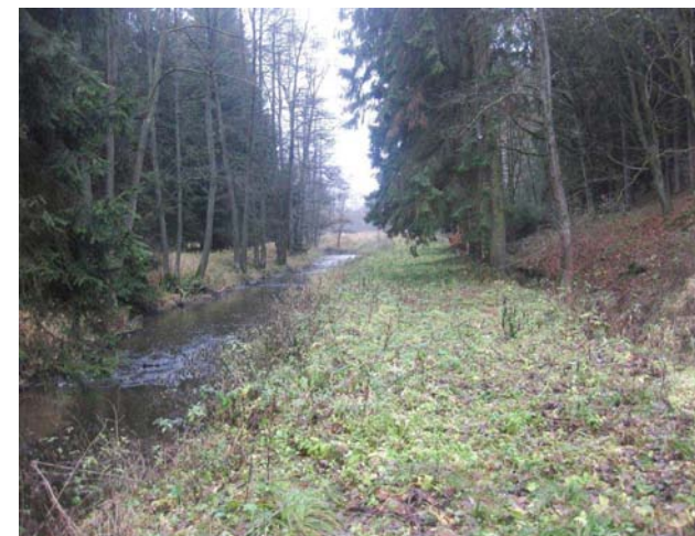
Odpadní kanál od MVE
