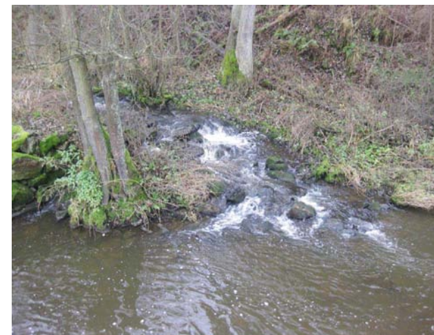
Průpich na levé straně jezu
