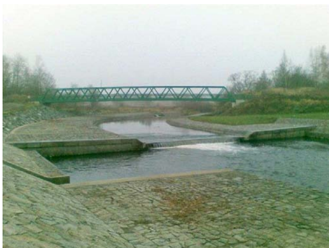
Celkový pohled na stupeň z podjezí
