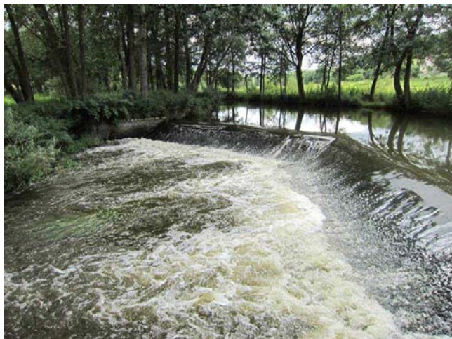
Pohled na jez
