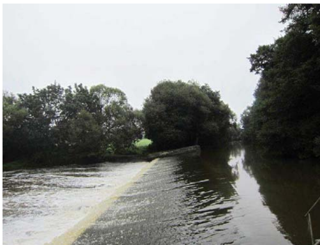
Detail pravého břehu
