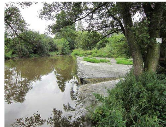
Pohled na jez a nadjezí
