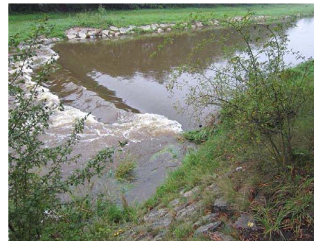
Pohled na stupeň - průtok 10 m3/s
