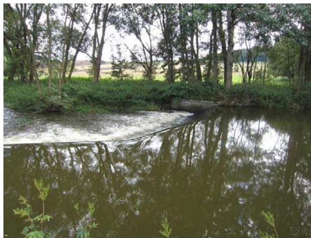
Pohled na jez
