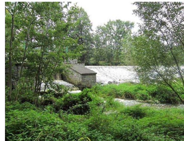
Pohled na jez a propust z podjezí
