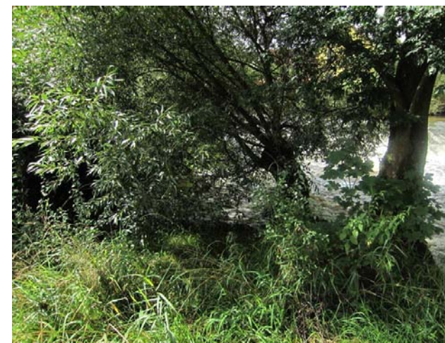
Detail pravá strany jezu
