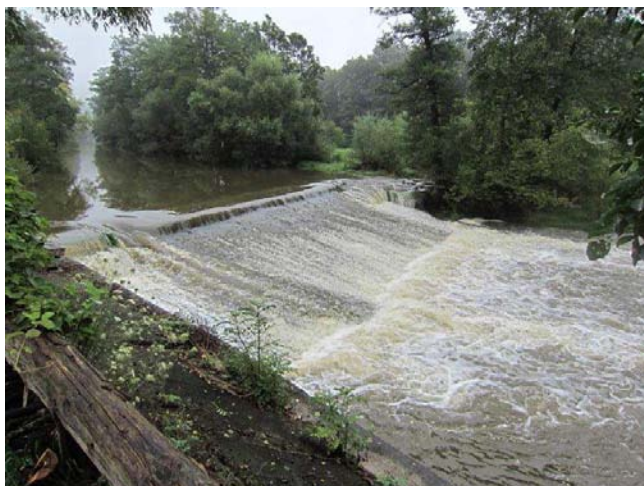
Pohled na jez
