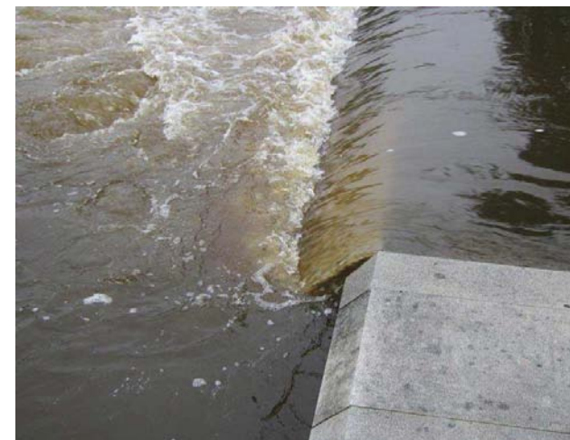
Pohled na stupeň - průtok 10 m 3 /s
