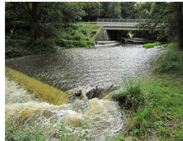
Pohled na celou stavbu
