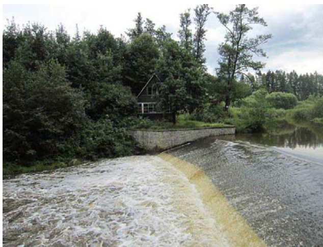
Pohled na jez, detail pravého břehu
