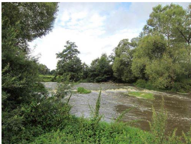
Pohled na jez
