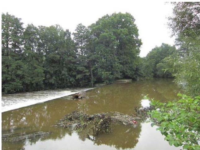
Pohled na jez
