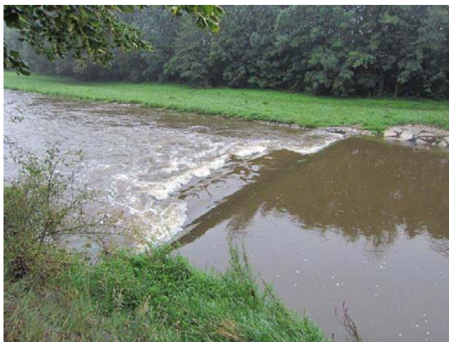
Pohled na stupeň - průtok 10 m3/s
