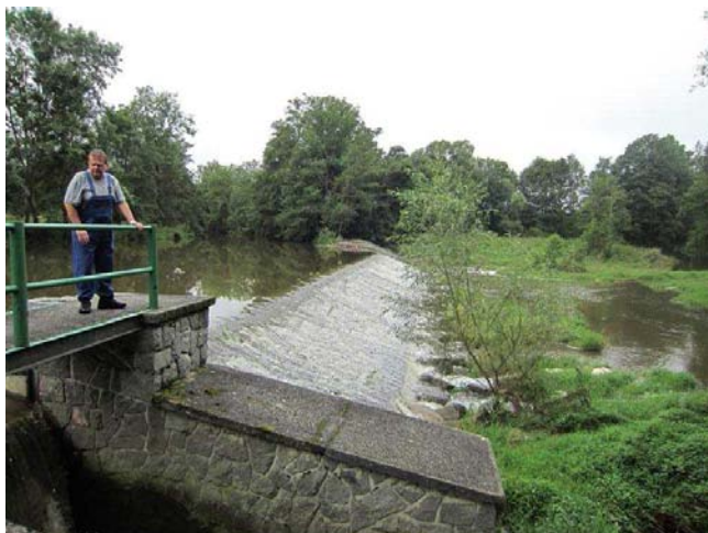
Pohled na jez a propust
