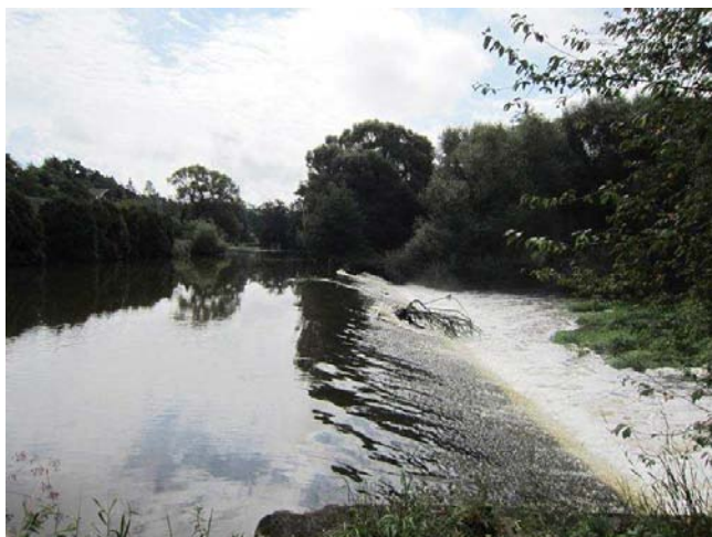
Pohled na jez
