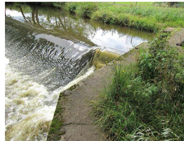
Pohled na jez, detail levé strany
