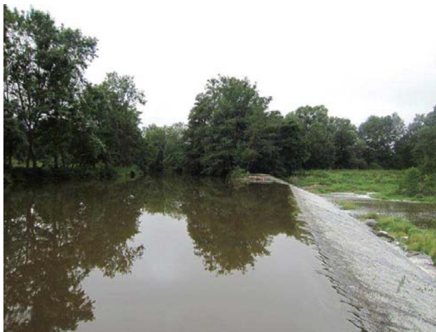
Pohled na jez
