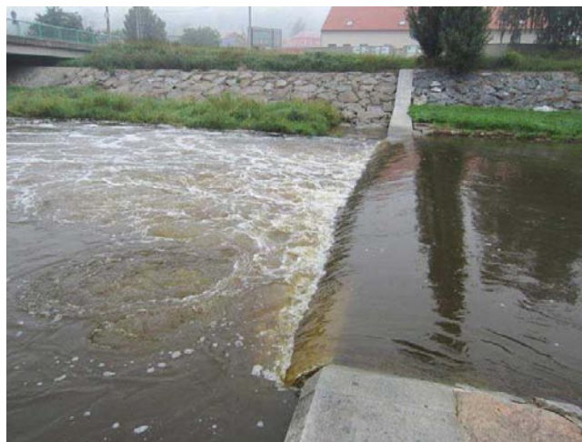
Pohled na stupeň - průtok 10 m 3 /s
