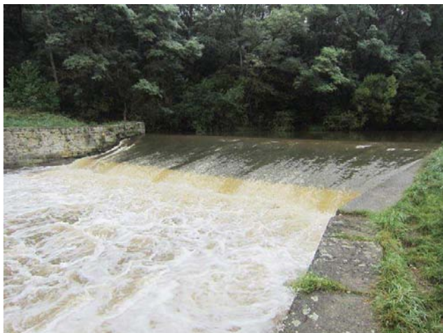
Pohled na jez
