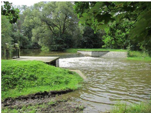
Pohled na jez
