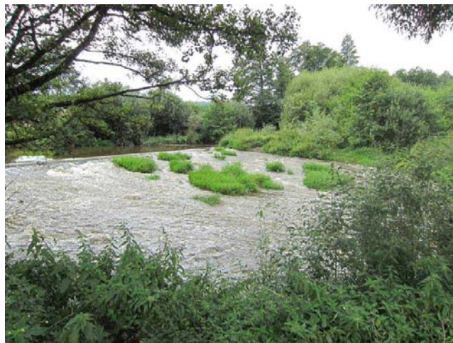
Pohled na jez
