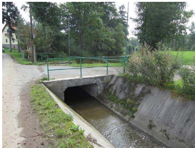
Jalová propust na náhonu
