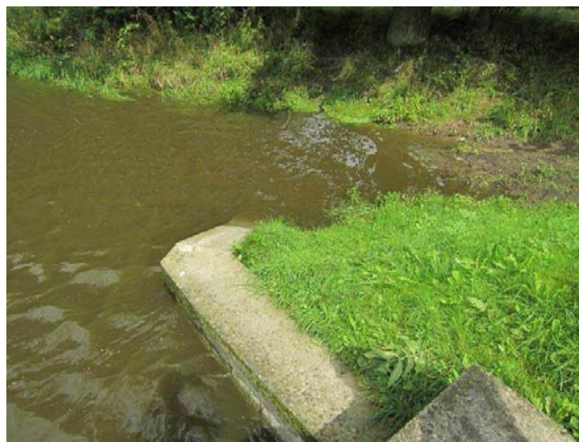
Detail pravého břehu v podjezí
