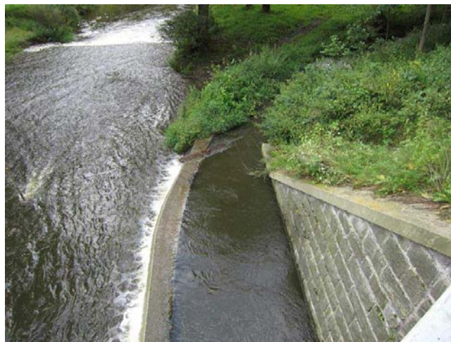
Detail náhonu pod mostem
