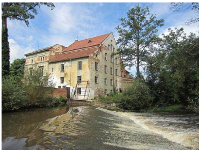
Pohled na jez a bývalý mlýn, ve kterém je MVE
