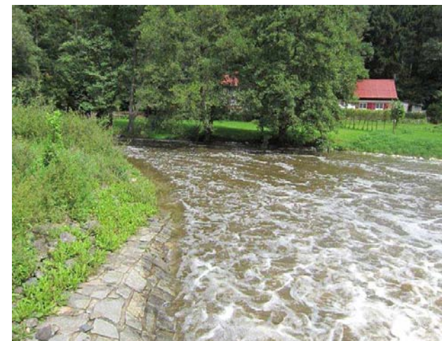
Opevnění v podjezí na levém břehu
