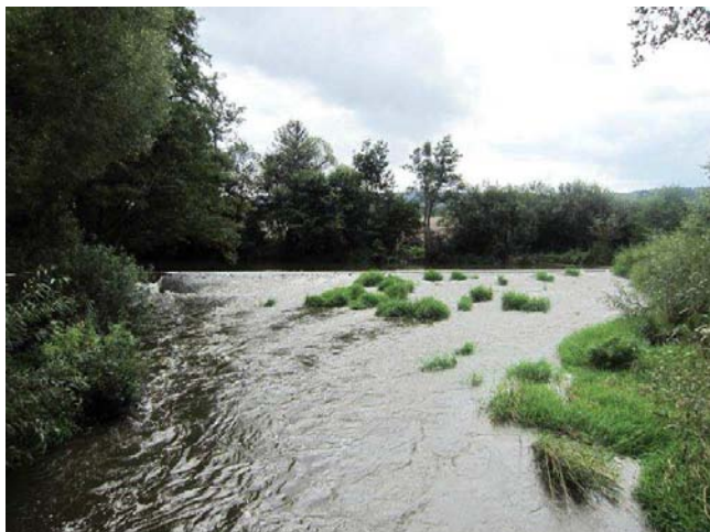
Pohled na jez
