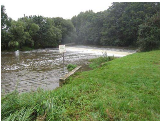
Pohled na jez
