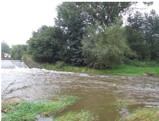
Detail levého břehu
