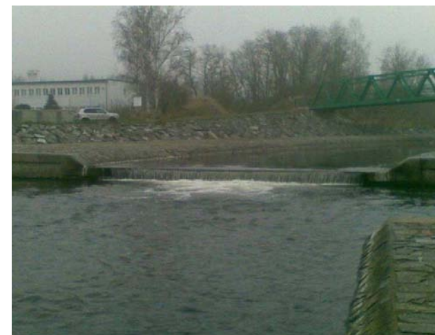
Detail hrany stupně
