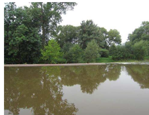
Pohled na hrázku, za ní je průleh
