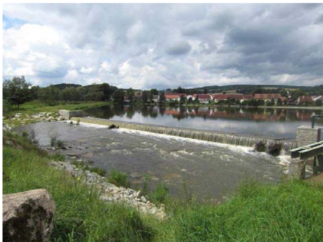
Hráz průtočného rybníku
