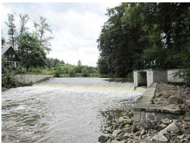
Pohled na jez a náhon na levém břehu
