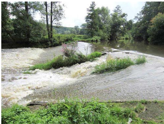
Pohled na jez
