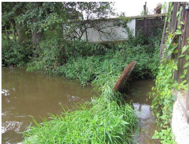
Vtok do MVE na levé straně jezu
