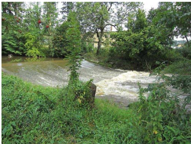
Pohled na jez, v pozadí továrna
