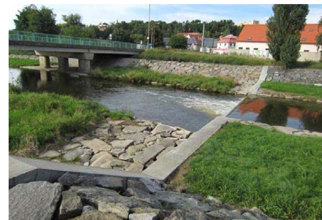
Pohled na stupeň a most
