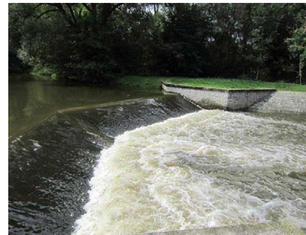
Pohled na jez, detail levého břehu
