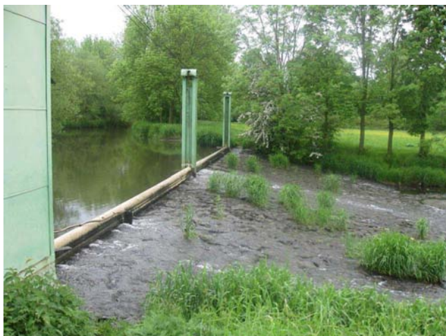
Pohled na jez
