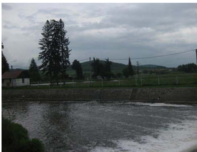
Podjezí – opevněná pravá strana
