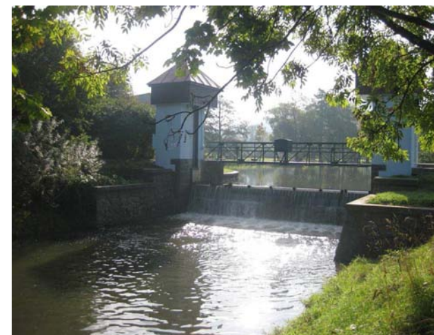
Pohled na jez z podjezí
