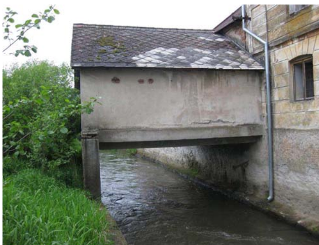
MVE – odpadní kanál
