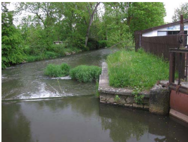
Pohled na jez a MVE na pravém rameni
