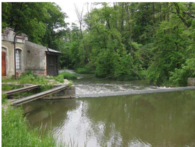
Pohled na levou stranu jezu s budovou bývalého mlýnu a MVE
