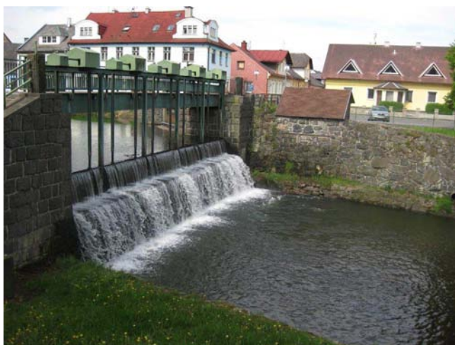
Pohled na jez a na MVE na levé straně
