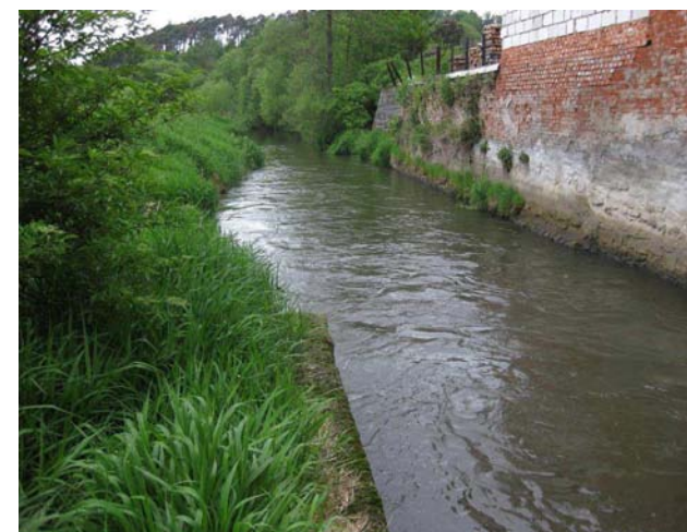
MVE - odpadní kanál
