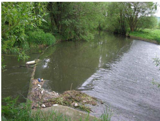
Pohled na jez
