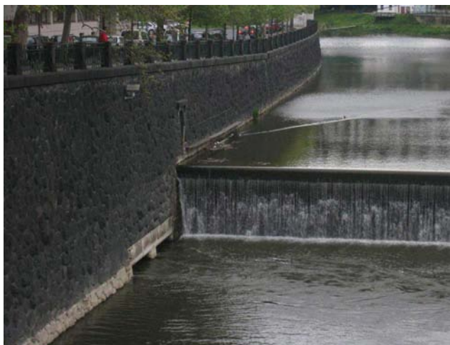
Na pravém břehu odpad z MVE
