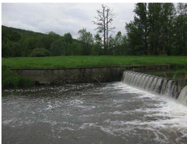
Podjezí na pravé straně
