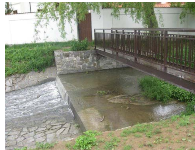
Přepad Čížického potoka přes náhon
