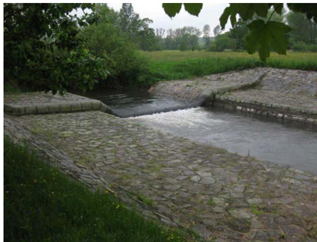
stabilizační stupeň na konci úpravy toku Úhlavy v Malechově
