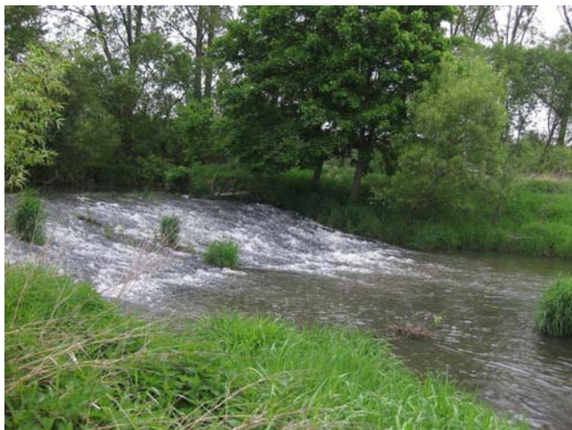
Pohled na jez
