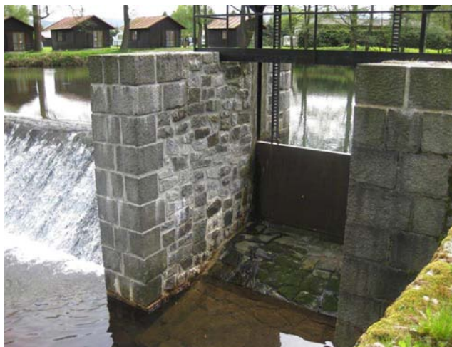
Detail štěrkové propusti
