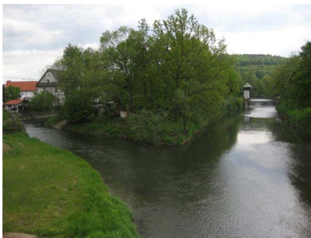
Pohled na soutok odpadního kanálu a Úhlavy
