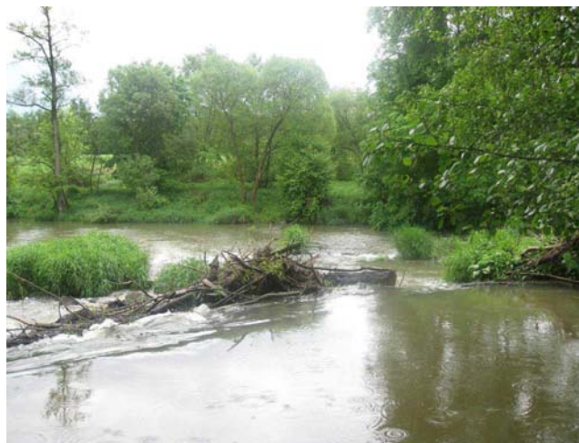
Pohled na pravou stranu jezu
