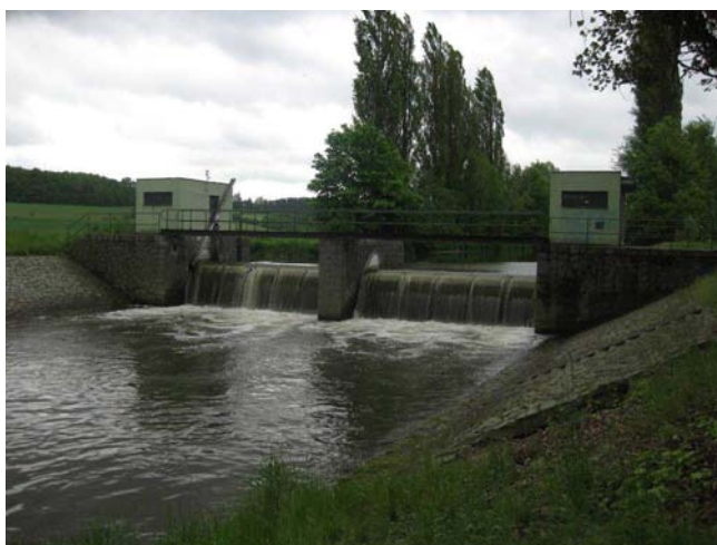
Pohled na jez
