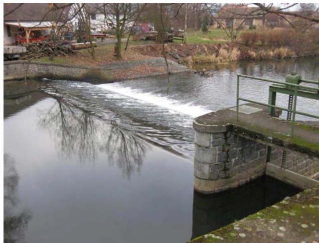
Pohled na jez se štěrkovou propustí
