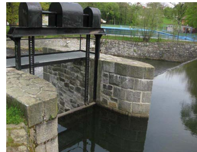
Pohled na jez z nadjezí, vlevo propust
