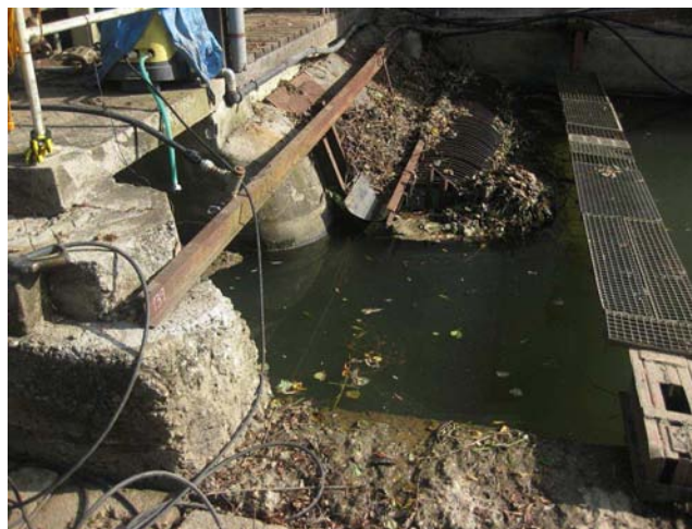
Jalová propust u MVE
