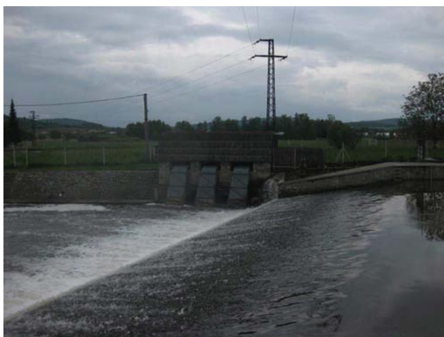
Pohled na pravou stranu jezu s MVE
