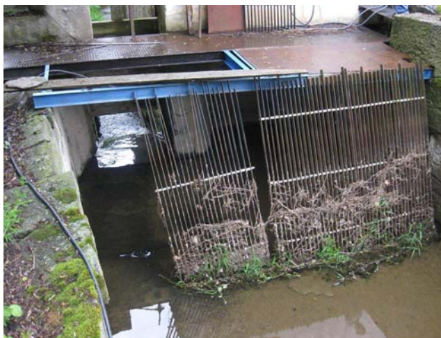
MVE, vtok s jalovou propustí
