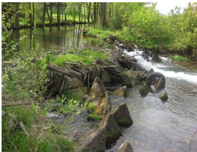
Pohled na jez
