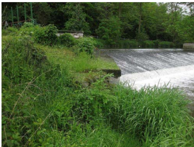
Pohled na pravou stranu jezu
