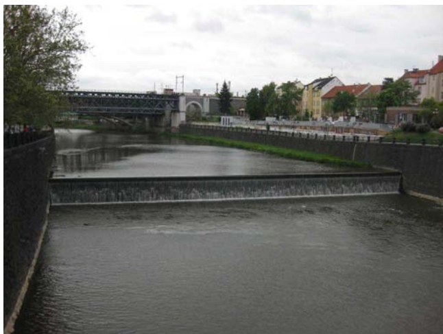
Pohled na jez
