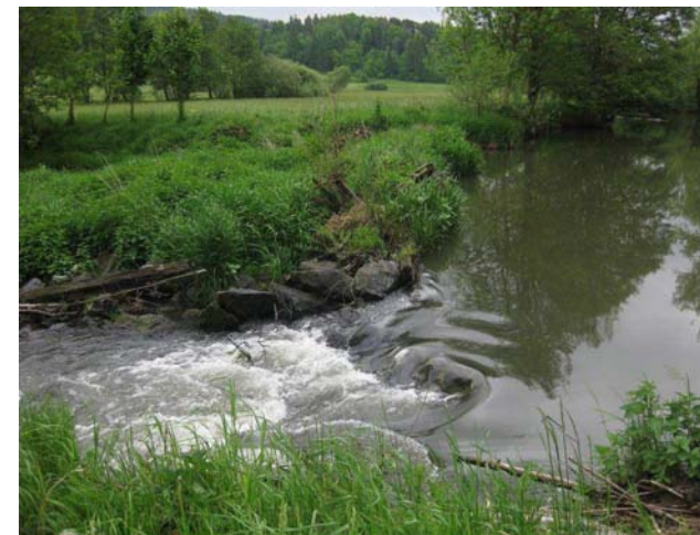
Pohled na jez
