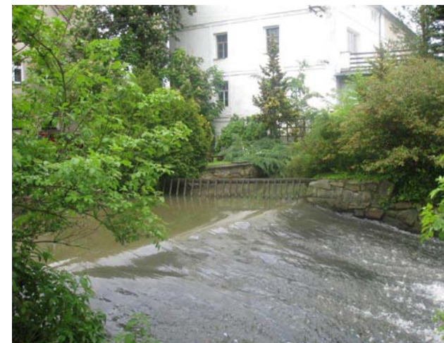
Vtok do nefunkční MVE a odlehčovací propust
