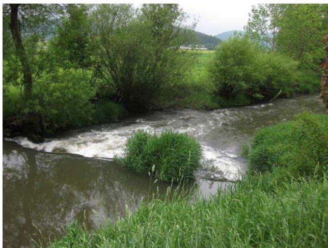
Pohled na jez
