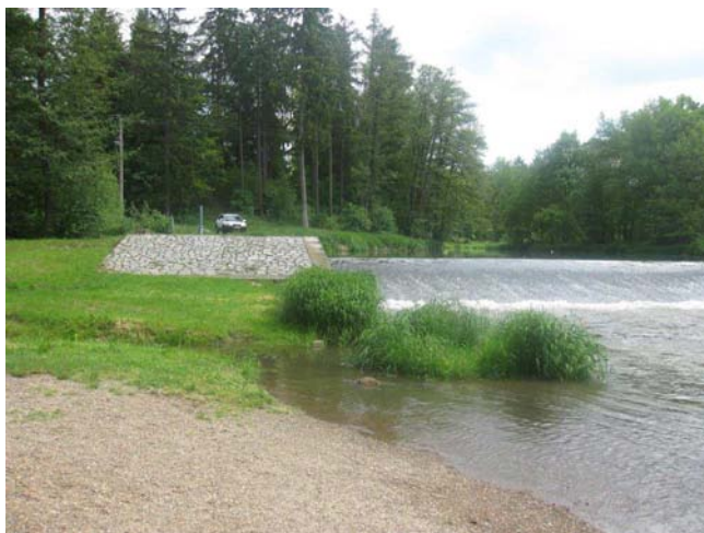
Pravá strana jezu s náhonem a vyústěním odlehčovacího přepadu
