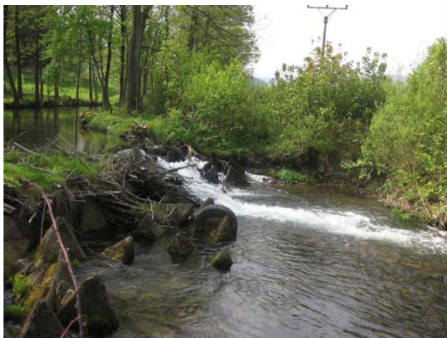
Pohled na jez
