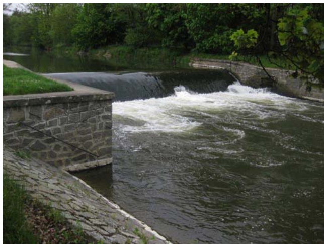
Pohled na jez
