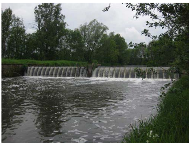
Pohled na jez
