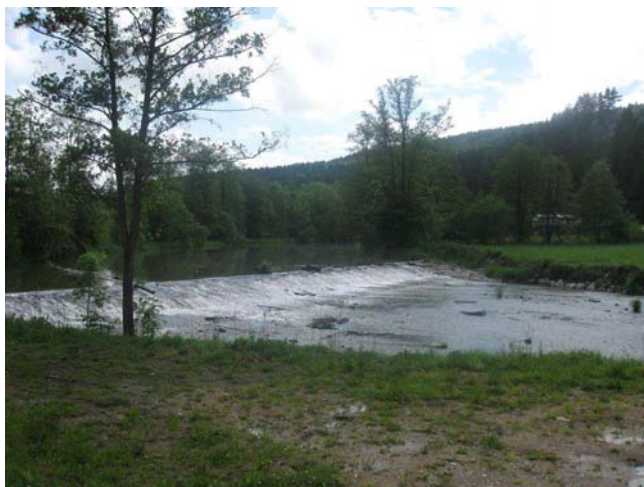
Pohled na jez
