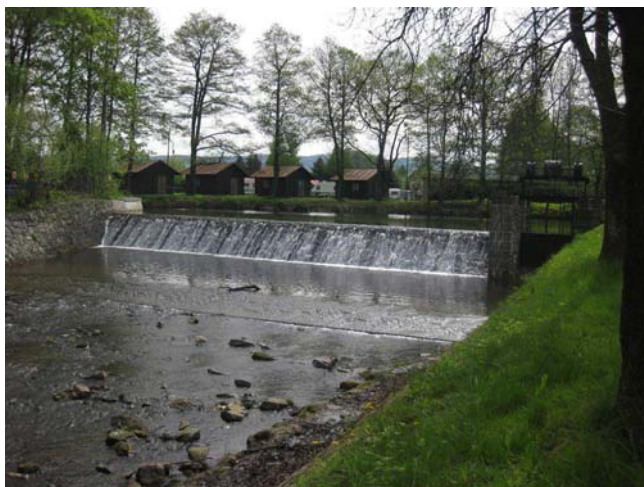
Pohled na jez
