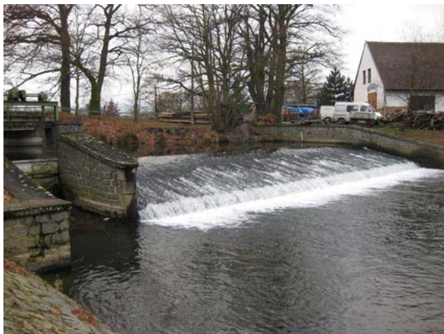
Pohled na jez se štěrkovou propustí
