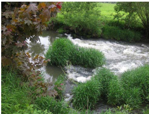
Pohled na jez
