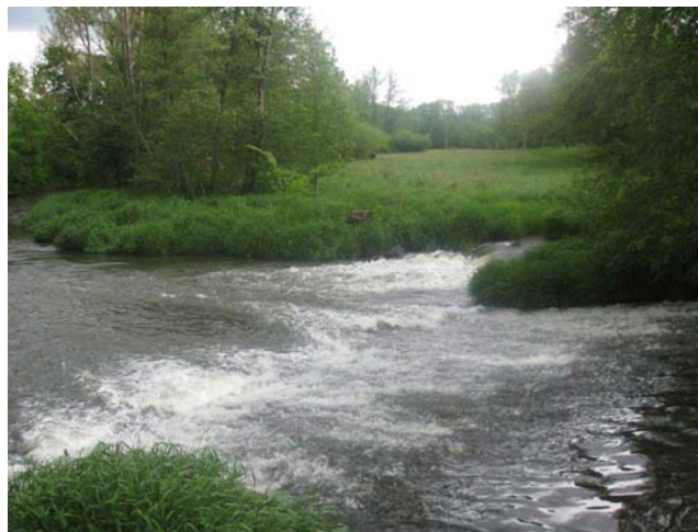
Pravá strana jezu, odlehčovací propust a vtok do náhonu
