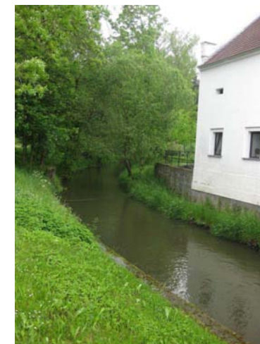
Odpadní kanál od MVE
