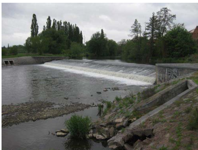
Pohled na jez
