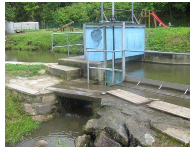
Stavidlo náhonu a odlehčovací kanál
