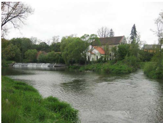
Pohled na jez ze silničního mostu
