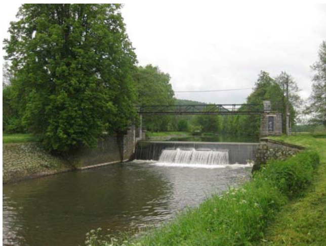
Pohled na jez
