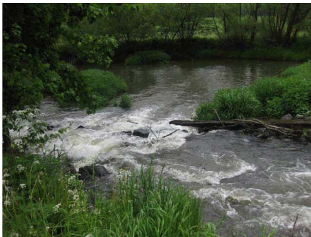
Pohled na jez
