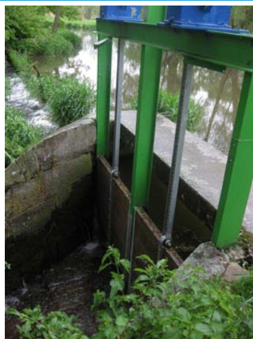
Stavidlo odlehčovacího jezu
