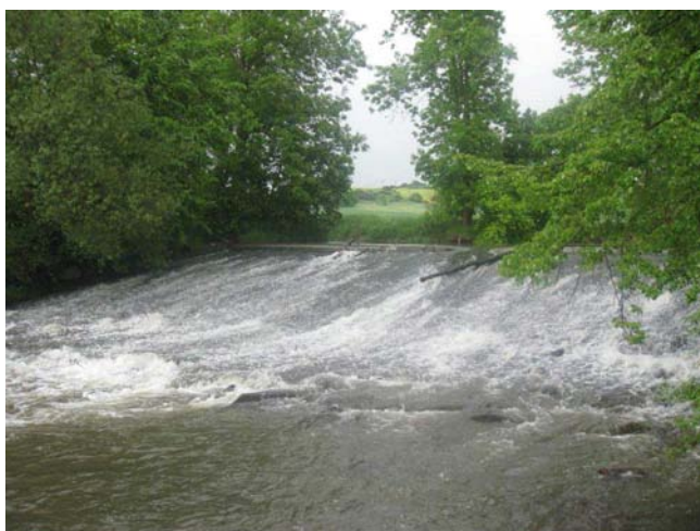
Pohled na jez
