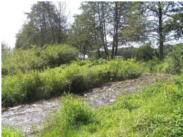
Pohled na jez
