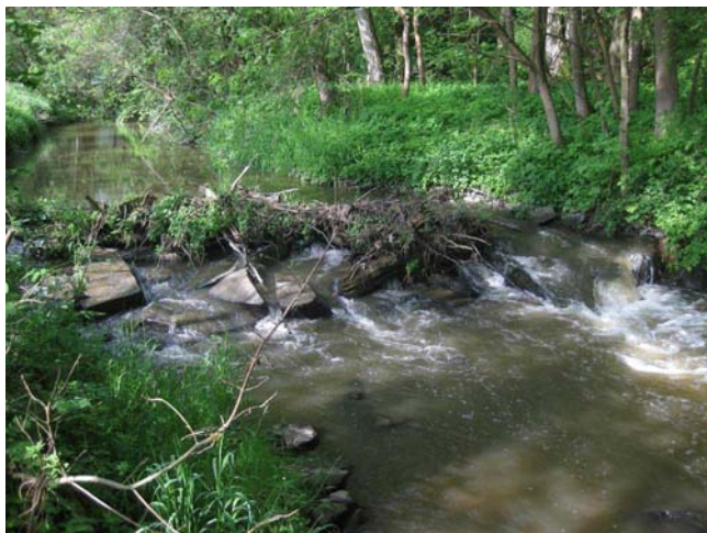
Pohled na stupeň
