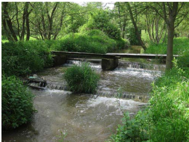
Pohled na stupeň
