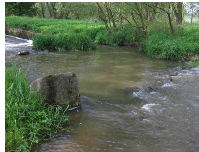
Zpevněný konec podjezí
