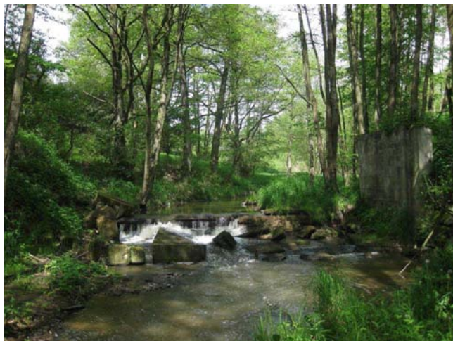
Pohled na stupeň
