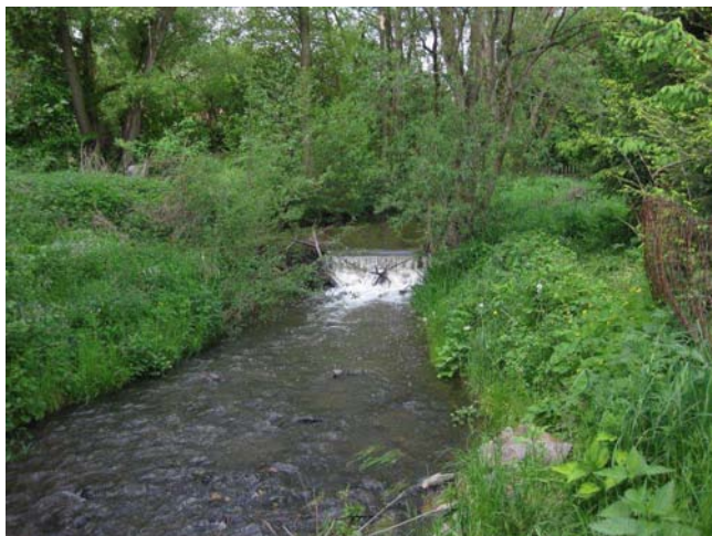
Pohled na stupeň
