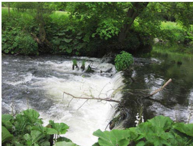
Pohled na jez
