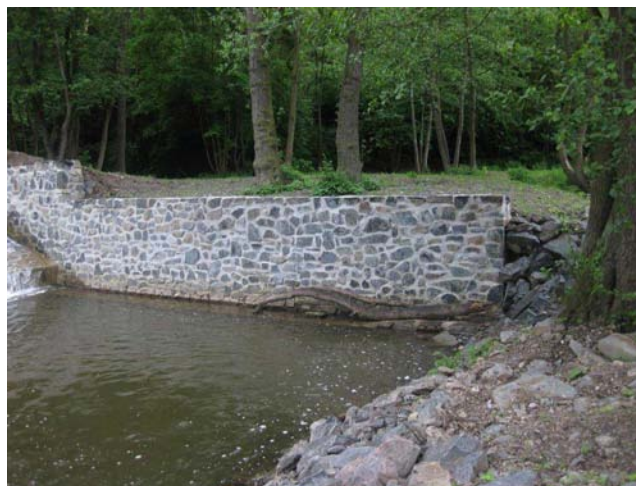
Levý břeh v podjezí – místo zaústění RP
