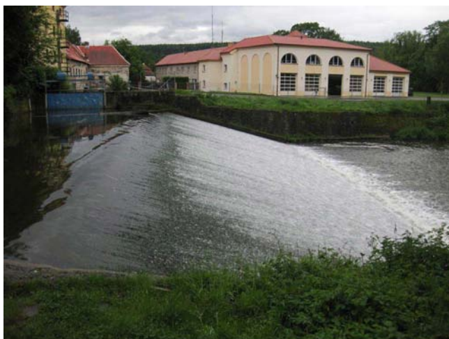
Pohled na korunu a levou stranu jezu se vstupem do náhonu
