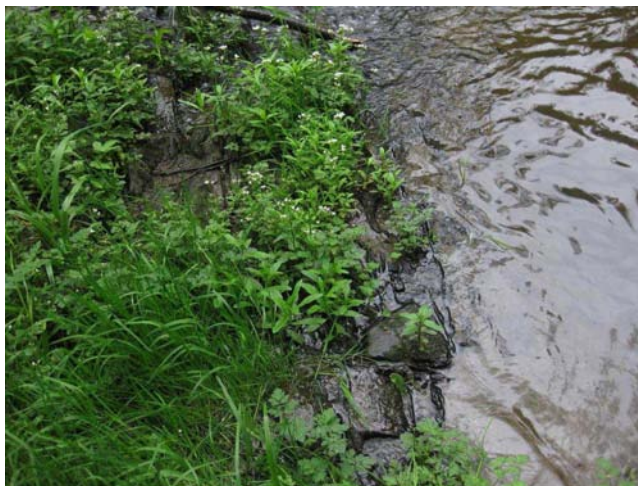
Detail původní konstrukce jezu
