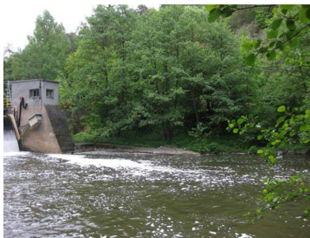
Detail levého podjezí
