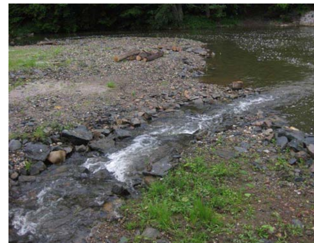
Odlehčovací kanál - zaústění
