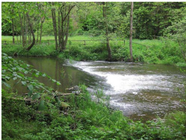
Pohled na jez
