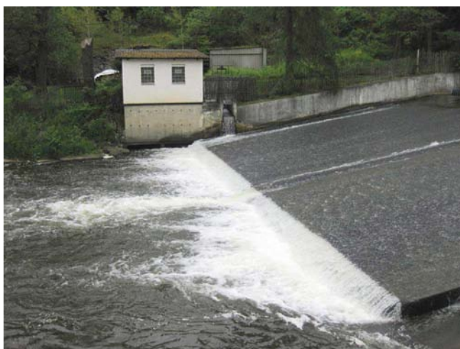
Pohled na jez
