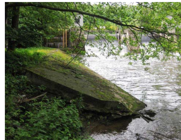
Konec opevnění břehu v podjezí vpravo
