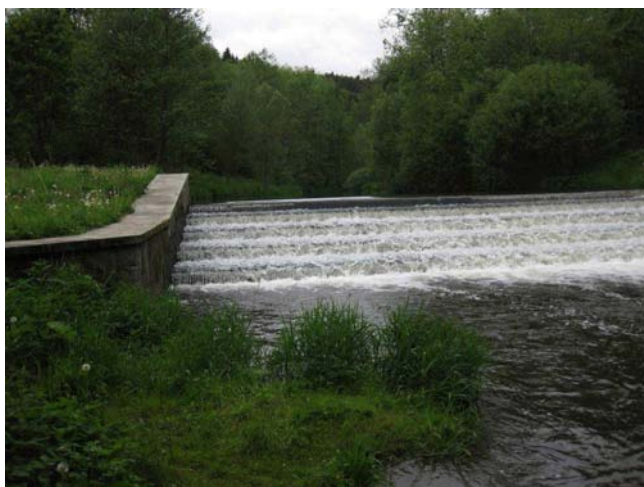
Pohled na jez
