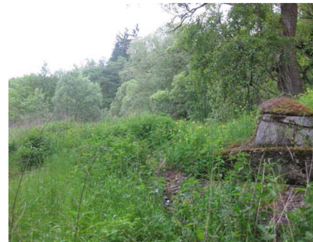
Pravá část bývalého jezu
