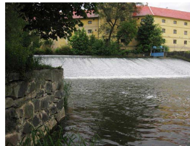
Konec opevnění břehu na pravé straně
