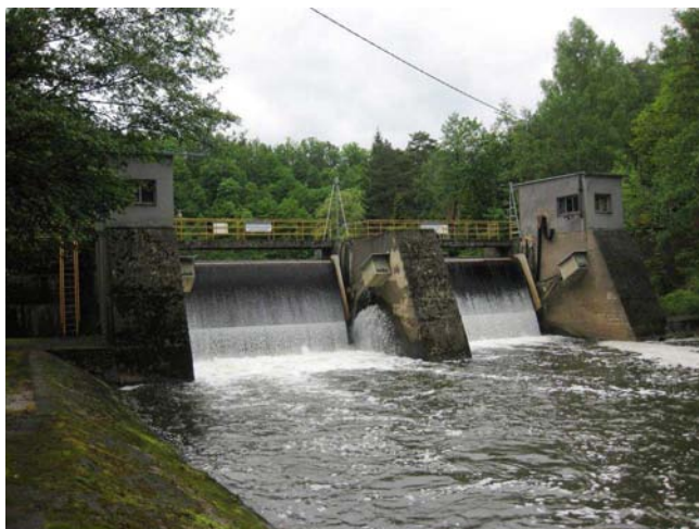
Pohled na jez
