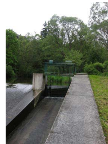
Propust na levé straně jezu
