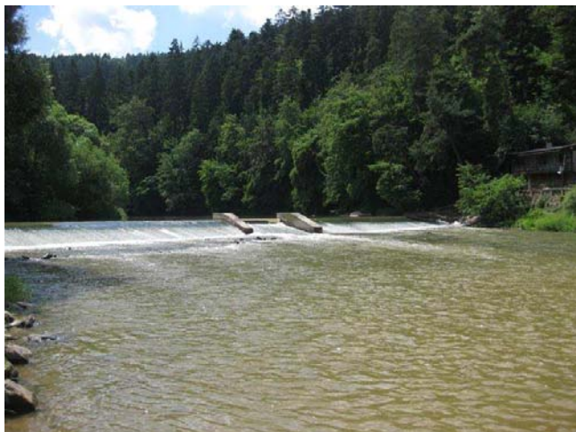
Celkový pohled na jez
