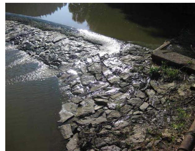
Detail konstrukce jezu
