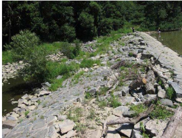
Detail jezového tělesa
