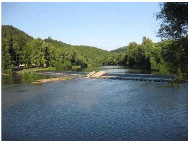
Celkový pohled na jez
