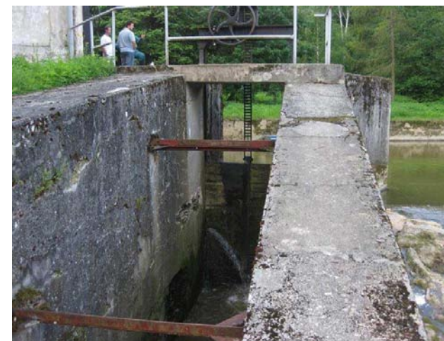
Jalová propust u MVE
