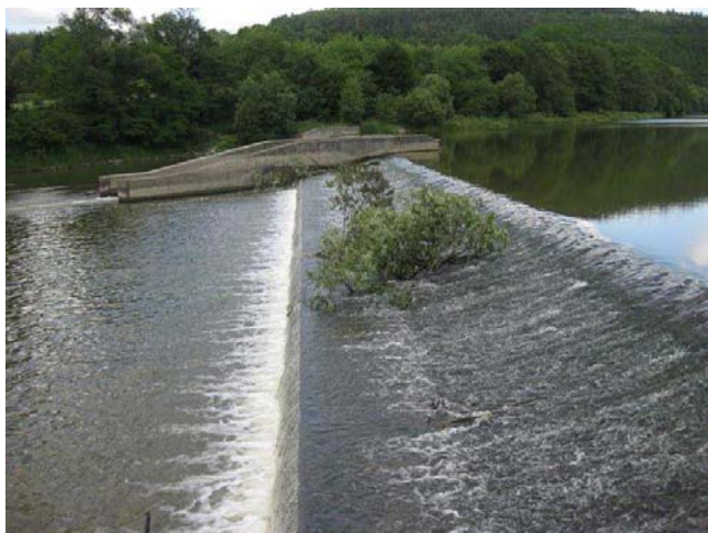
Pohled na jez a propust
