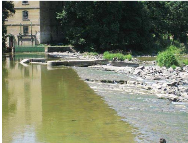
Detail levé strany jezu
