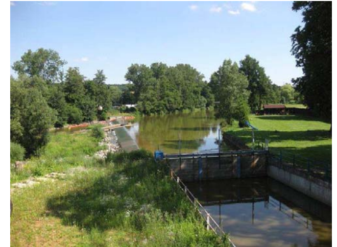
Pohled na jez a stavidlo
