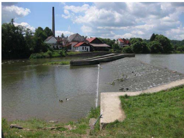
Celkový pohled na jez
