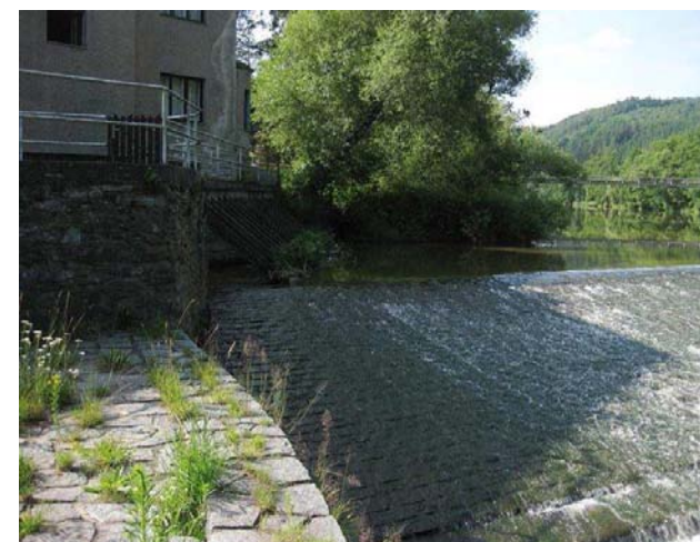
Pravá strana jezu a budova MVE
