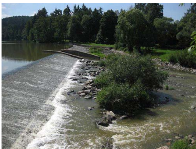
Pohled na jez s propustí uprostřed
