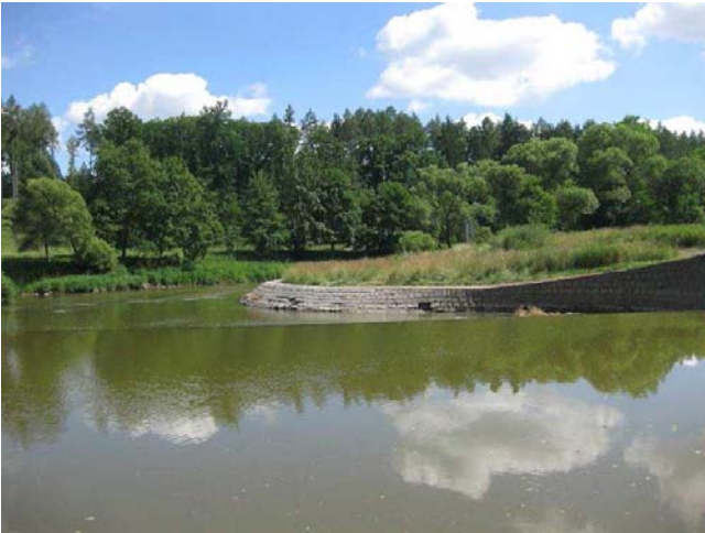
Pohled na podjezí přes jezovou hranu
