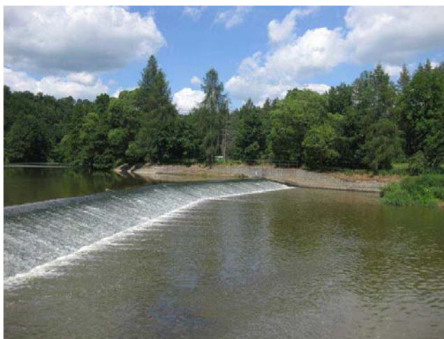
Pohled na jez a levý břeh
