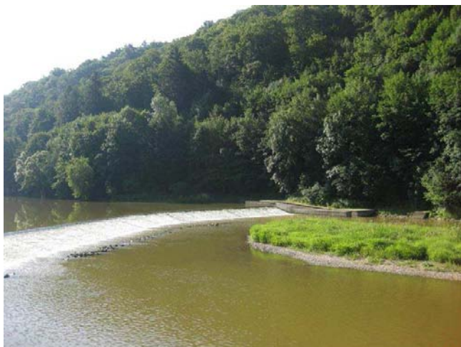
Pohled na levou stranu jezu a propust
