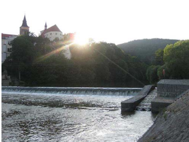
Levá strana jezu s propustí a kartáčovým RP
