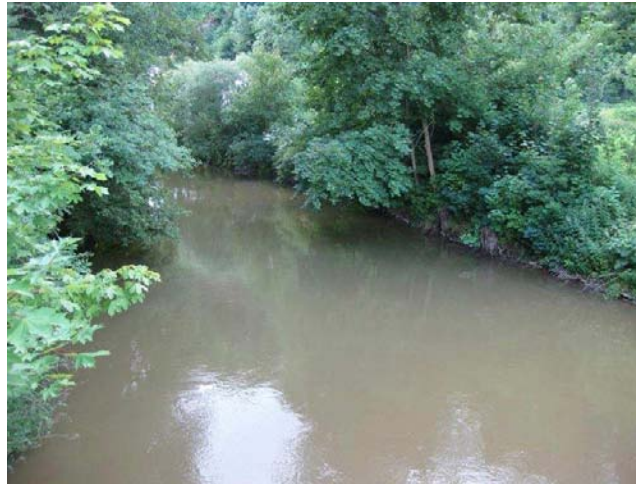
Odpadní kanál z MVE
