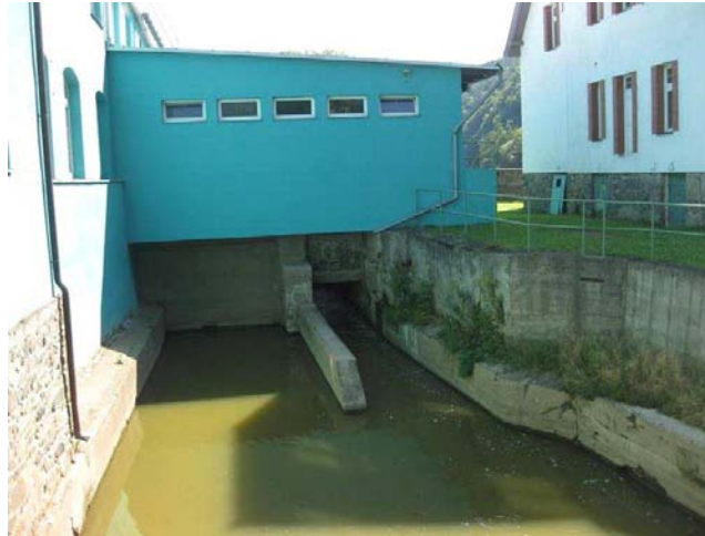
MVE mimo provoz
