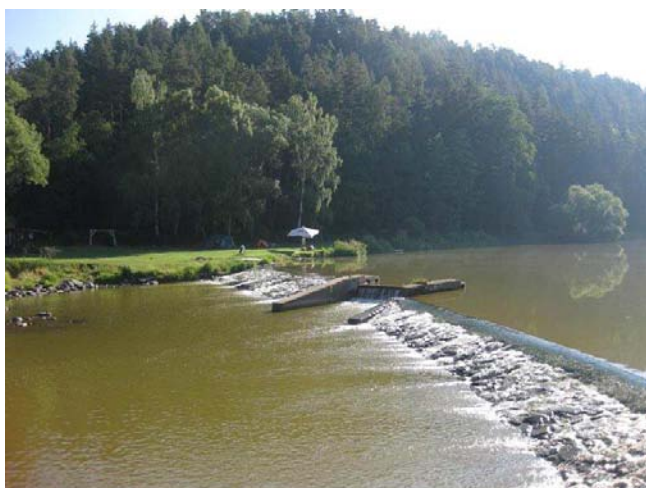
Pohled na jez s propustí
