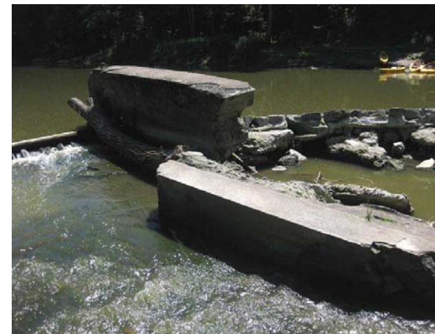
Rozvalená propust
