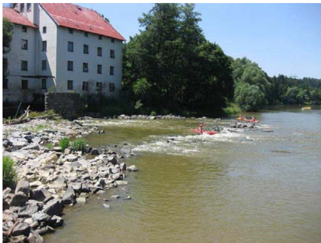
Rozvalená levá strana jezu
