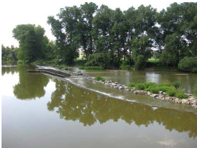
Pohled na jez a levý břeh
