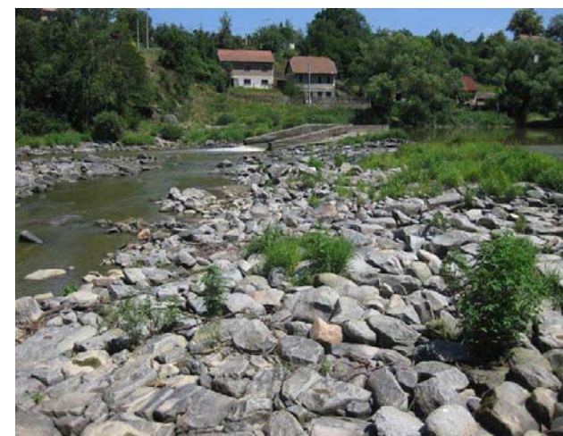
Pohled na jez z levé strany
