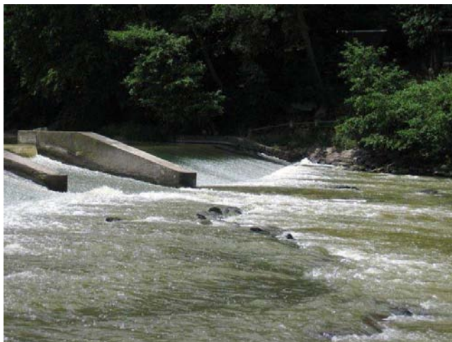
Propust a levá strana jezu
