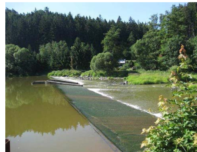
Pohled na jezovou hranu a propust
