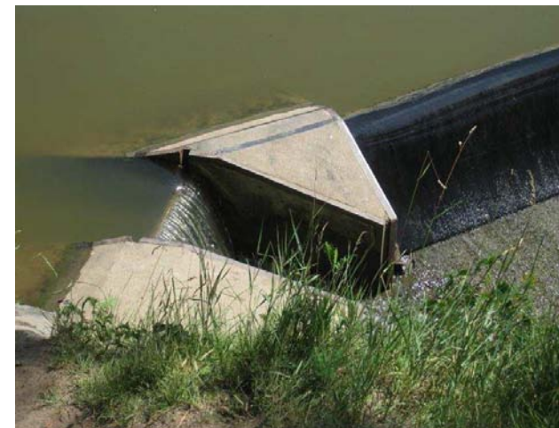
Malá propust na pravé straně
