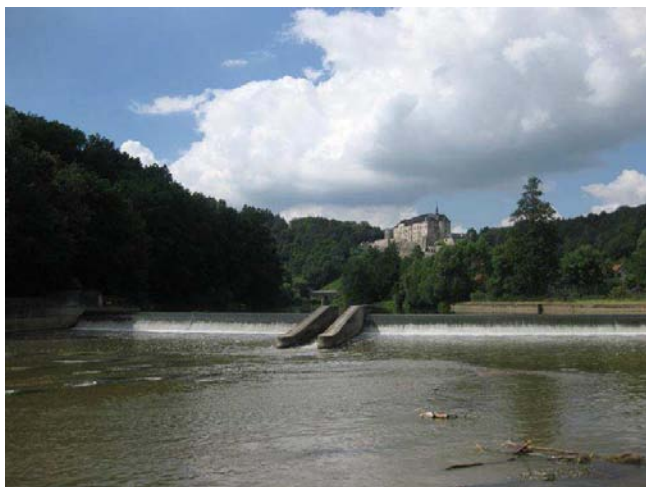
pohled na jez a propust
