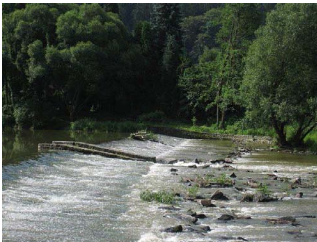
Levá strana jezu s propustí
