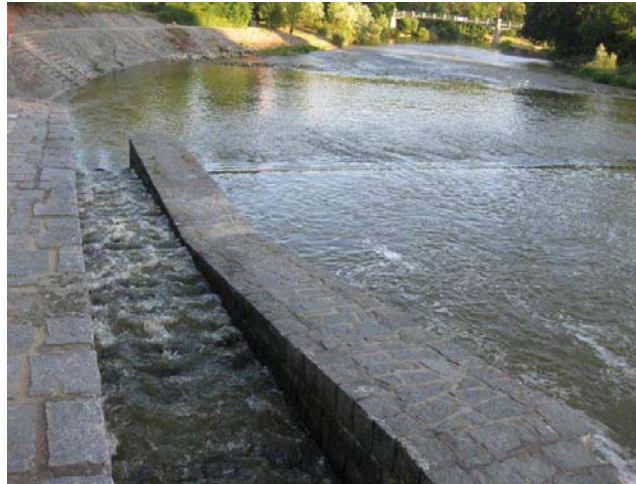
Detail propusti s kartáčovými bloky
