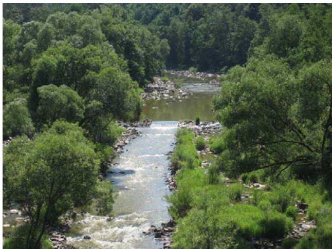
Celkový pohled na jez
