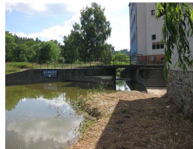
Detail pravé strany s jalovou propustí
