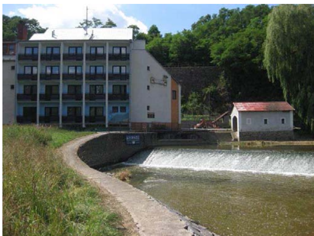
Pravá strana jezu s bývalým mlýnem
