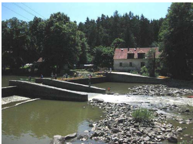
Levá strana jezu a propust
