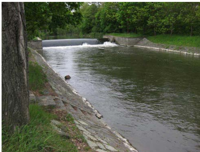
Zpevněné podjezí
