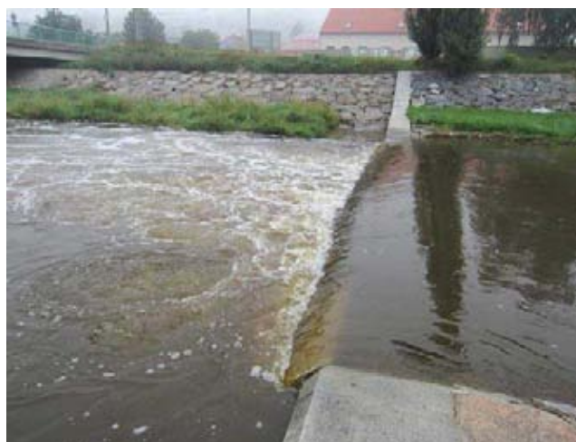
Pohled na stupeň - průtok 10 m 3 /s
