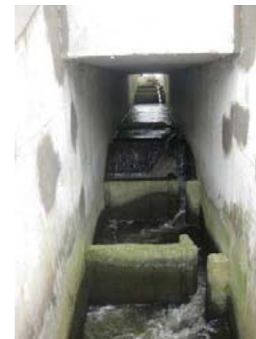
Štěrbinový RP, ucpané štěrbininy
