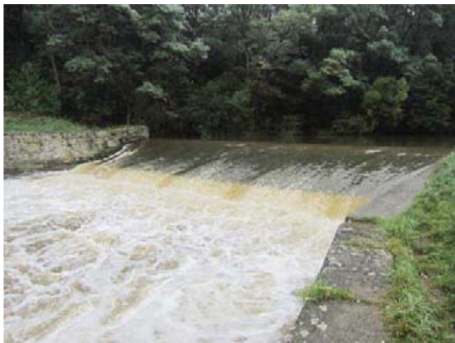
Pohled na jez
