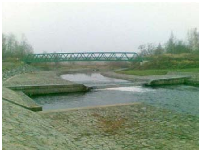
Celkový pohled na stupeň z podjezí
