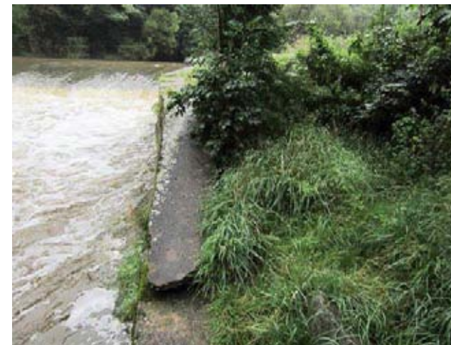
Detail levého břehu
