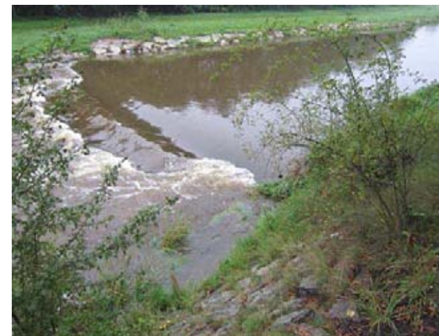
Pohled na stupeň - průtok 10 m3/s
