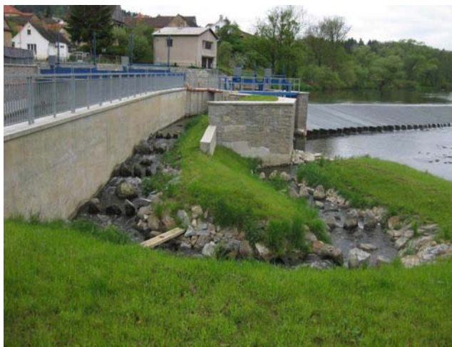
Rybí přechodm nedodržen návrhový průtok
