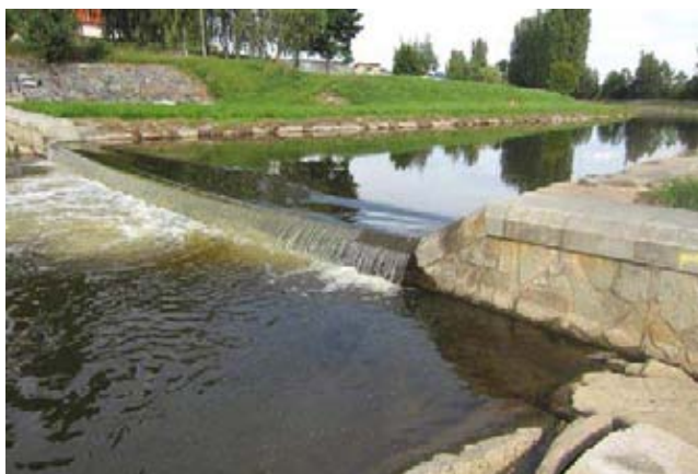
Pohled na stupeň
