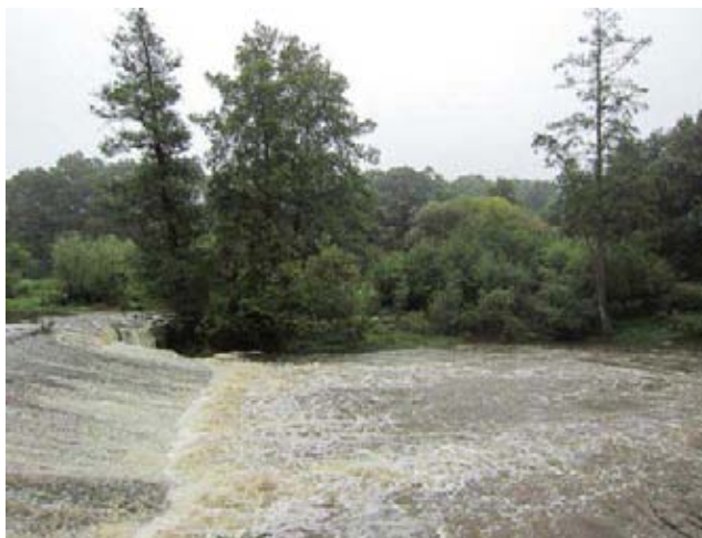
Detail levého břehu
