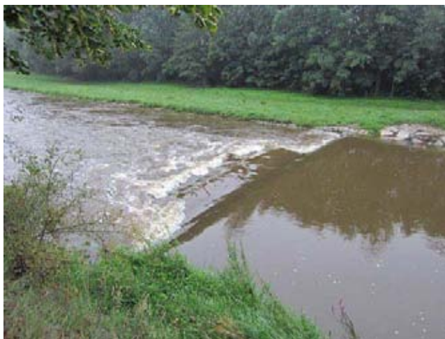
Pohled na stupeň - průtok 10 m3/s
