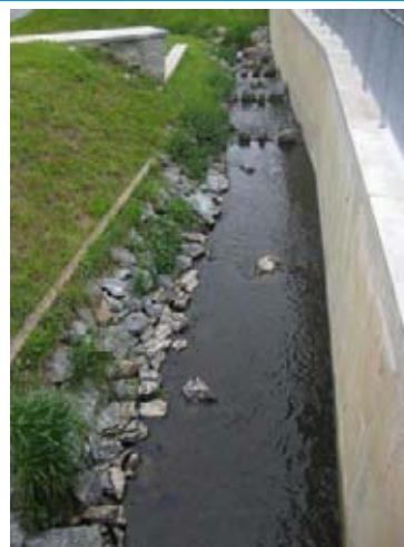
RP s nedostatečným průtokem
