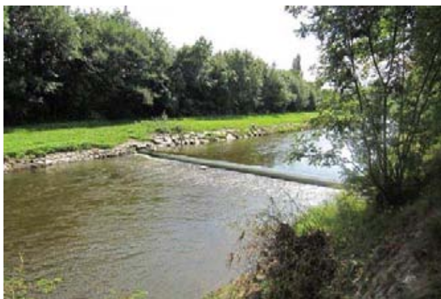
Pohled na stupeň
