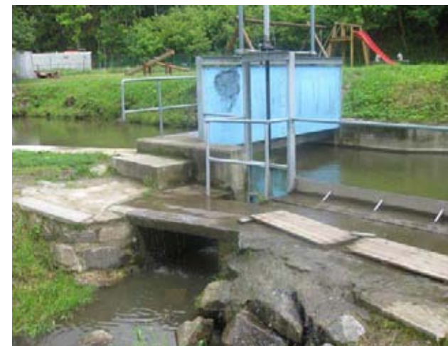
Stavidlo náhonu a odlehčovací kanál
