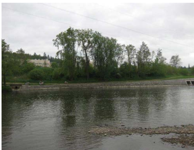
Zpevněné břehy v podjezí a vyústění kanalizace
