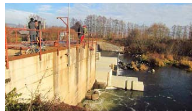
Detail výtoku z MVE a podjezí
