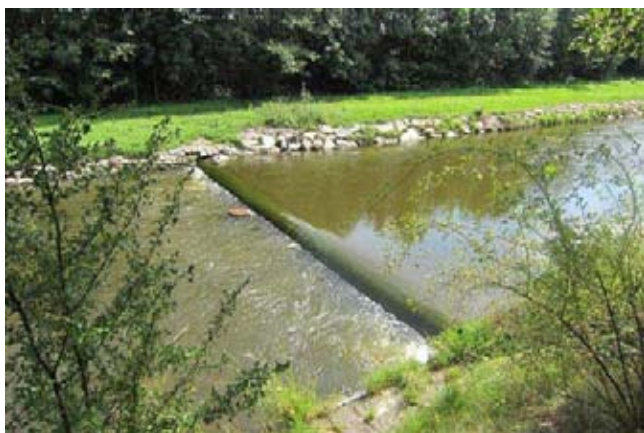
Pohled na stupeň
