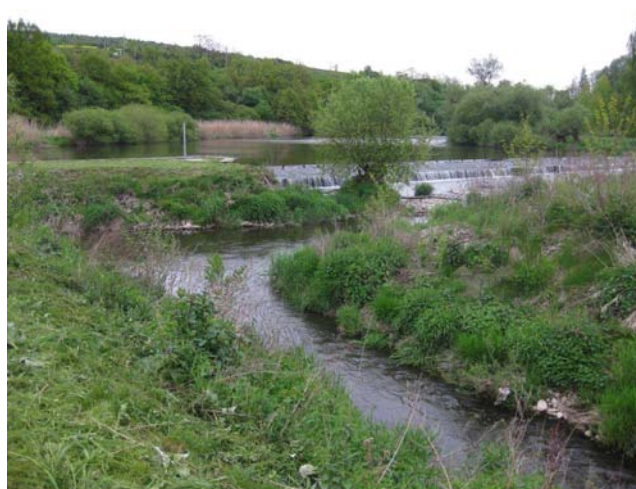
Vstup do RP na jezu, špatné řešení
