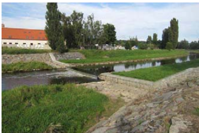
Pohled na stupeň
