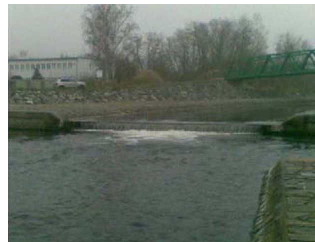
Detail hrany stupně
