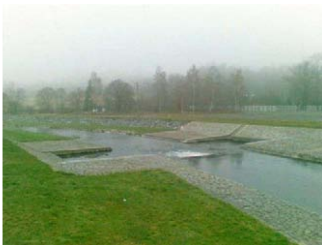
pohled z lávky nad stupněm
