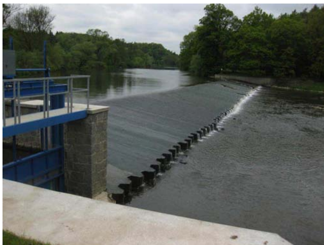
Pohled na jez, koruna nižší u levého břehu
