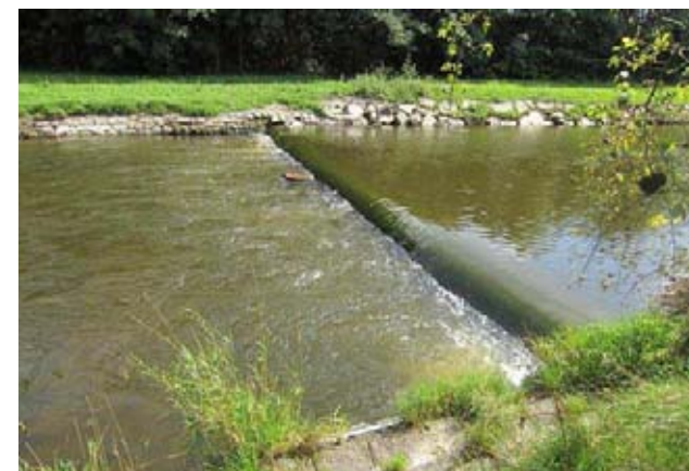
Pohled na stupeň
