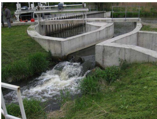
Výstup z RP, pravděpodobně neprůchodný
