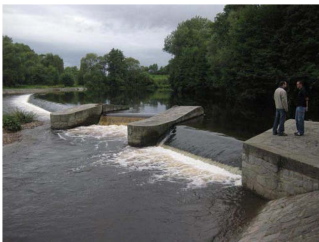
Pohled na jez
