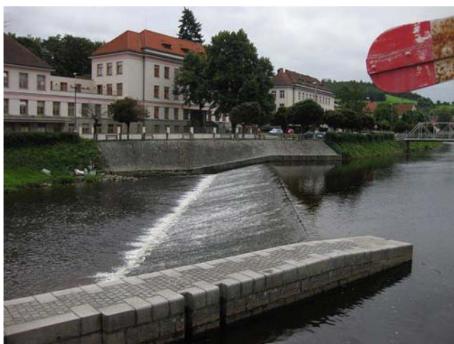
Detail pravého břehu
