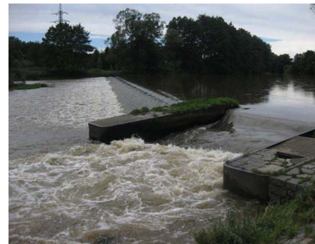
Pohled na jez a propust
