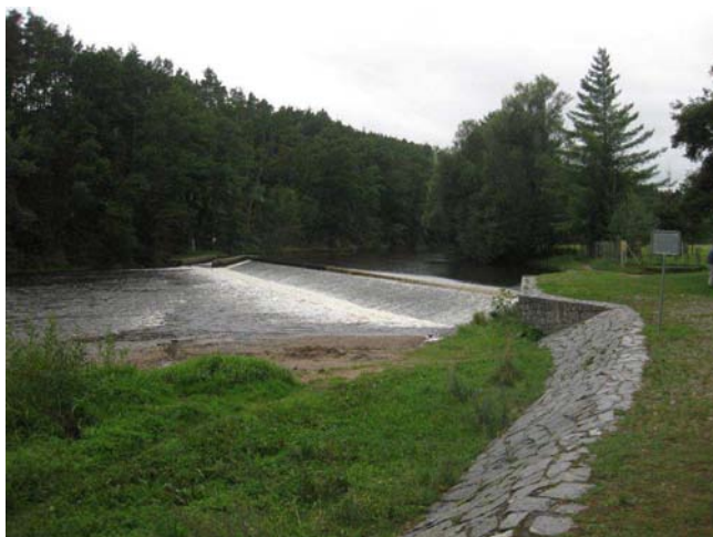
Pohled na jez
