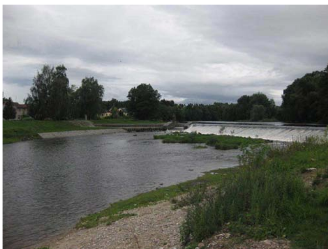
Pohled na jez
