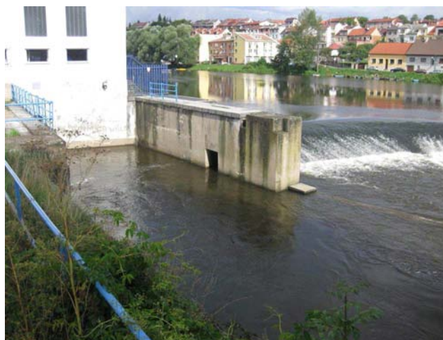
Pohled na výtok z MVE
