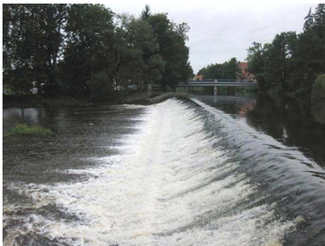
Pohled na jez
