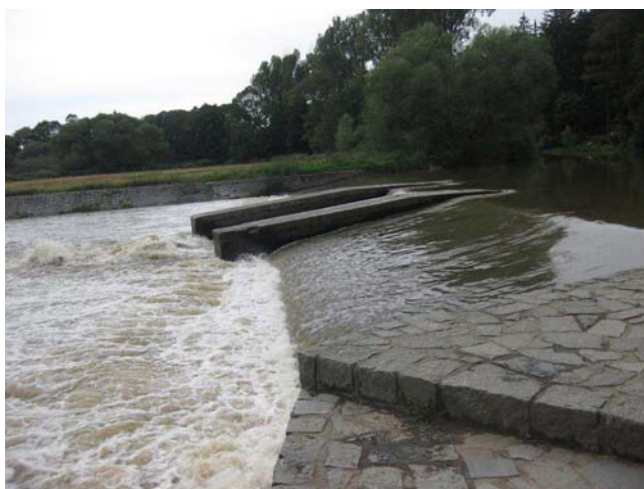
Pohled na jez a vodácký oblíbenou propust
