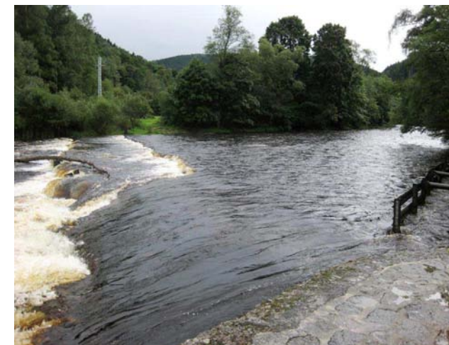
Pohled na jez, pravá strana migračně průchodná
