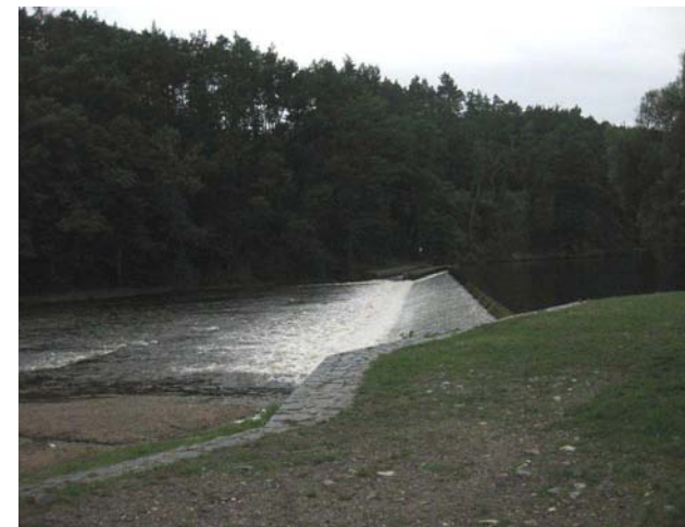
Pohled na jez z levého břehu
