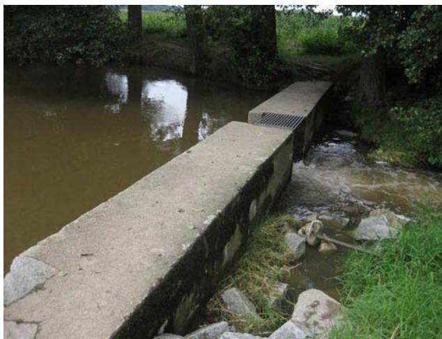
Vstup do náhonu s asanačním průtokem, napájí rybník
