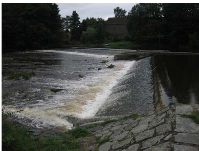
Pohled na jez z levého břehu
