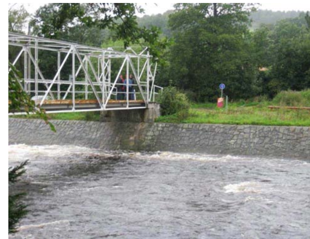
Levý břeh s opevněním
