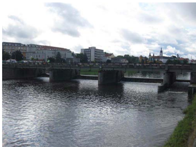
Pohled na jez
