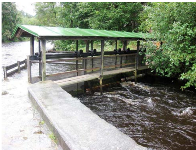
Stavidlo na vstupu do náhonu
