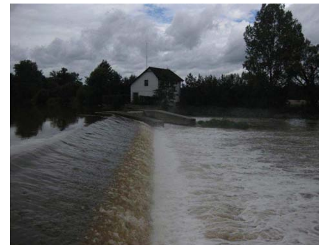
Pohled na jez levořežní MVE z pravého břehu
