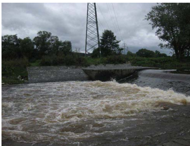
Detail pravého břehu
