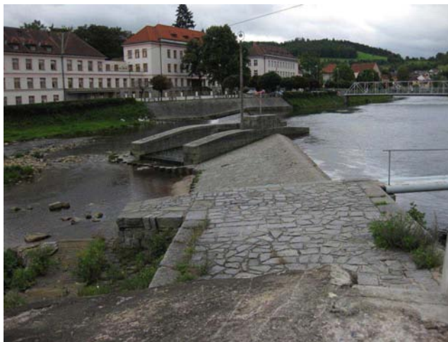
Pohled na jez, detail propusti s klapkou
