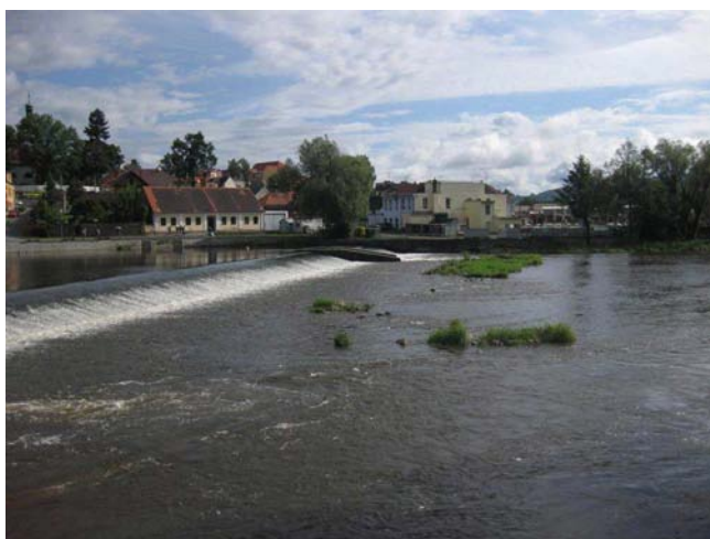
Pohled na jez
