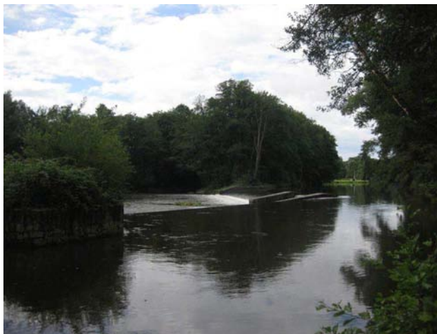
Pohled na jez z levého břehu
