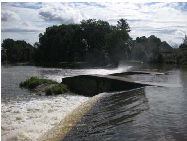
Pohled na jez
