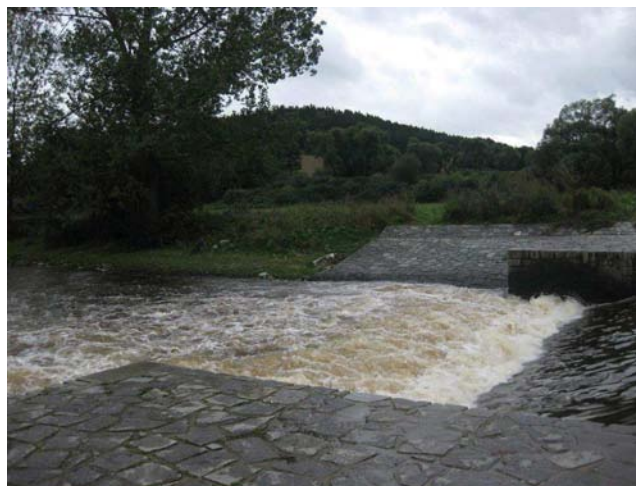
Pohled na jez z levé strany
