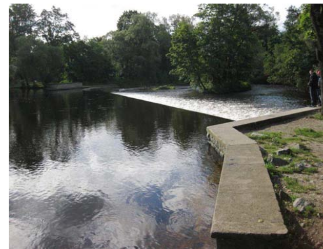
Pohled na jez
