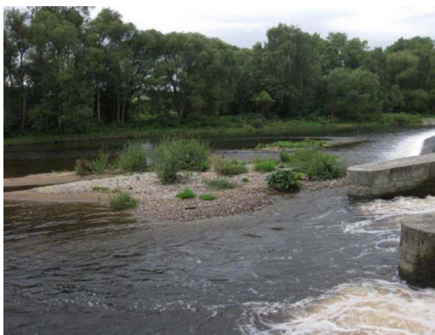
Detail nánosů v podjezí
