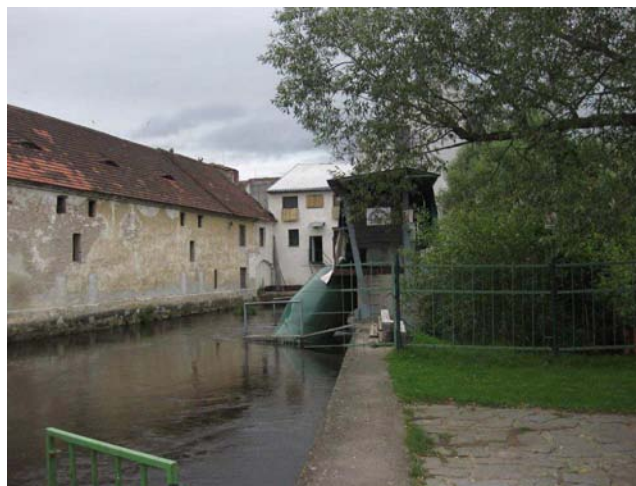
Pohled na nátok na MVE
