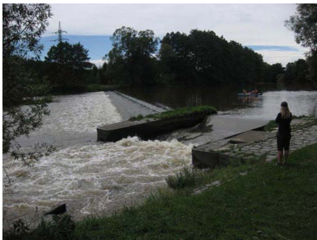
Pohled na jez
