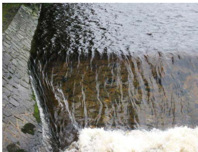
Detail přelivné hrany a břehu na pravé straně
