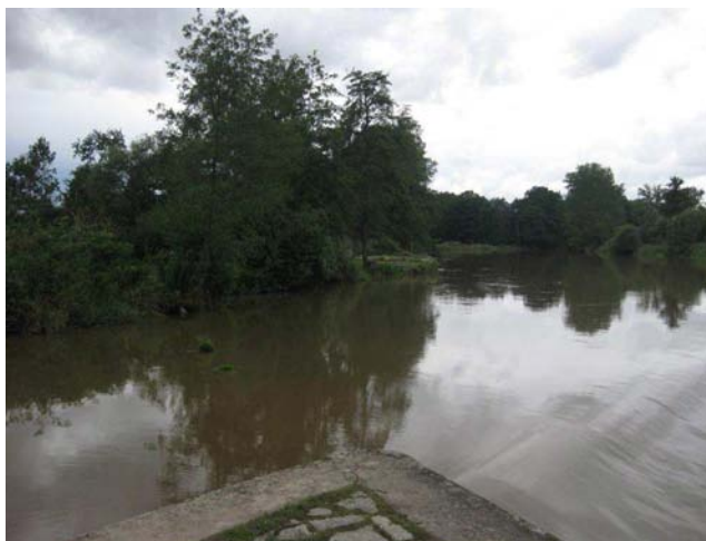
Nadjezí na pravé straně, vlevo nátok na MVE
