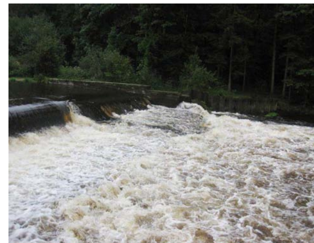
Detail levé části zpevněné larzenovou stěnou
