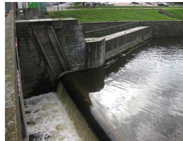
koruna jezu v pravé části a nátok na MVE
