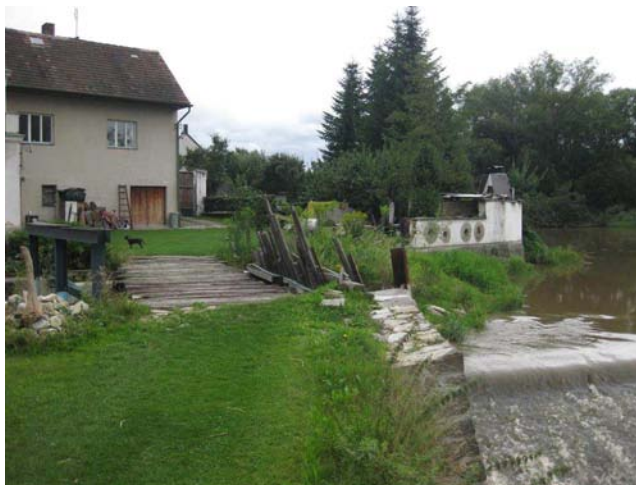
Zahrazený vtok do náhonu k pravobřežní MVE
