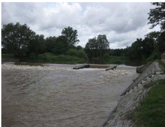
Pohled na jez z levého břehu
