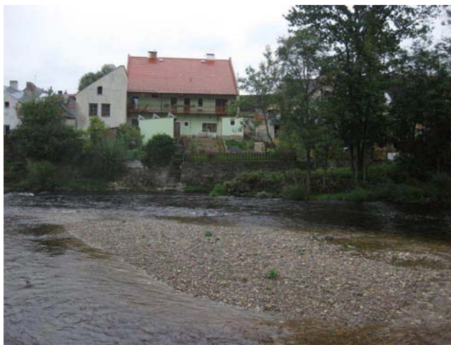
Detail pravého břehu s odpadem MVE f.Hemazi
