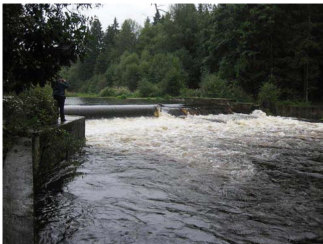
Pohled na jez, v pravé části vak, uprostřed snížení hrany jezu
