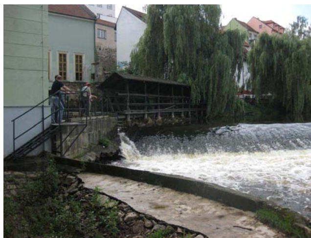
Pohled na pravou stranu jezu a vtok na MVE
