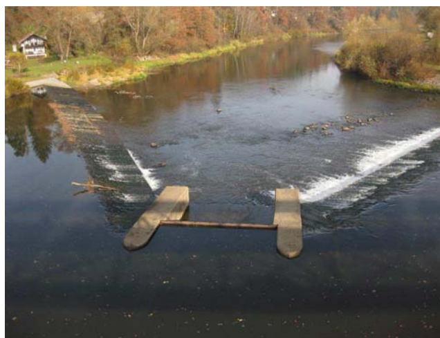
Pohled na jez z lávky, uprostřed vorová propust
