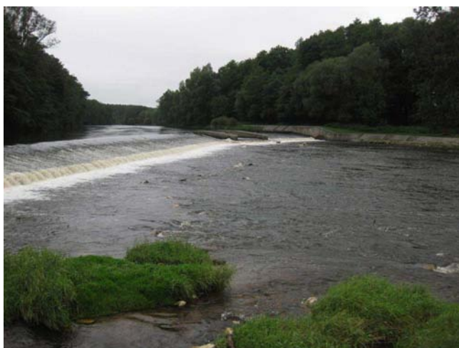
Pohled na jez s vorovou propustí
