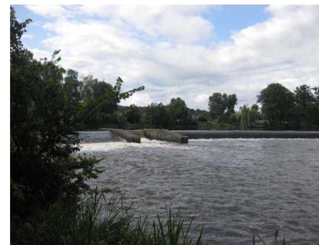
Pohled na jez a vorovou propust, z pravého břehu
