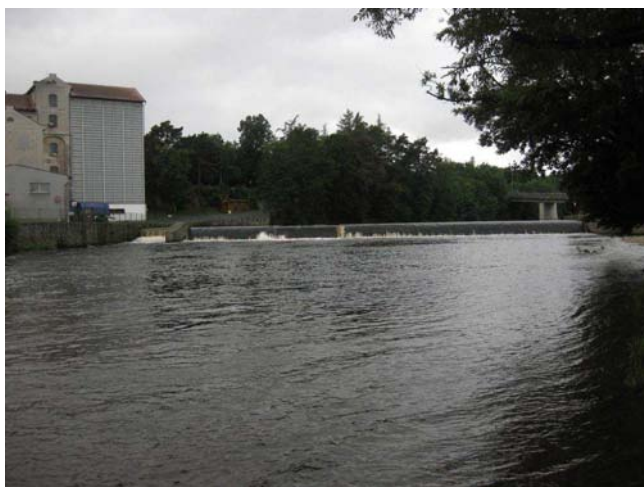
Pohled na jez
