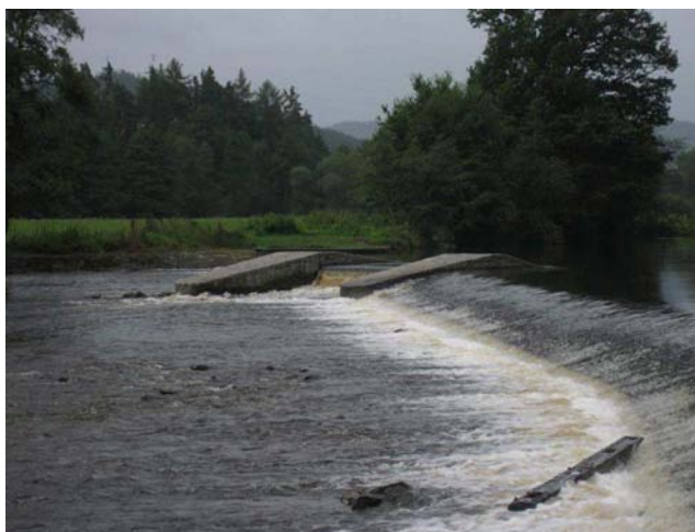
Detail pravého břehu a vorové propusti
