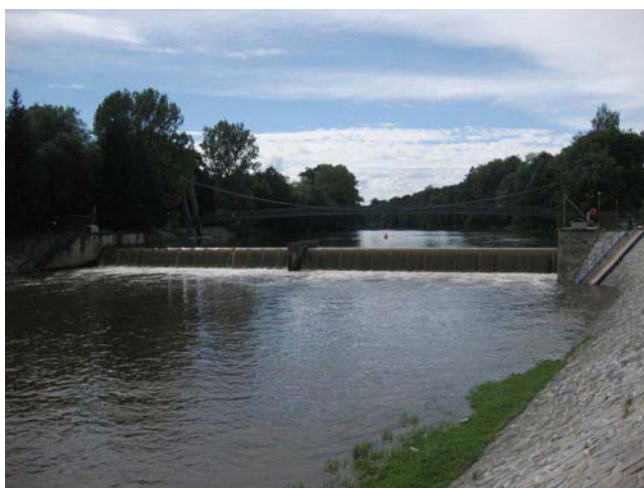
Pohled na jez
