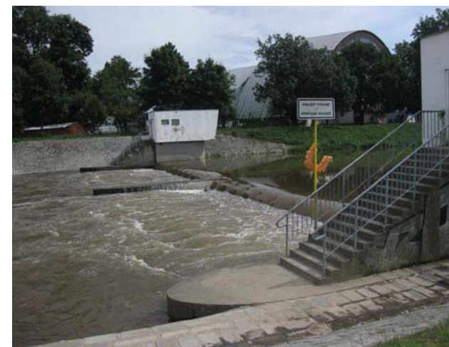
Pohled na jez z levého břehu
