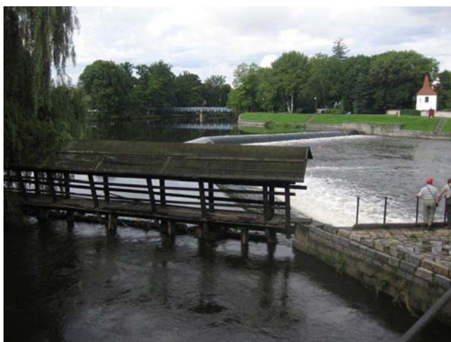
Pohled na jez od MVE
