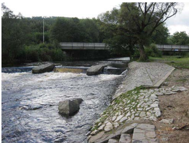
Pohled na levý břeh s propustí
