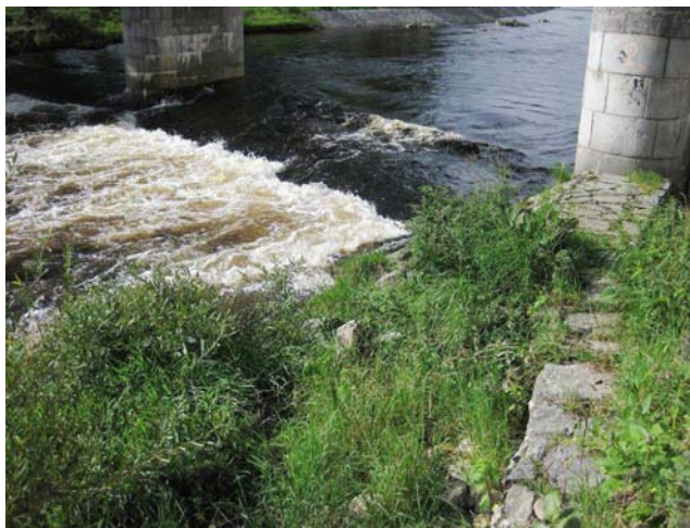
Detail levé strany stupně "Špak"
