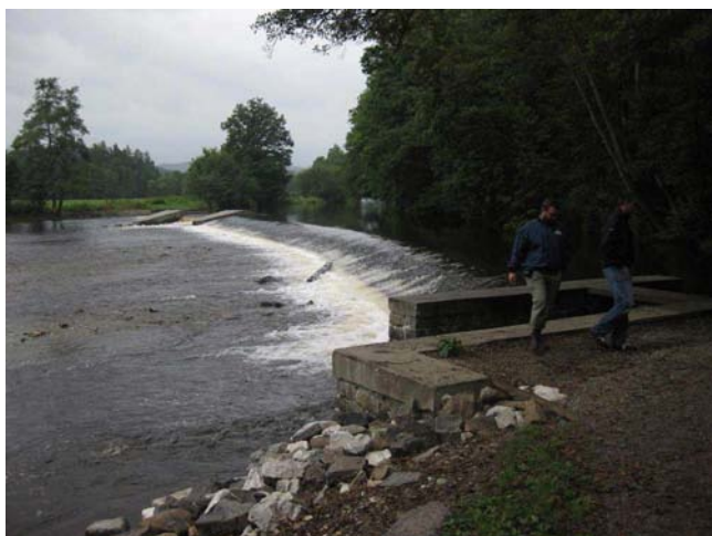
Pohled na jez z levého břehu, u břehu štěrková propust
