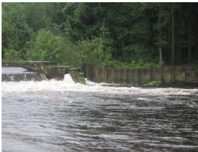
Detail levé části zpevněné larzenovou stěnou
