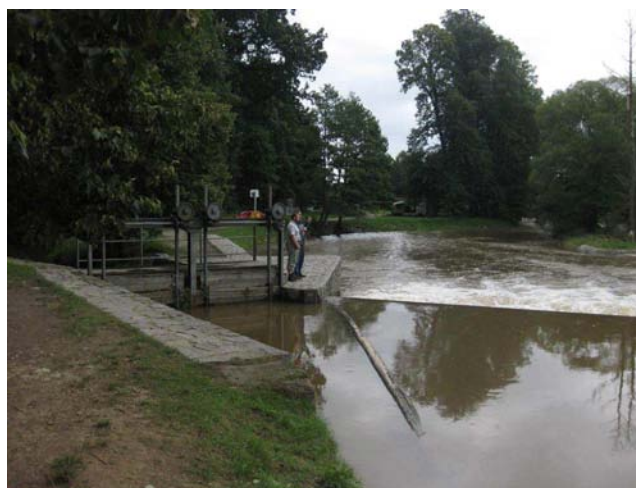
Pohled na stavidlo a jez
