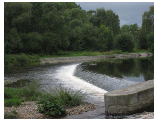
Detail pravého břehu
