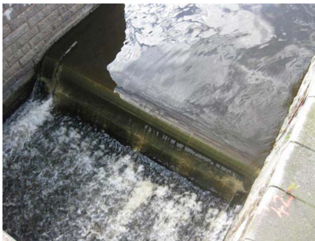
Pohled na propust hrazení propusti
