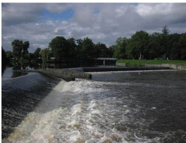
Pohled na jez z pravého břehu
