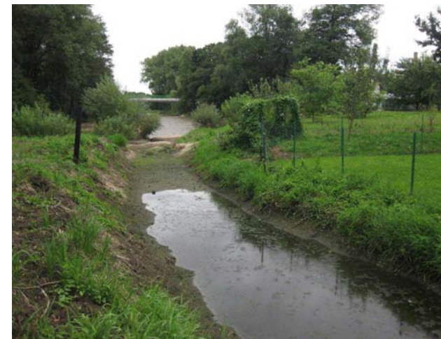
Zanesený odpadní kanál od pravobřežní MVE
