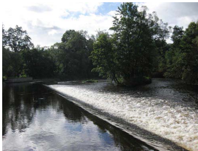
Pohled na jez
