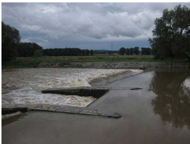
Pohled na jez
