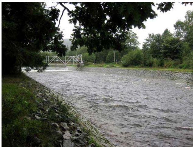
Pohled na jez
