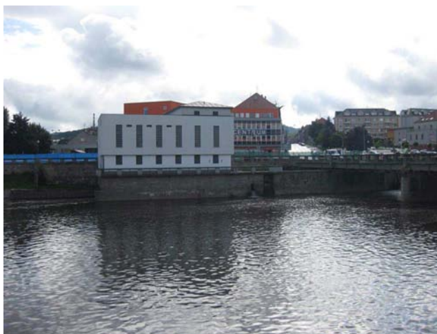
Pohled na MVE na pravém břehu
