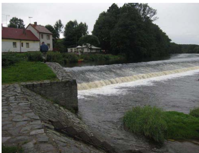
Pohled na jez z pravého břehu, vlevo náhon k MVE
