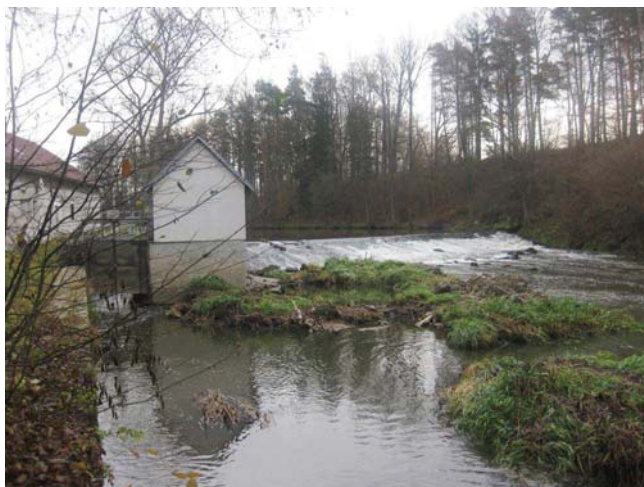
Pohled na jez s objektem MVE
