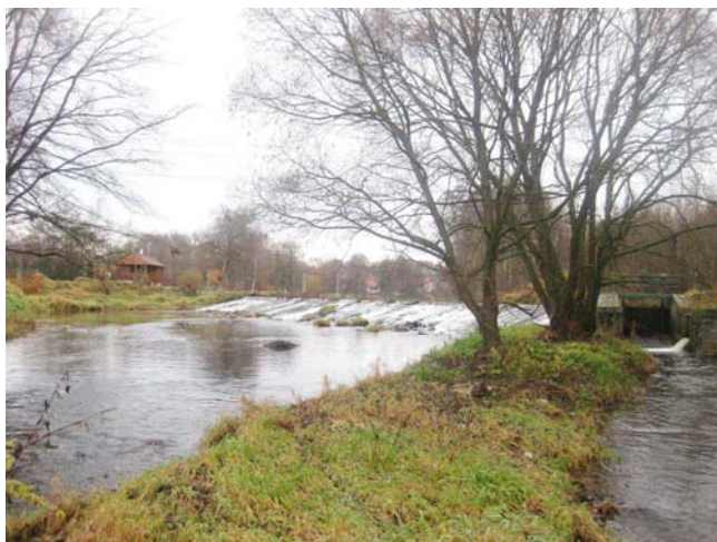
Pohled na jez, na levé straně proplachovací propust
