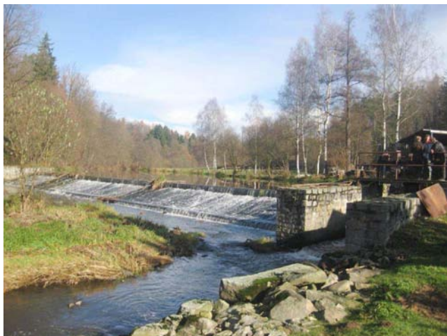
Celkový pohled na jez
