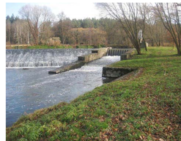
Propust s klapkou
