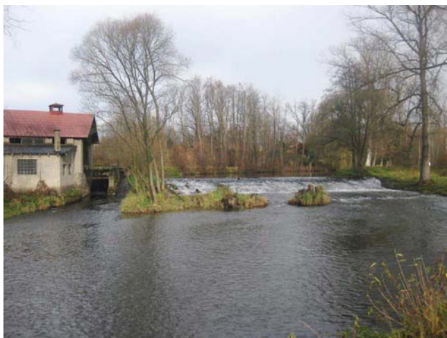
Pohled na jez s objektem MVE
