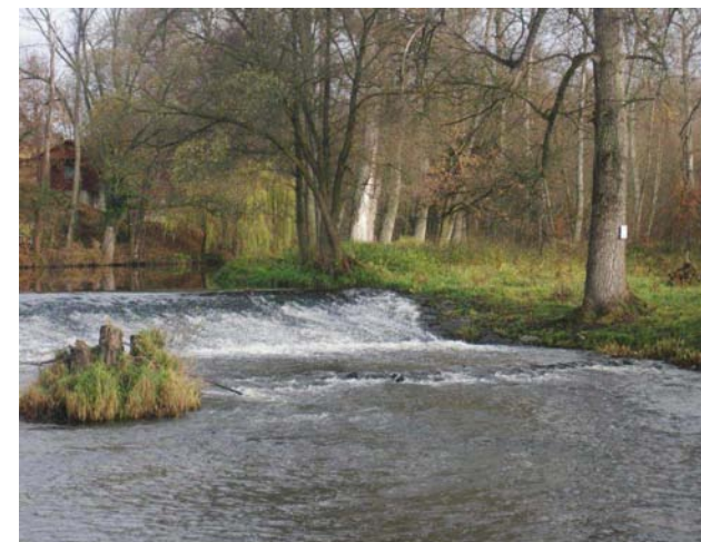
Detail levé strany jezu
