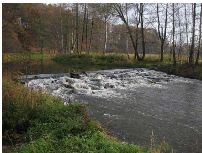
Celkový pohled na jez
