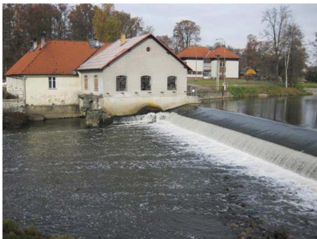
Pohled na pravou stranu jezu s objektem nefunkční MVE
