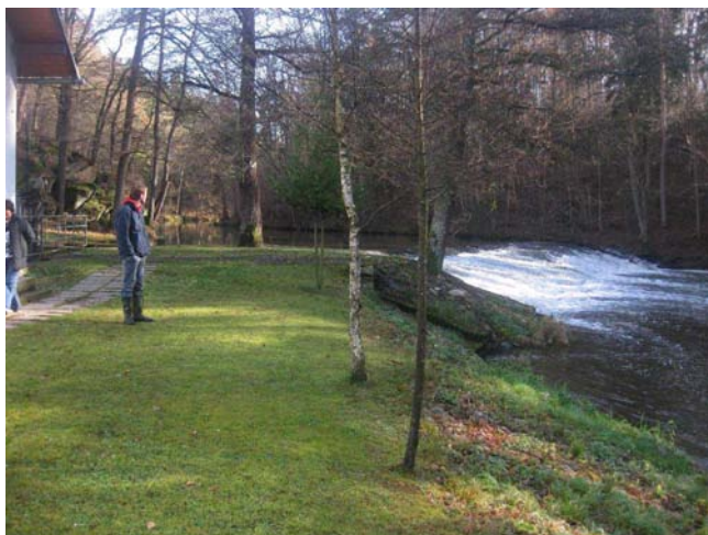
Pohled na jez s pravým břehem
