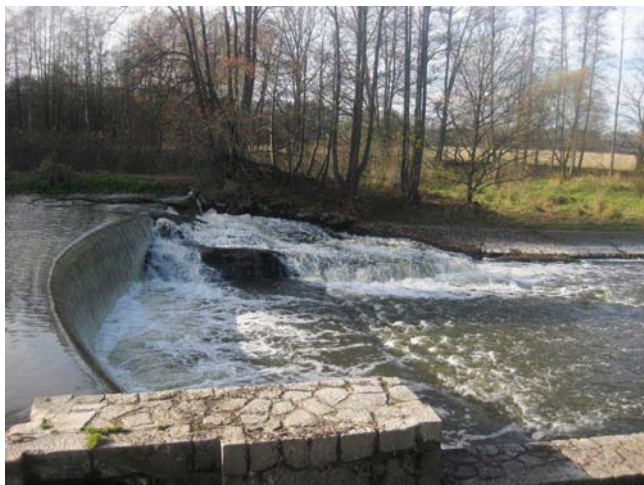
Pohled na jez, na levé straně balvanitý stupeň
