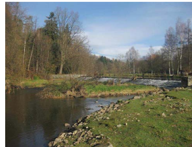
Podjezí se zapojenými nánosy
