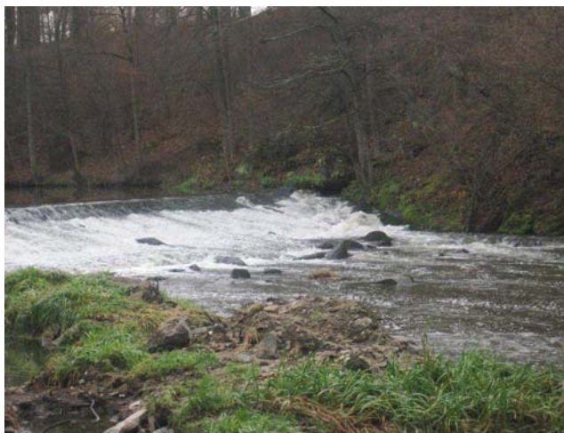
Detail levé strany jezu
