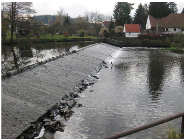
Pohled na jez s náplatkami z pravého břehu
