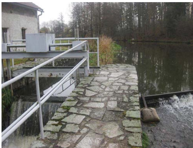
Pravý břeh s propustí
