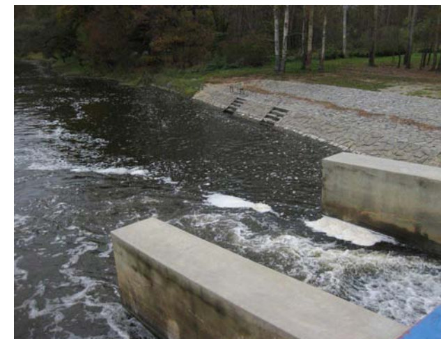
Pohled na pravý břeh a konec propusti
