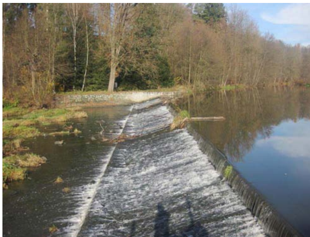
Detail jezové hrany
