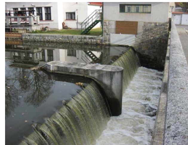
Detail jezové hrany a silničního mostu
