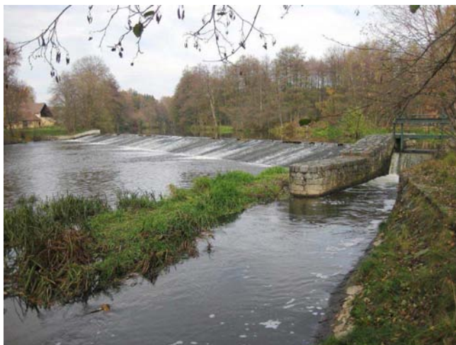
Celkový pohled na jez
