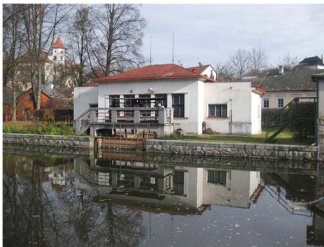
Objekt MVE na levém břehu
