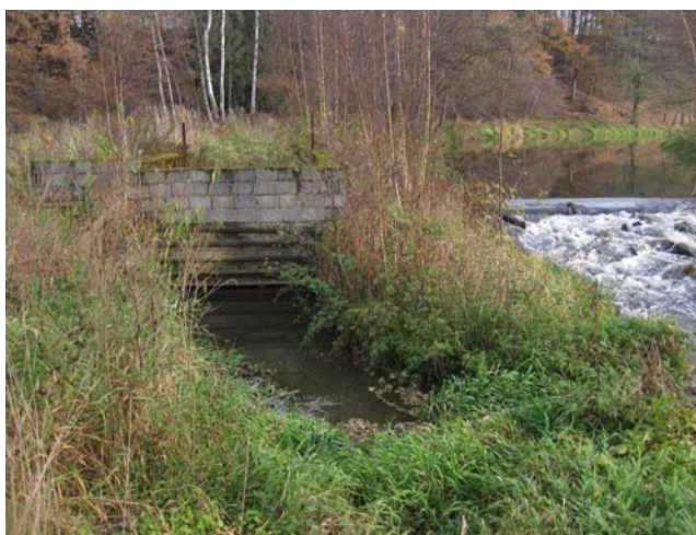
Pohled na rozestavěnou MVE
