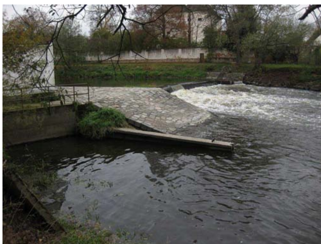
Celkový pohled na jez
