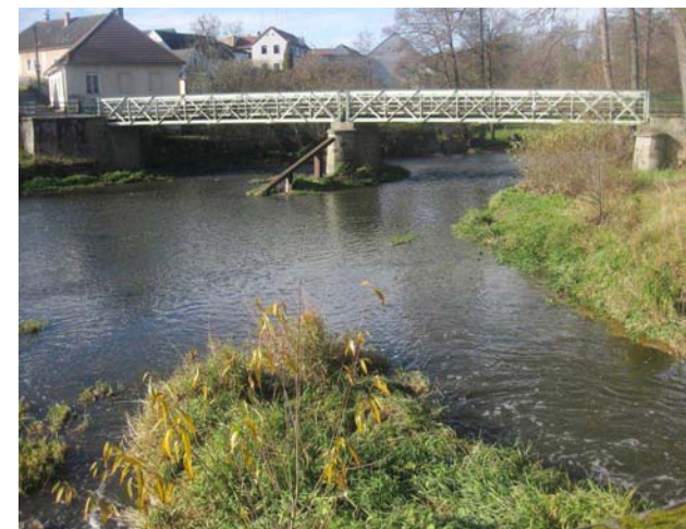
Soutok toku a odpadního kanálu z MVE
