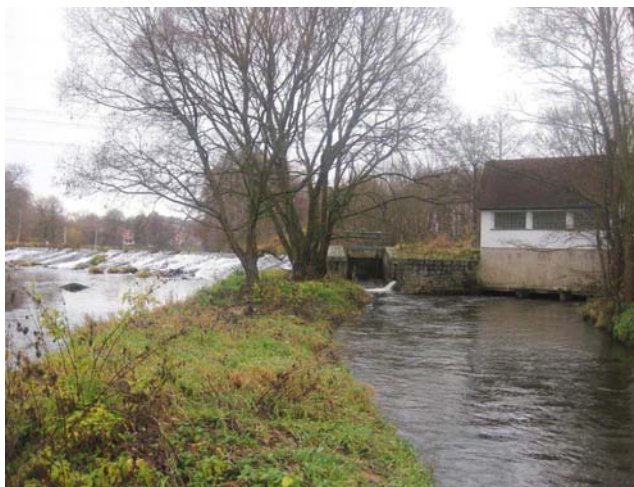
Odpadní kanál a objekt MVE
