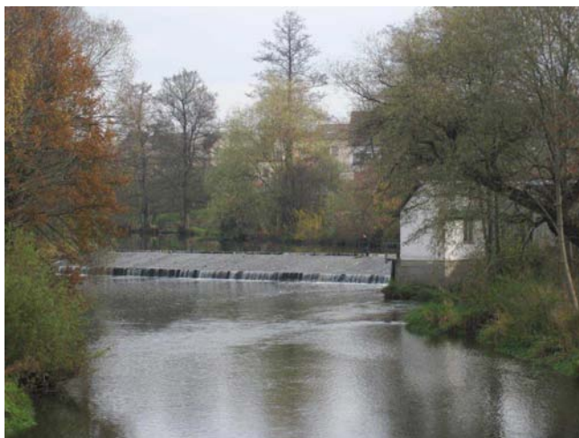
Pohled na jez ze silničního mostu
