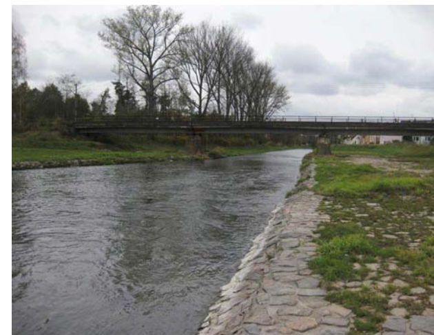
Charakter toku pod jezem s břehovým opevněním
