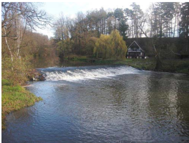
Celkový pohled na jez
