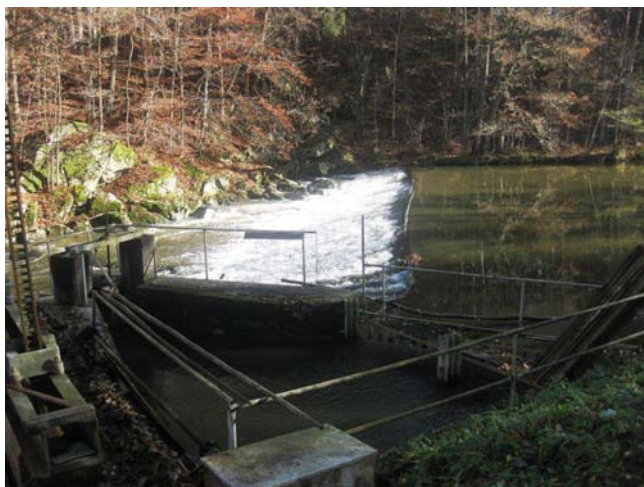
Celkový pohled na jez
