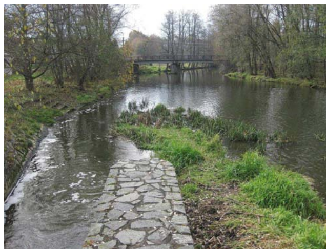
Pilíř mezi jezem a propustí
