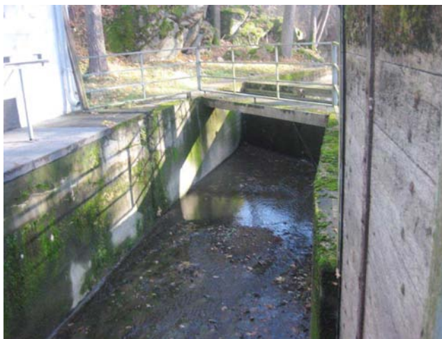
Odpadní kanál z bývalé MVE
