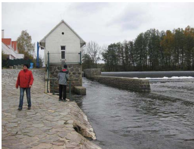
Pohled na objekt MVE a propust
