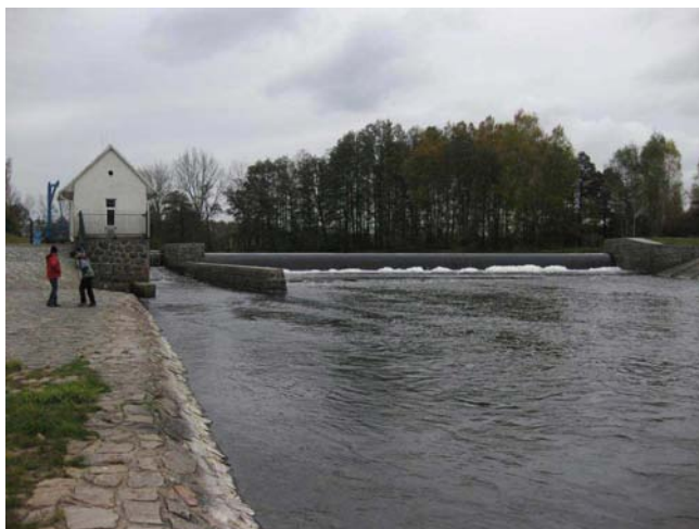
Celkový pohled na jez
