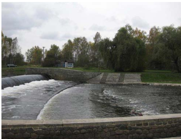
Pohled na stupeň a levý břeh v podjezí
