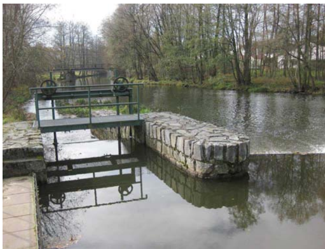
Proplachovací propust na jezu
