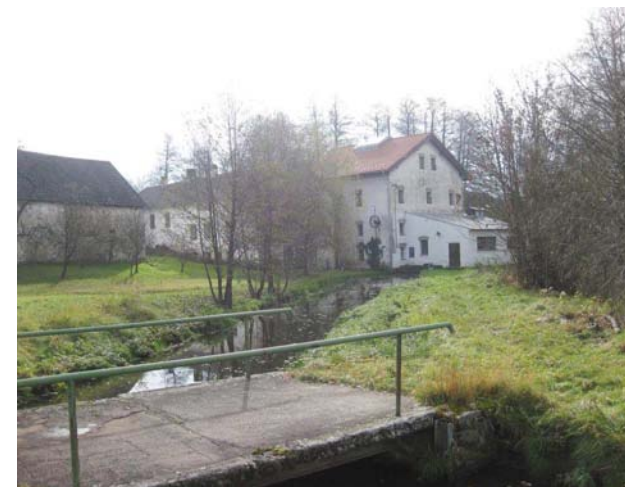
Náhon a objekt MVE
