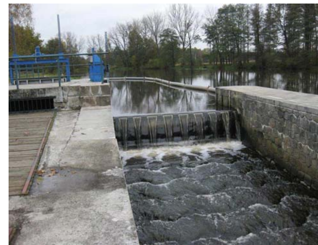
Vorová propust s osazenou klapkou
