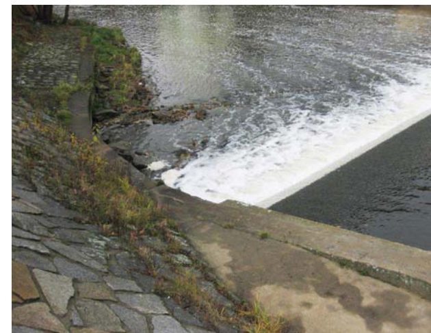
Opevnění levého břehu
