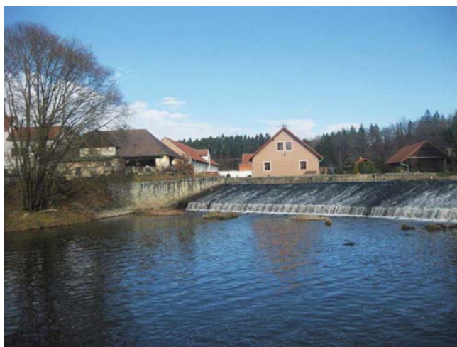
Pohled na pravou část jezu
