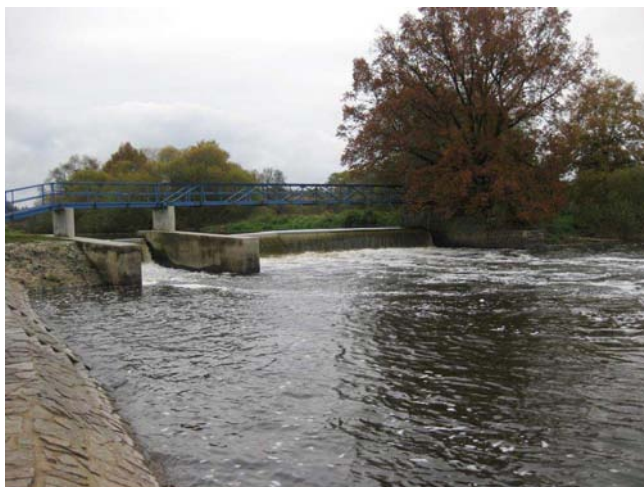
Pohled na pravou stranu jezu a propust
