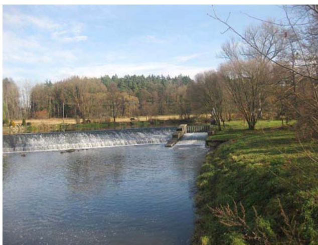
Pohled na levou část jezu s propustí
