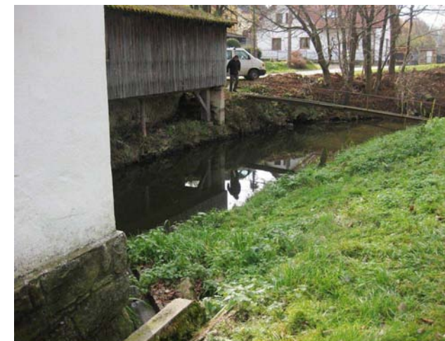
Odpad z MVE
