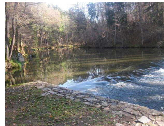
Opevnění pravého břehu v místě jezu
