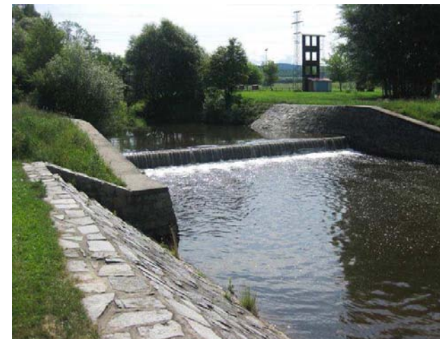
Detail opevnění pravého břehu
