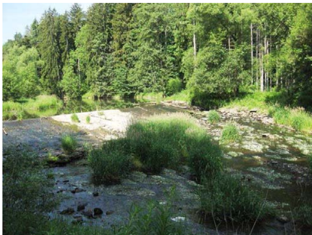
Celkový pohled na jez
