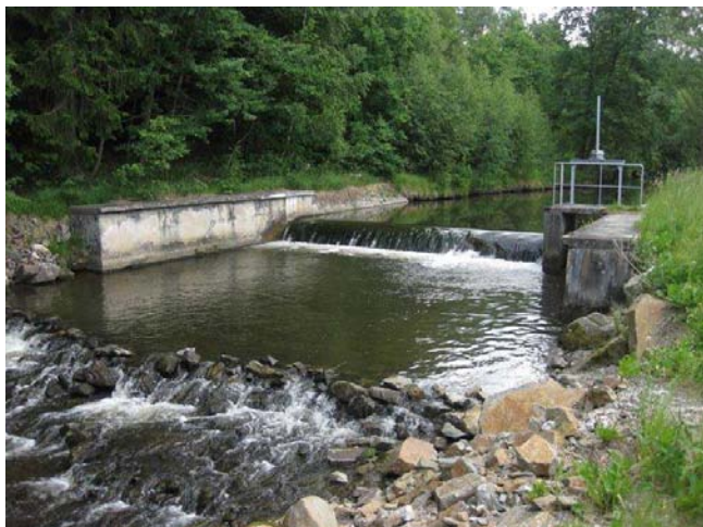
Celkový pohled na jez
