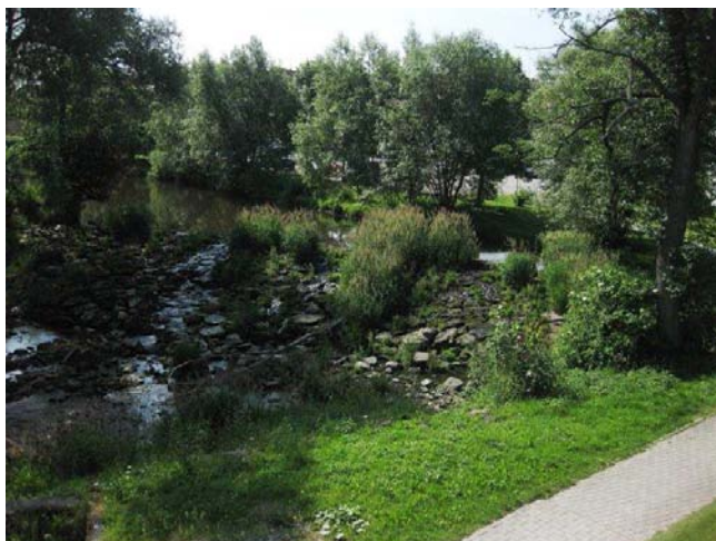
Celkový pohled na jez
