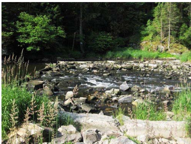
Celkový pohled na jez
