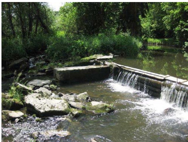
Celkový pohled na jez
