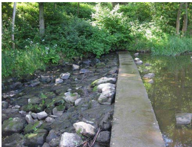
Detail jezové hrany
