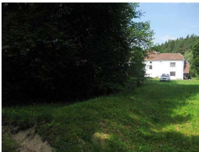
Objekt bývalého Brouskova mlýna se zazemněným náhonem
