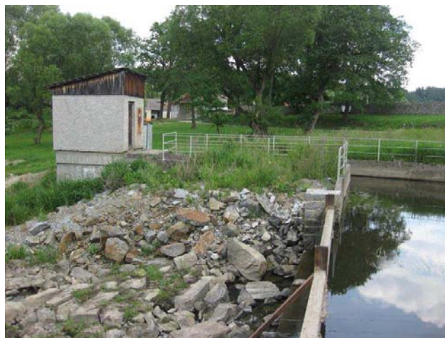
Pravá strana jezu s MVE
