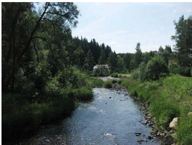
Pohled na jez a tok v podjezí
