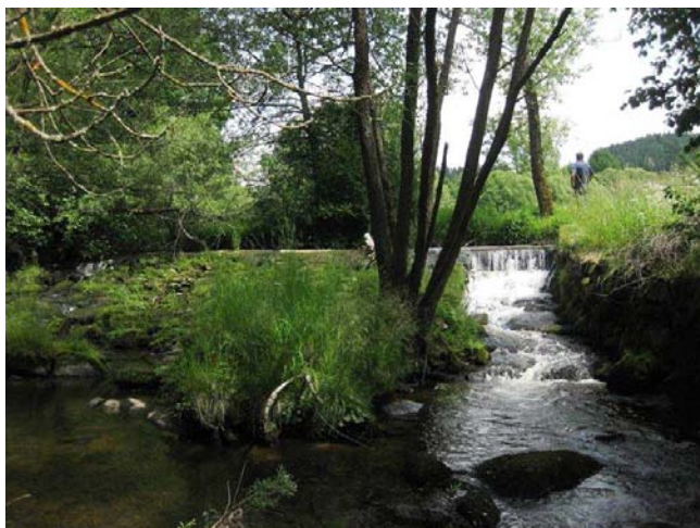
Pohled směrem k jezu s jalovou propustí na levém břehu
