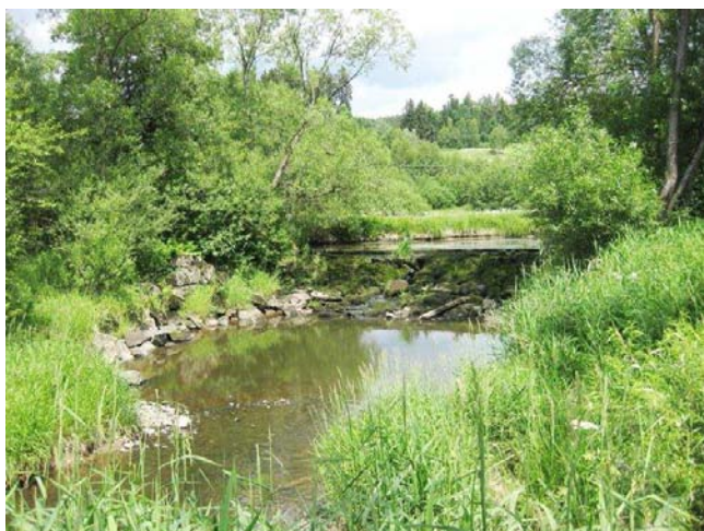
Celkový pohled na jez (pravé pole)
