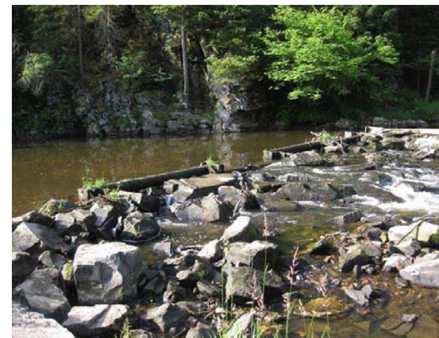
Detail jezové hrany, na levém břehu je začátek náhonu.
