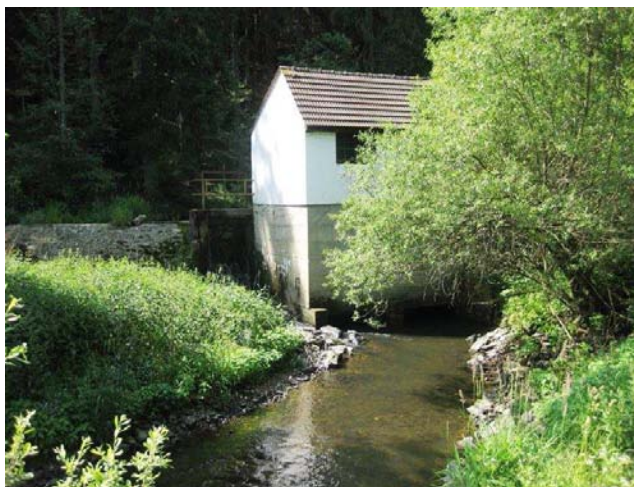
Objekt MVE s odpadním kanálem
