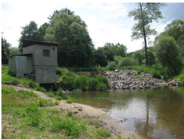
Celkový pohled na jez s MVE
