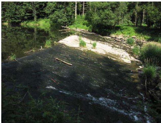
Detail jezové hrany
