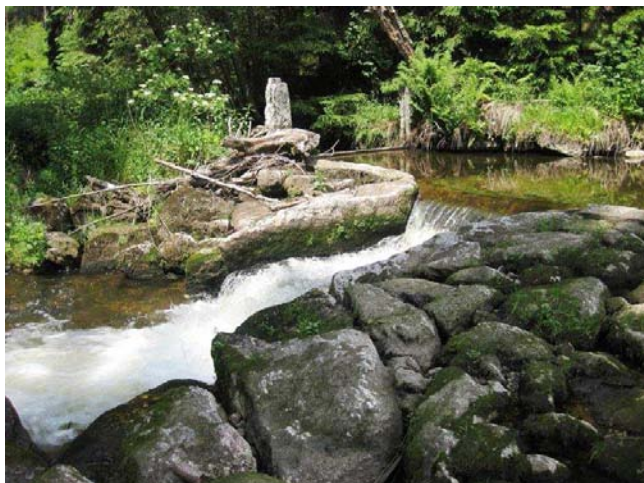
Pohled na jez s vorovou propustí
