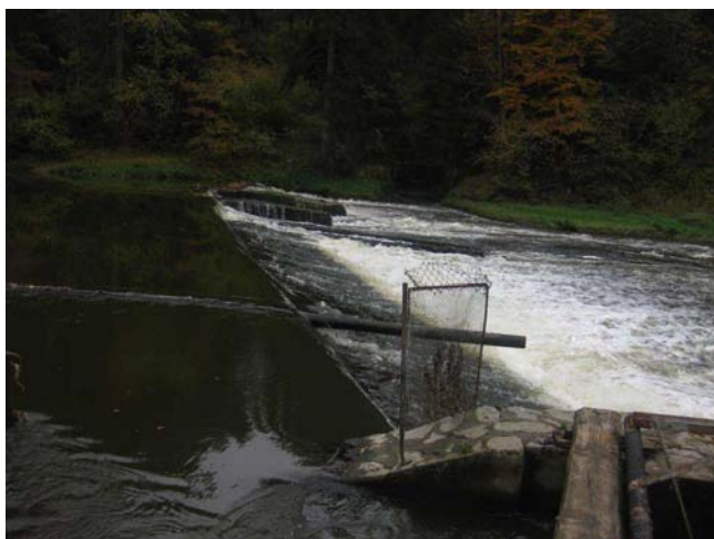
Pohled na jez
