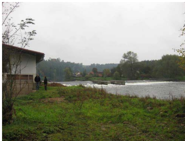
Celkový pohled na jez
