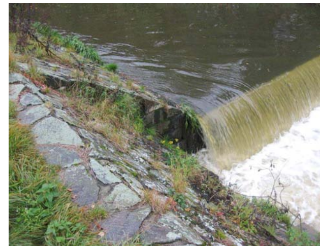
Detail zavázání jezu a opevnění
