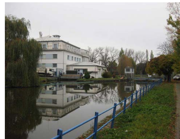
Pohled na jez, vlevo MVE
