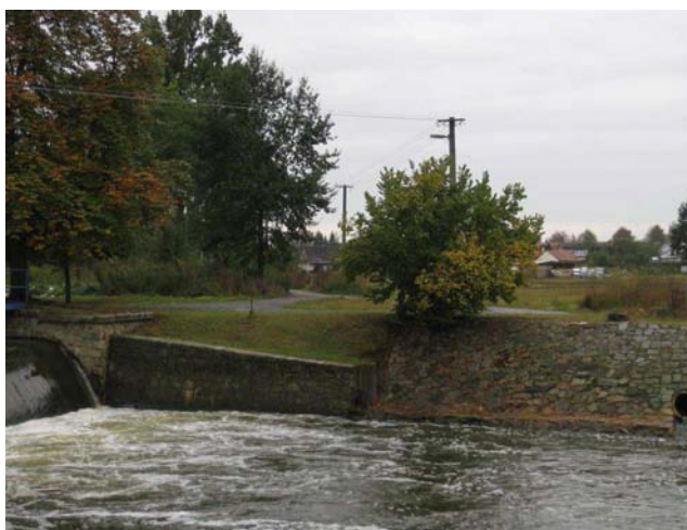
Detail levého břehu
