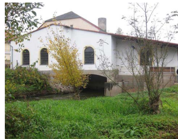
Pohled na odpad z MVE
