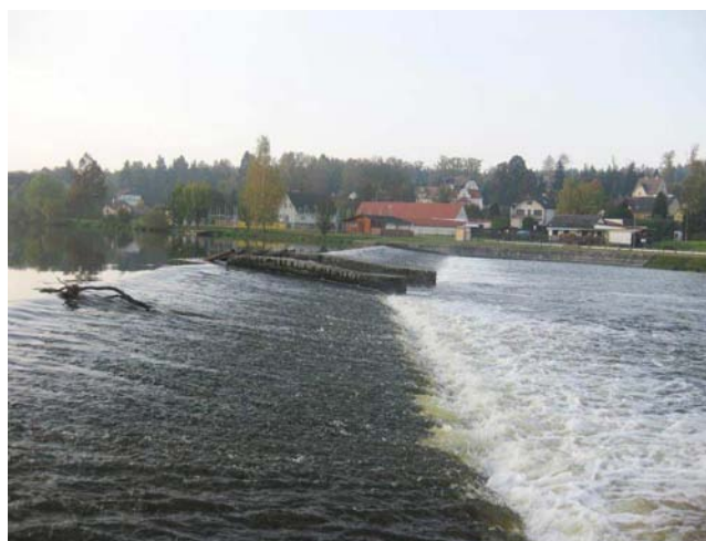
Pohled na jez
