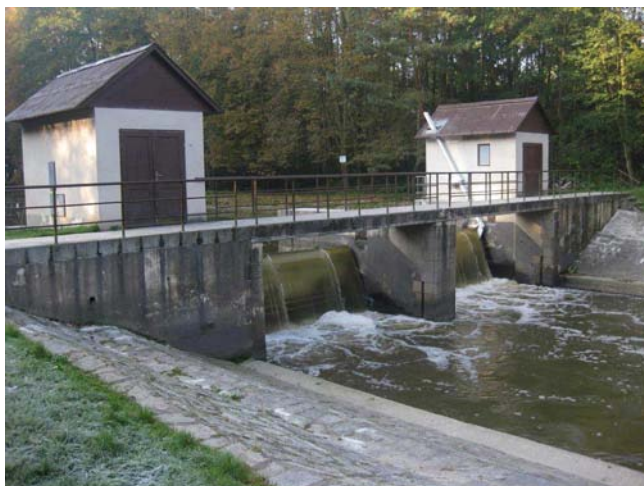
Pohled na jez a MVE z lávky, břehy jsou opevněny
