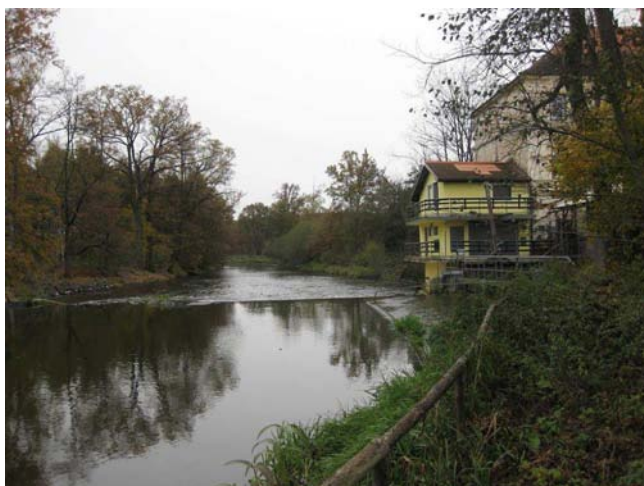
Pohled na jez v pravém rameni toku a na stávající MVE
