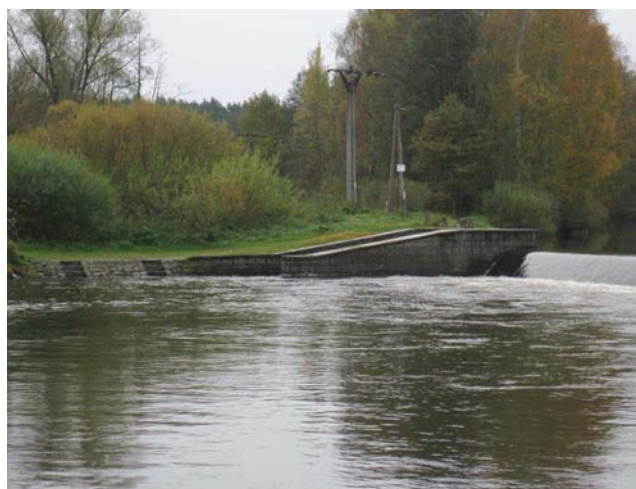
Sportovní propust na pravém břehu
