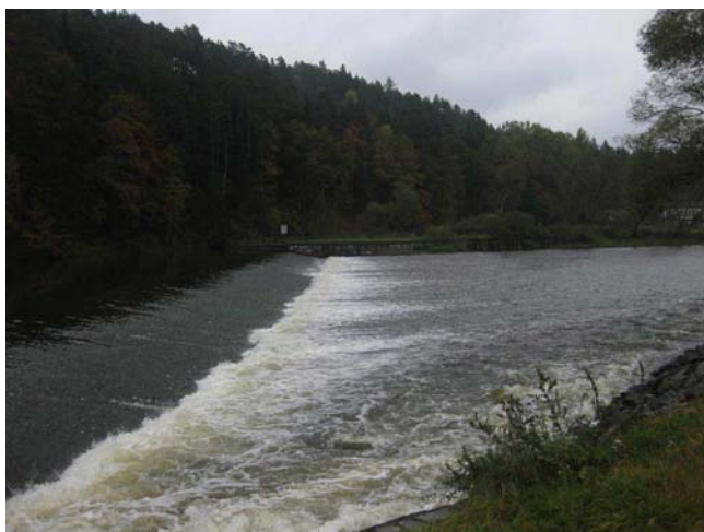
Pohled na jez a levý břeh
