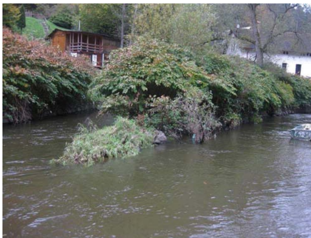
Detail odpadního kanálu od MVE
