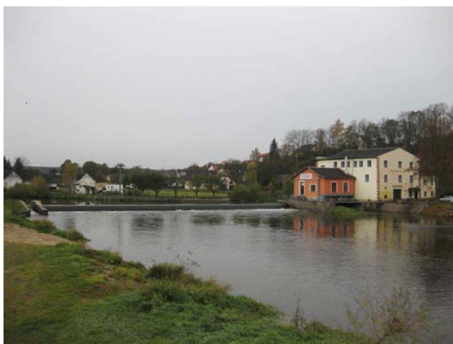
Pohled na jez, MVE na levém břehu
