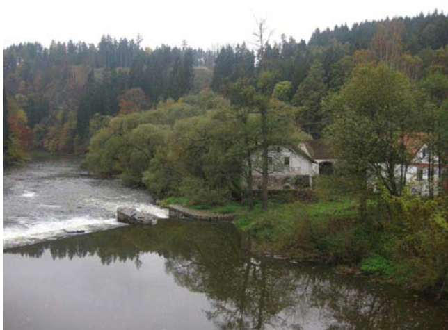
Pohled na pravou stranu jezu z mostu
