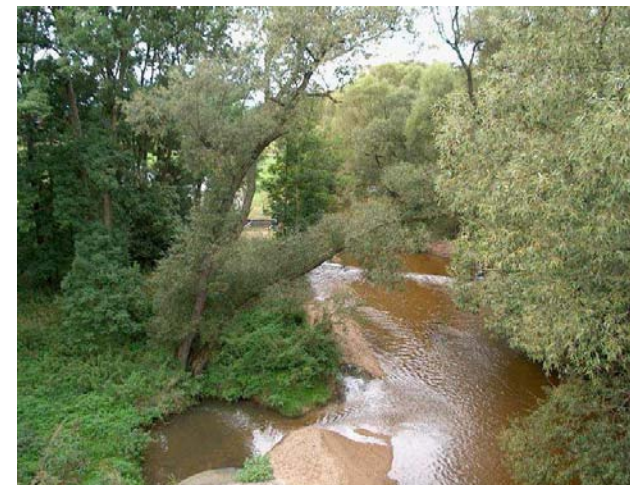
Stupeň odspodu ze železničního mostu
