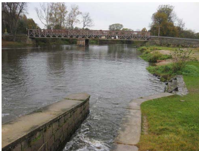
Sportovní propust na pravém břehu
