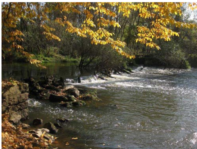
Pohled na poškozený jez
