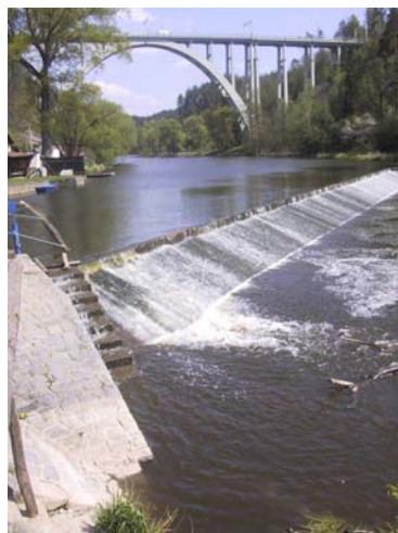
Pohled na jezovou hranu
