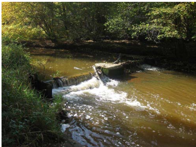
Pohled na stupeň
