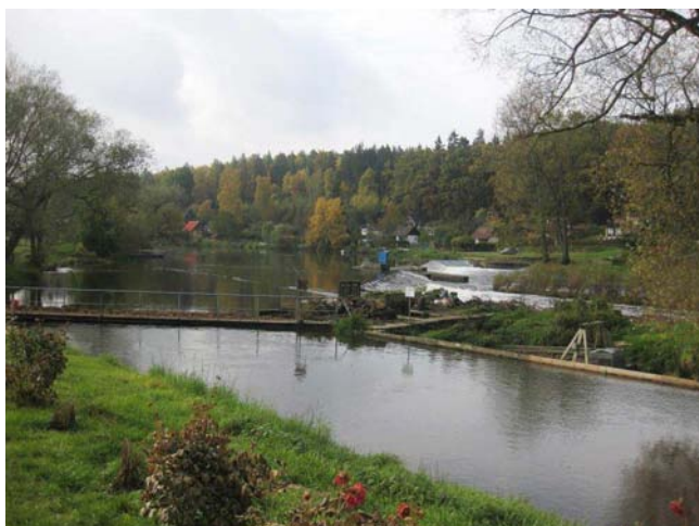
Pohled na jez
