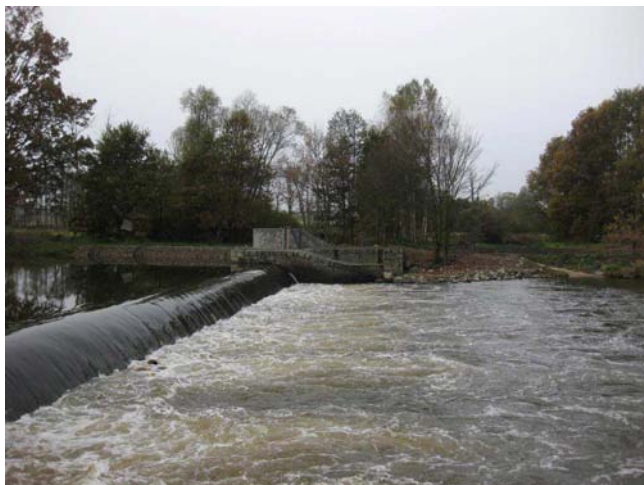
Pohled na levou stranu jezu s štěrkovou propustí
