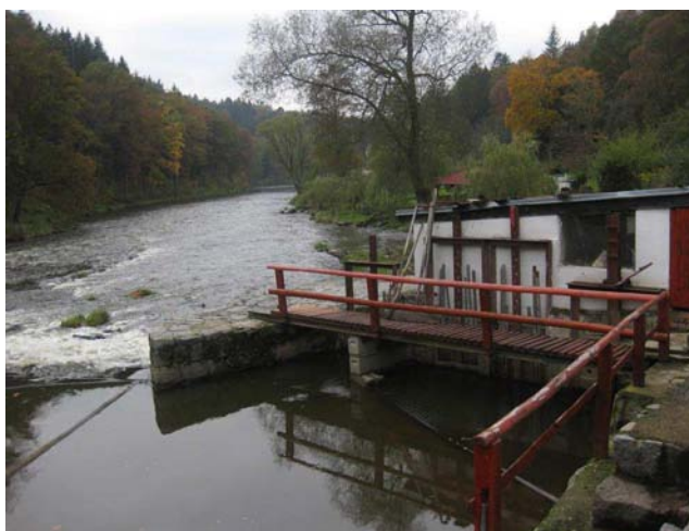
Pohled na pravobřežní MVE
