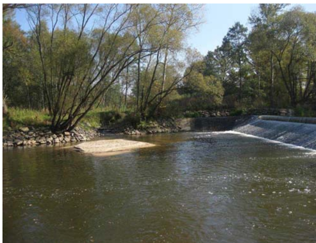
Levý břeh a rybí přechod
