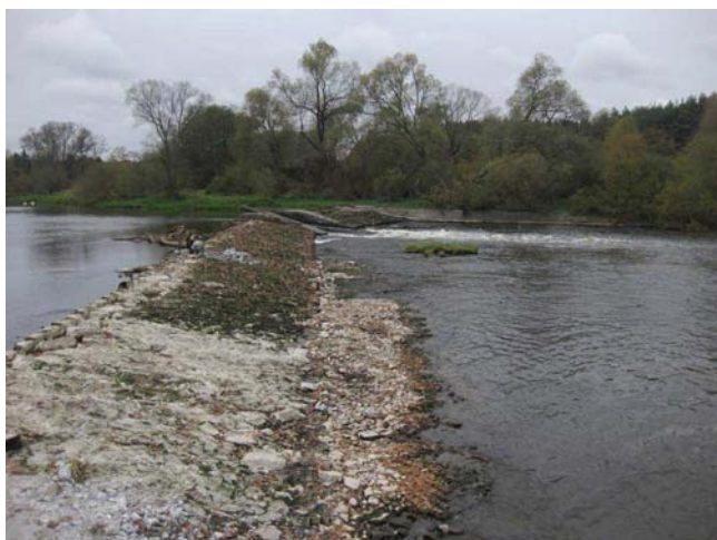
Pohled na jez v rekonstrukci
