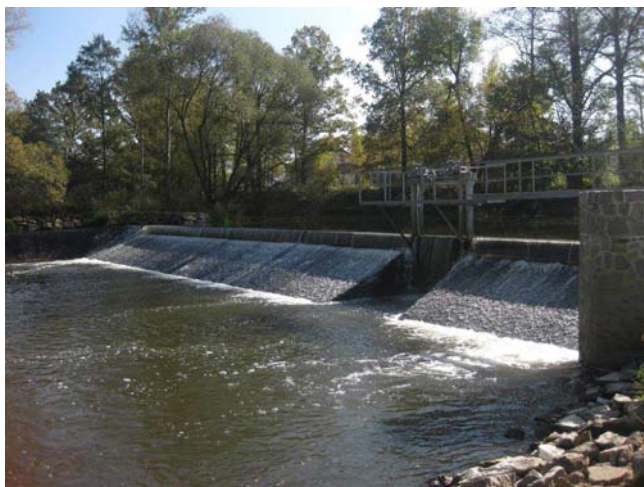
Pohled na jez
