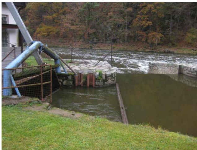
Vstup do náhonu k MVE a vorová propust u levého břehu
