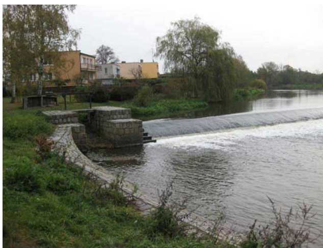
Pravá strana jezu s nefunkční jalovou propustí
