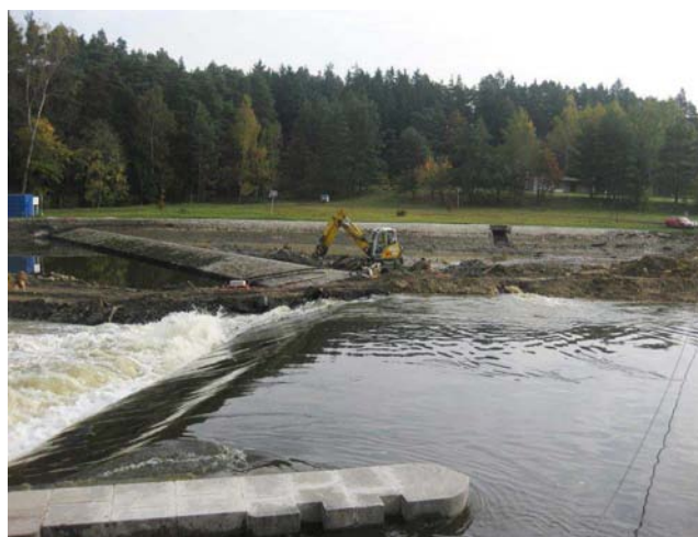
Pravá část jezu byla v rekonstrukci
