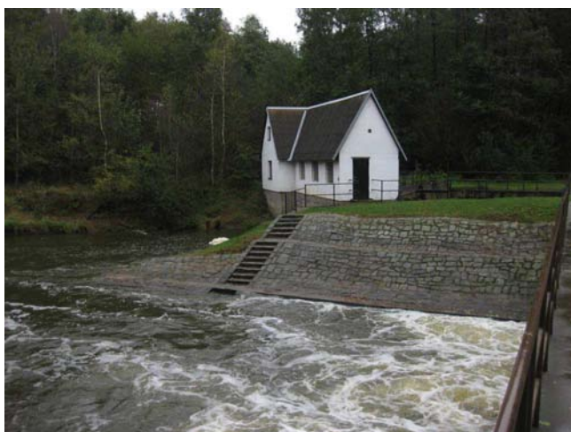
Pohled na jez a MVE z lávky, břehy jsou opevněny
