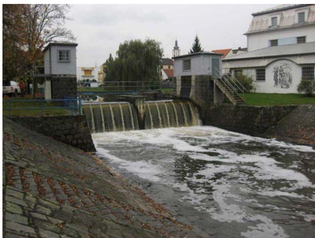
Pohled na jez
