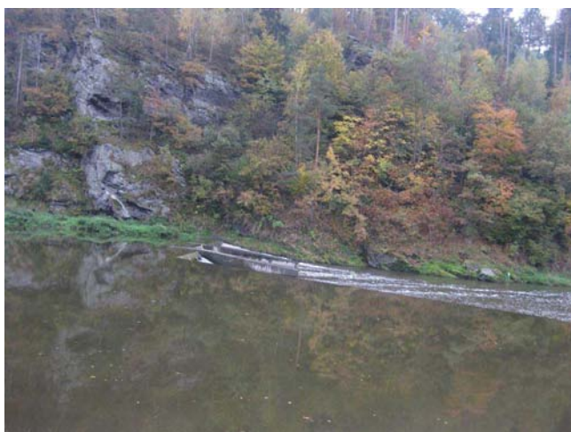
Pohled na nadjezí směrem ke vorové propusti
