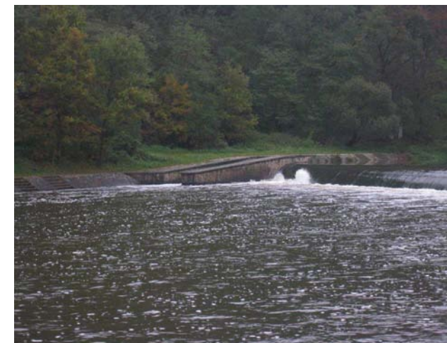
detail sportovní propusti u pravého břehu
