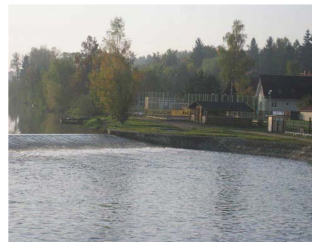
Detail levého břehu
