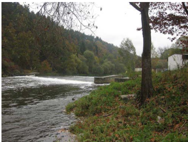
Pohled na jez, u levého břehu je MVE
