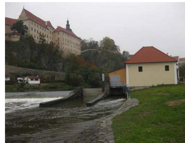
Pohled na levobřežní MVE a odpadní koryto
