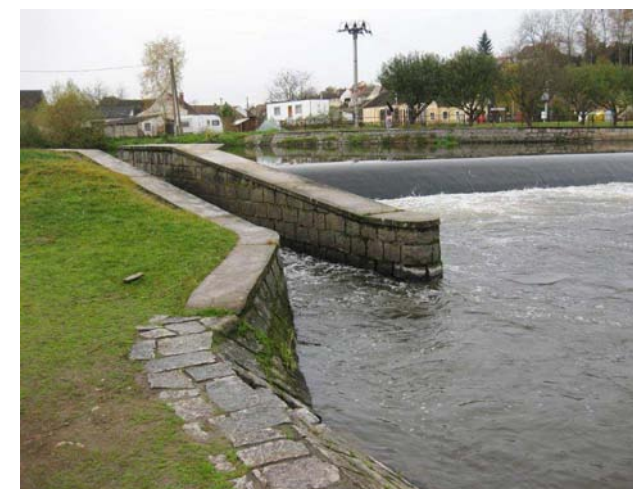
Sportovní propust na pravém břehu
