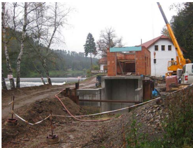
Pohled na právě budovanou MVE
