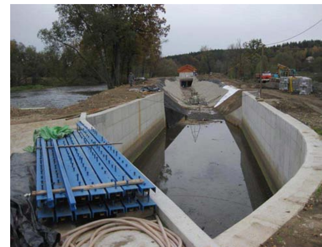
Vstupní objekt k náhonu na MVE
