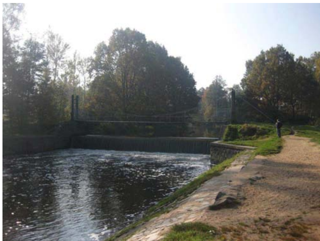
Pohled na jez
