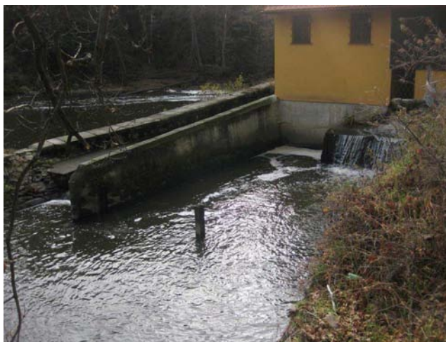
Odpad z MVE, vlevo propust
