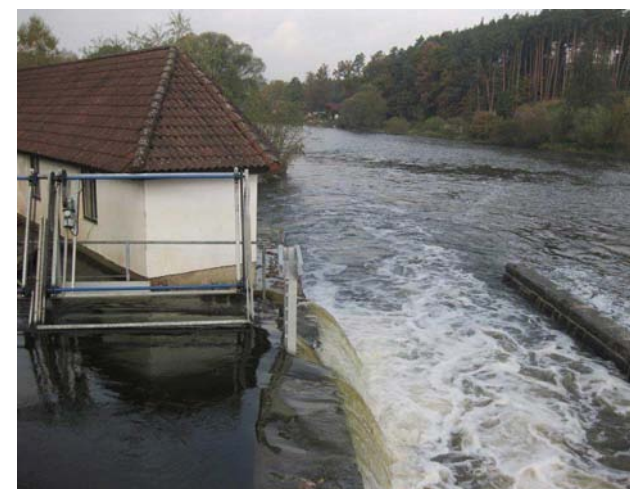
MVE a vorová propust
