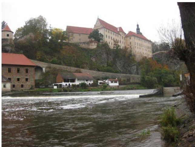
Pohled na jez
