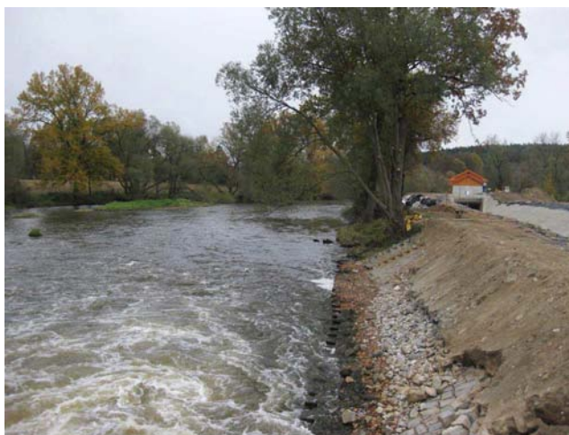
Náhon a MVE na pravém břehu
