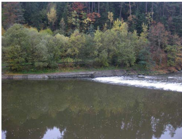
Levý břeh s opevněním
