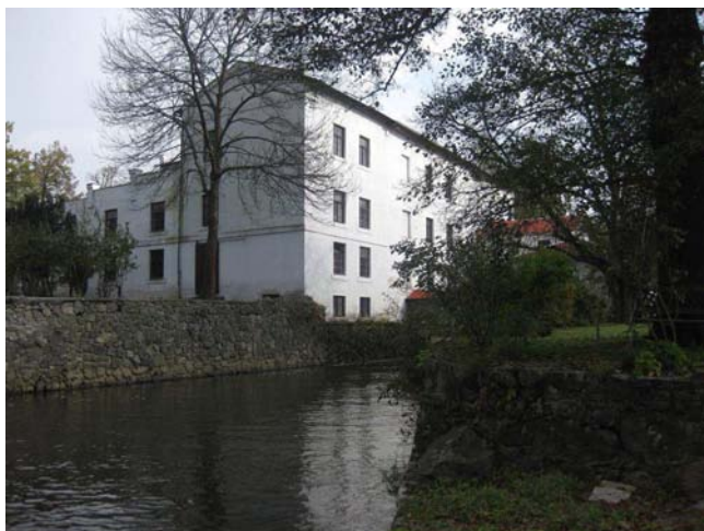
MVE a odpadní kanál
