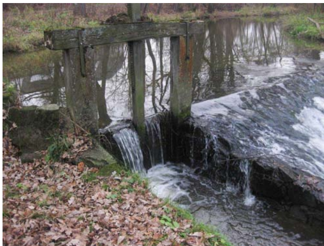
Jalová propust na jezu
