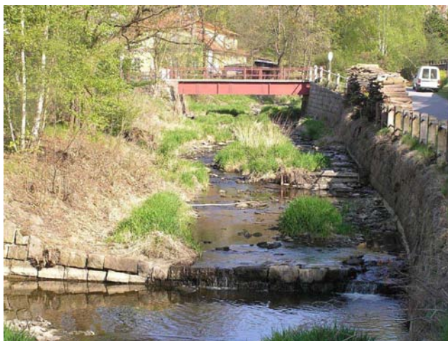
Pohled na stupeň v ř.km 20,410
