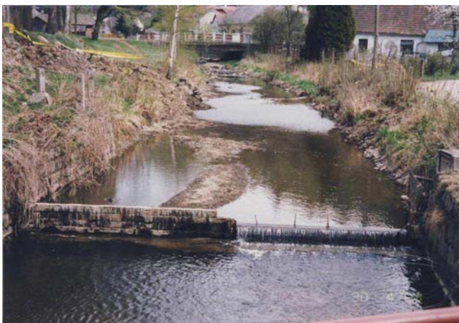
Pohled na stupeň v ř.km 20,113
