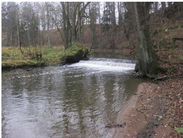
Celkový pohled na jez
