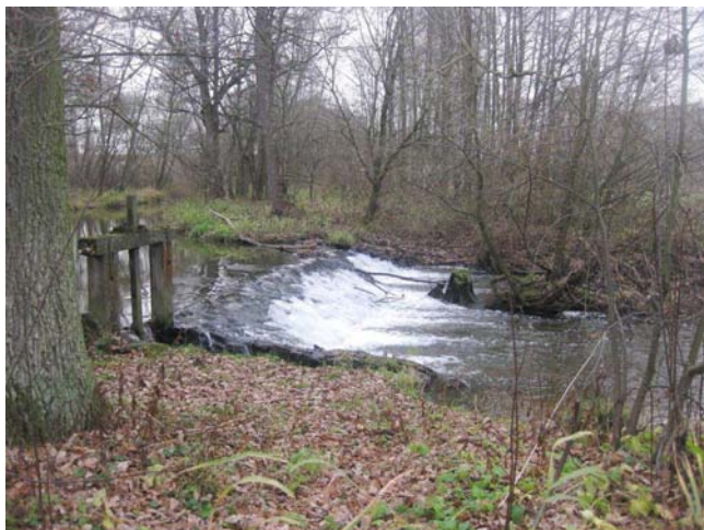
Pohled na jez, v popředí jalová propust
