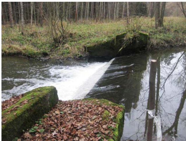
Detail jezové hrany
