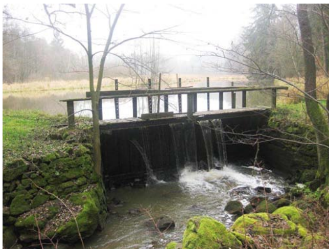
Pohled na vypouštěcí zařízení rybníka
