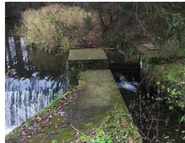
Vstup do napájecího náhonu
