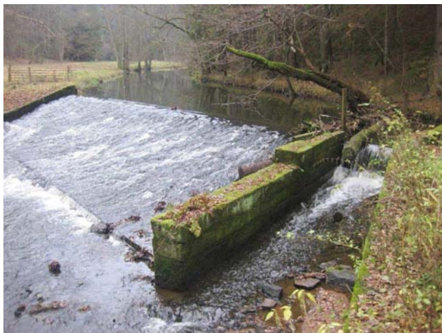
Celkový pohled na jez
