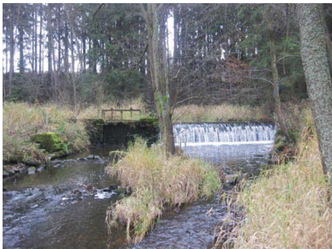
Pohled na jez s jalovou propustí
