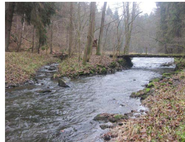
Vstup do rybího přechodu pod jezem
