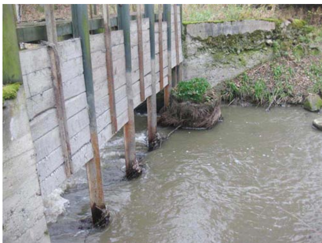
Pohled na vyhrazené stavidlo
