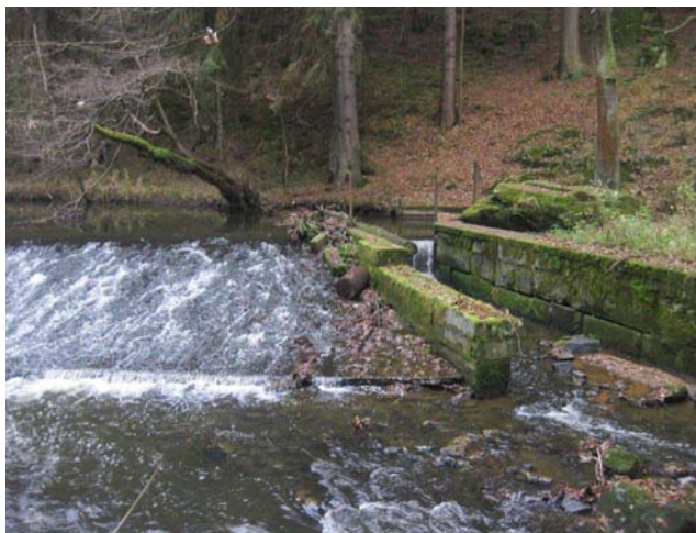
Levá strana jezu s propustí
