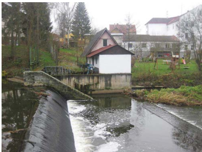
Pohled na jez s MVE
