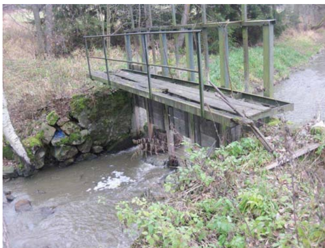
Celkový pohled na stavidlo
