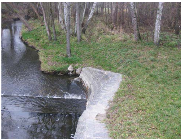
Opevnění pravého břehu
