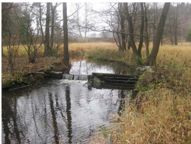
Pohled na stavidlo
