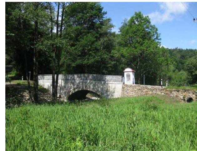
Rekonstruovaný silniční most pod jezem
