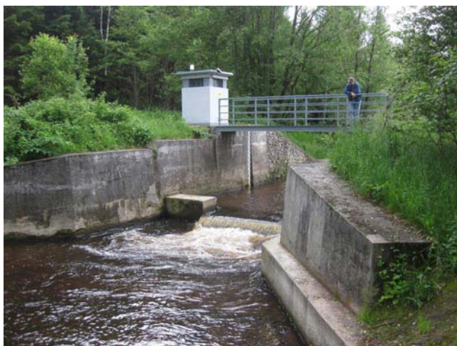
Stupeň s limnigrafickou stanicí
