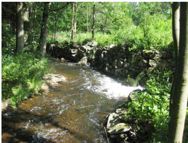
Vyústění jalového přepadu
