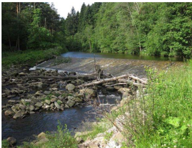
Celkový pohled na jez
