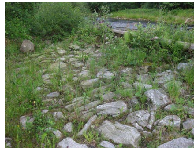
Detail zachované jezové hrany
