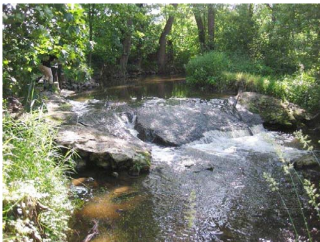
Celkový pohled na jez
