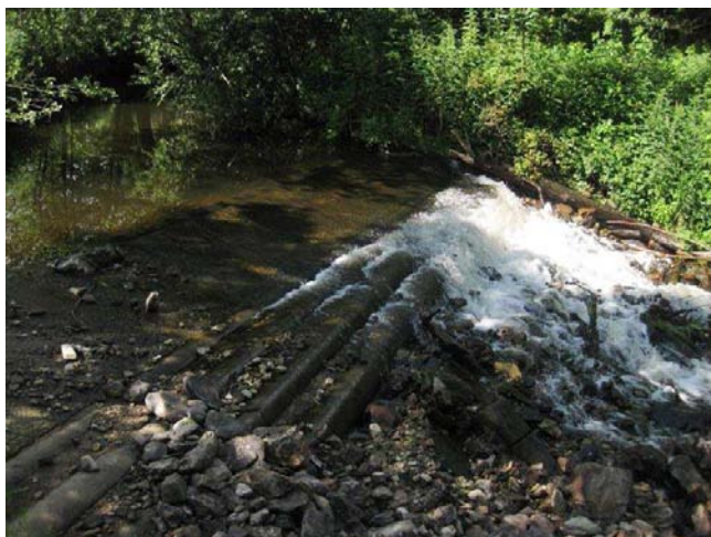
Detail jezové hrany
