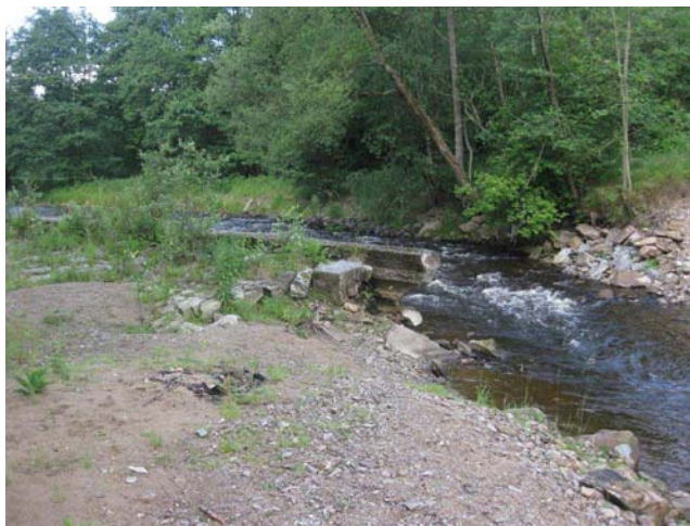
Část konstrukce bývalého jezu
