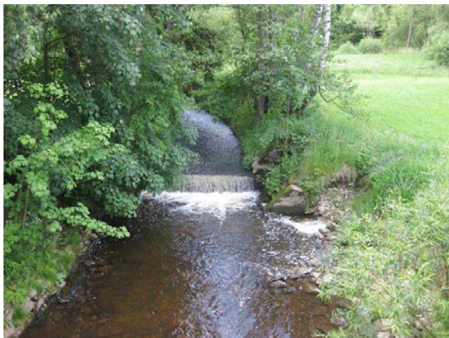
Pohled na stupeň ze silničního mostu
