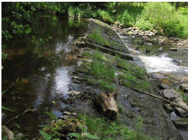
Celkový pohled na jez
