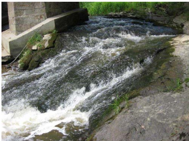
Levá část stupně pod mostem
