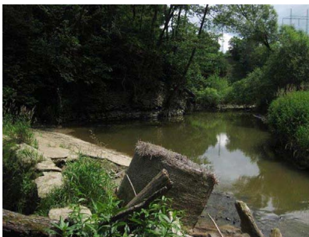
Pohled do nadjezí
