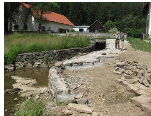
Jalová propust, nalevo budova mlýnu s MVE
