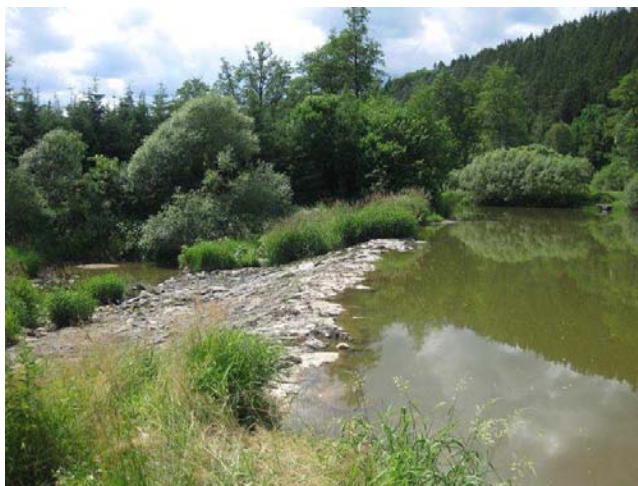
Pohled na jez s nadjezím
