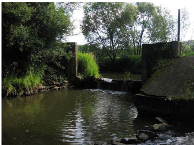
Bývalá hráz rybníku
