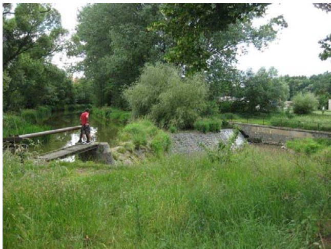
Pohled na jez s propustí
