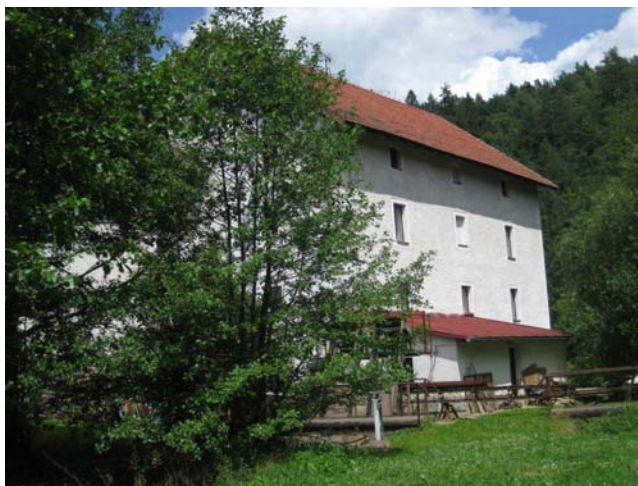
Budova bývalého mlýnu s MVE
