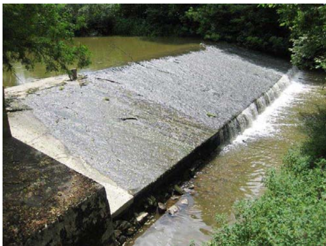
Pohled na jez a levý břeh
