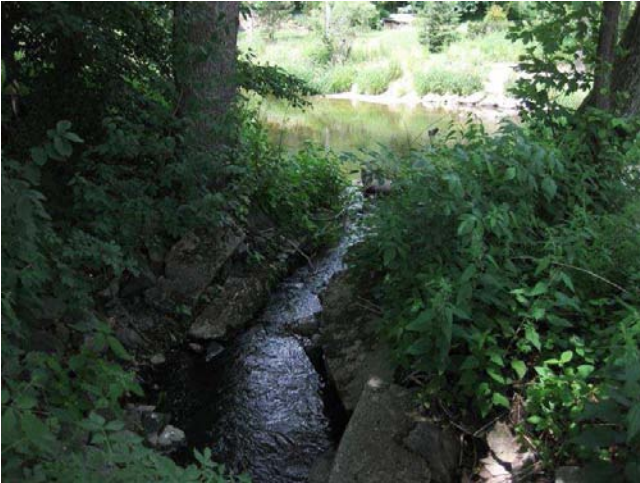
Jalová propust na levém břehu
