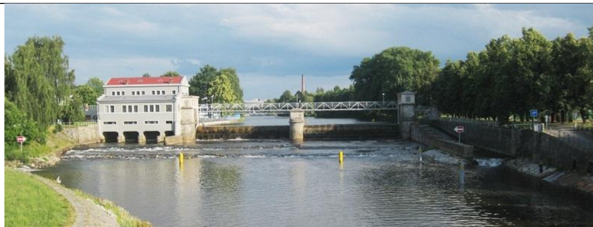
Obr. 3: Ilustrační foto – Jiráskův jez v Českých Budějovicích (ř.km 239,624)
