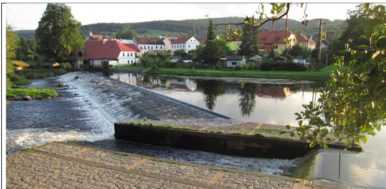
Obr. 4: Ilustrační foto – jez u Bílého mlýnu ve Vyšším Brodě (ř.km 317,922)
