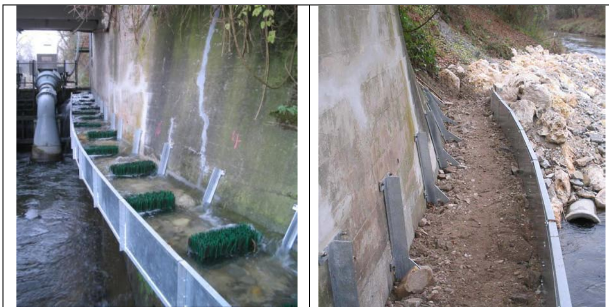
Obr. 27: Příklad kartáčového RP, řeka Rems. Birkelwehr Weinstadt, Německo (foto.: R.Hassinger)
