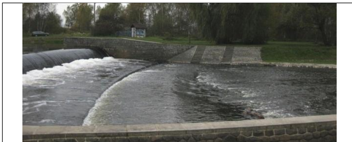
Obr. 12: Příklad - Nový jez na Neţárce ve Veselí nad Luţnicí – jedná se o vysoký a dlouhý jez s dlouhou vorovou propustí hrazenou klapkou, na pravém břehu je MVE, na levém je náhon zvaný Degárka slouţící k nadlepšení průtoků v Luţnici
