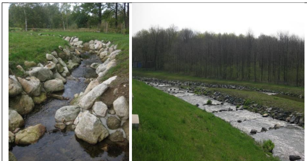
Obr. 21: příklady rybích přechodů typu bypas
