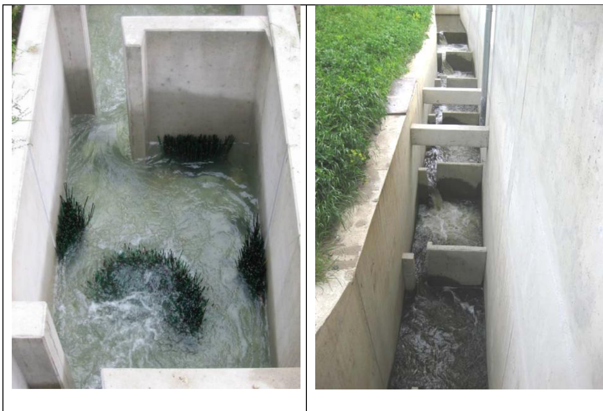
Obr. 24: příklady štěrbínových rybích přechodů
