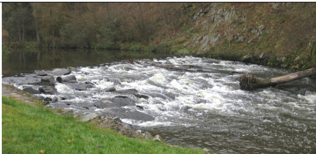
Obr. 9: Příklad - Jez Valcha na Neţárce, který je migračně průchodný
