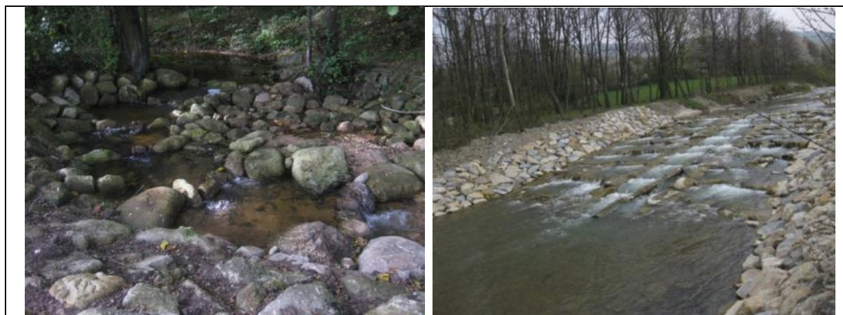
Obr. 22: příklady balvanitých skluzů
