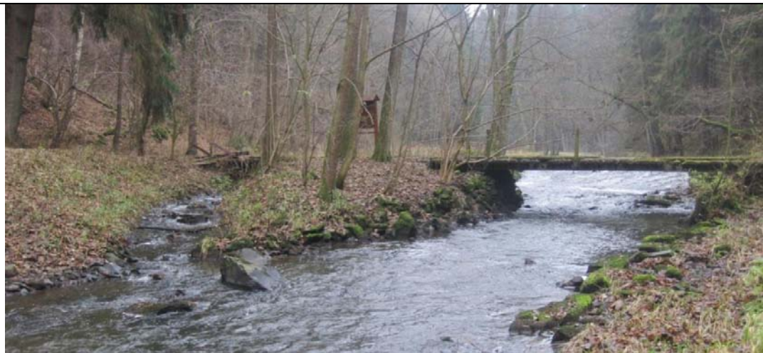
Obr. 10: Příklad - jez Jindřiř na Hamerském potoce, na jezu je rybí přechod typu bypas, ale má vstup daleko pod jezem a ryby ho proto nejspíš nenajdou. Je možné buď rybí přechod upravit, nebo dokonce vzhledem k tomu, ţe jez nemá jít ţádné vyuţítí, jez možné odstranit a nahradit balvanitou rampou nebo nízkým stabilizačním stupněm.
