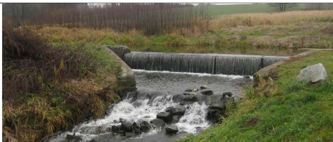
Obr. 17: Ilustrační foto – jez U vodárny na Ťirovnici, ř.km. 19,55, migračně neprůchodná příčná překáţka
