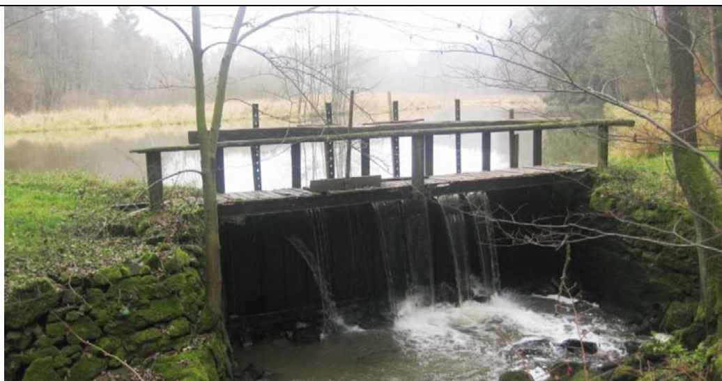
Obr. 8: Příklad – stavidlo u bývalého Kočvarova mlýnu, které již pozbylo původní funkci, pouze udržuje hladinu v tůni nad ním a zároveň tvoří migrační bariéru, není jasné vlastnictví, proto je nutné vyjasnit vlastnické vztahy a stavidlo zprůchodnit nebo odstranit.
