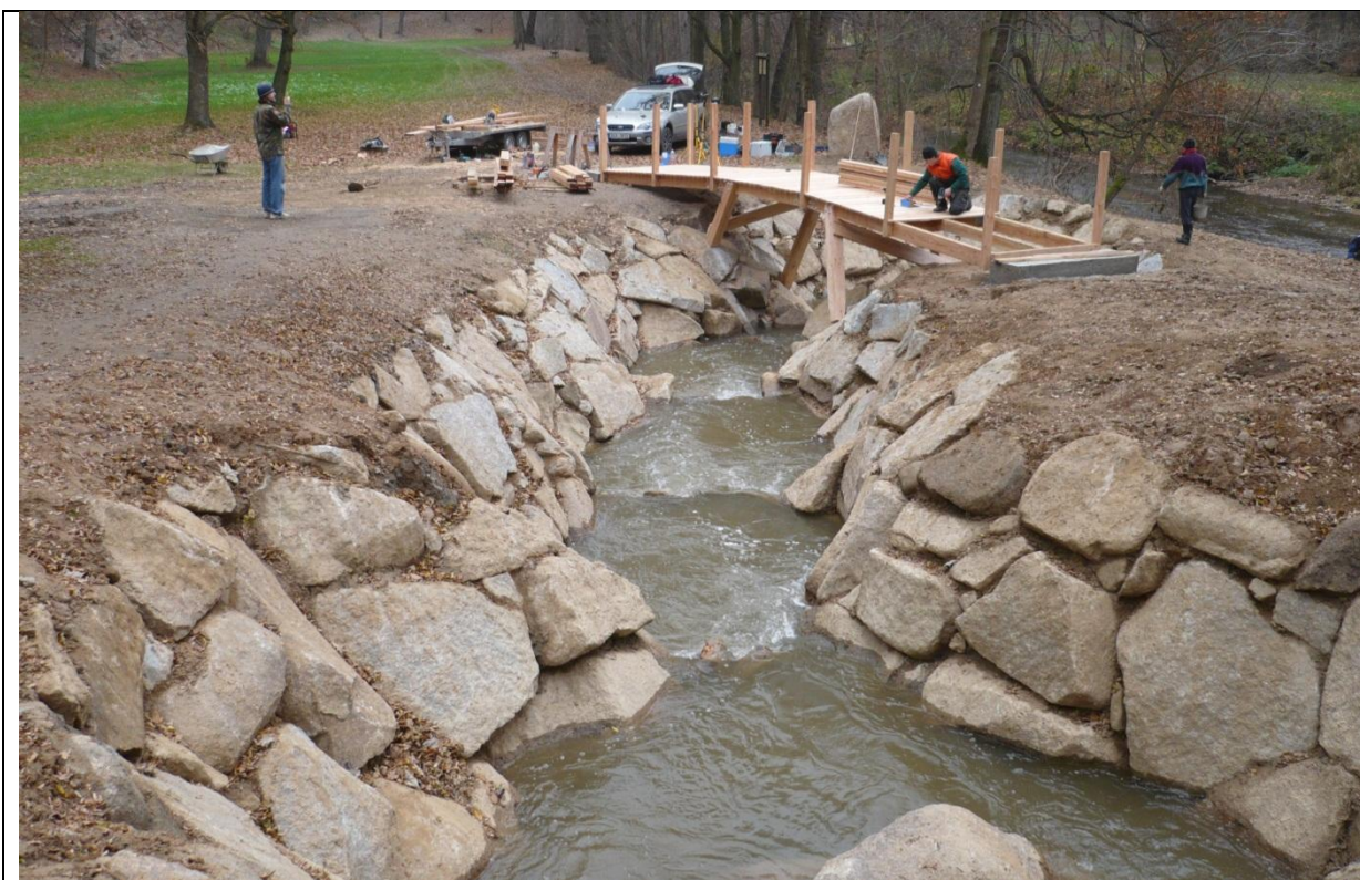
Obr. 2: Ilustrační obrázek – realizace přírodě blízkého rybního přechodu na jezu U Znosimské brány
