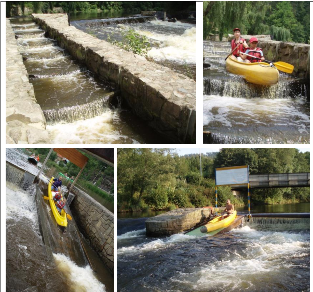
Obr. 17: příklady vodáckých skluzů a ramp, Nahore - Lužnice, jez Benešův mlýn,
