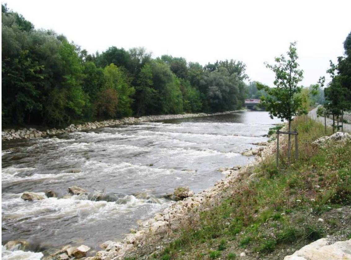
Obr. 12: příklad odstranění jezu - řeka Vertach, Ausburk, Německo (foto Ing. Just)
