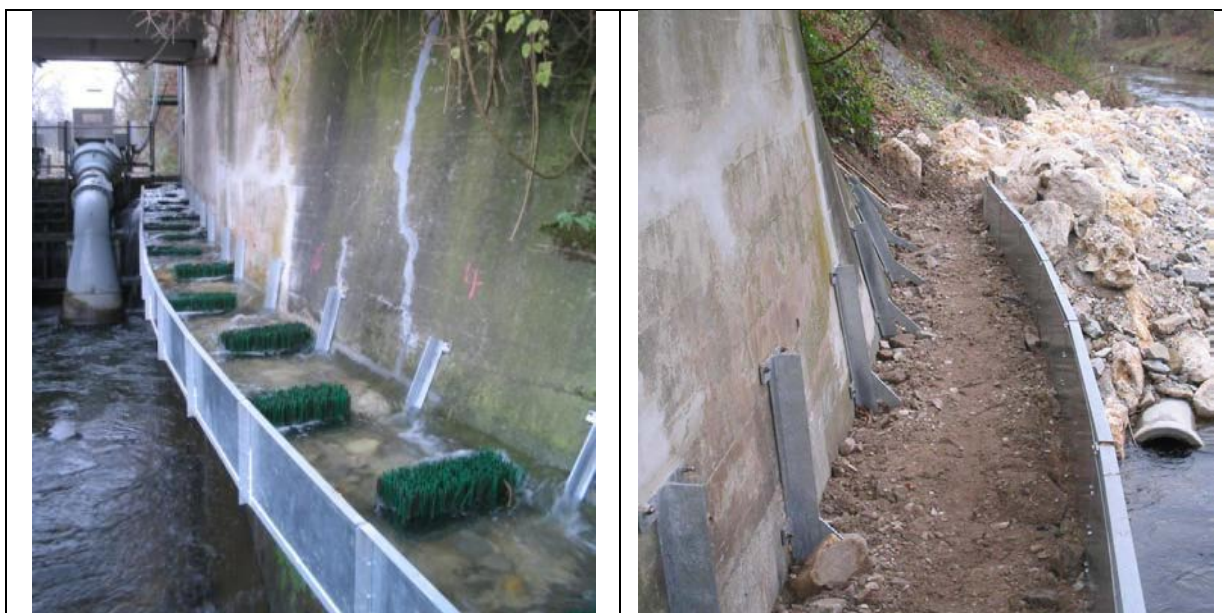
Obr. 9: Příklad kartáčového RP, řeka Rems. Birkelwehr Weinstadt, Německo
