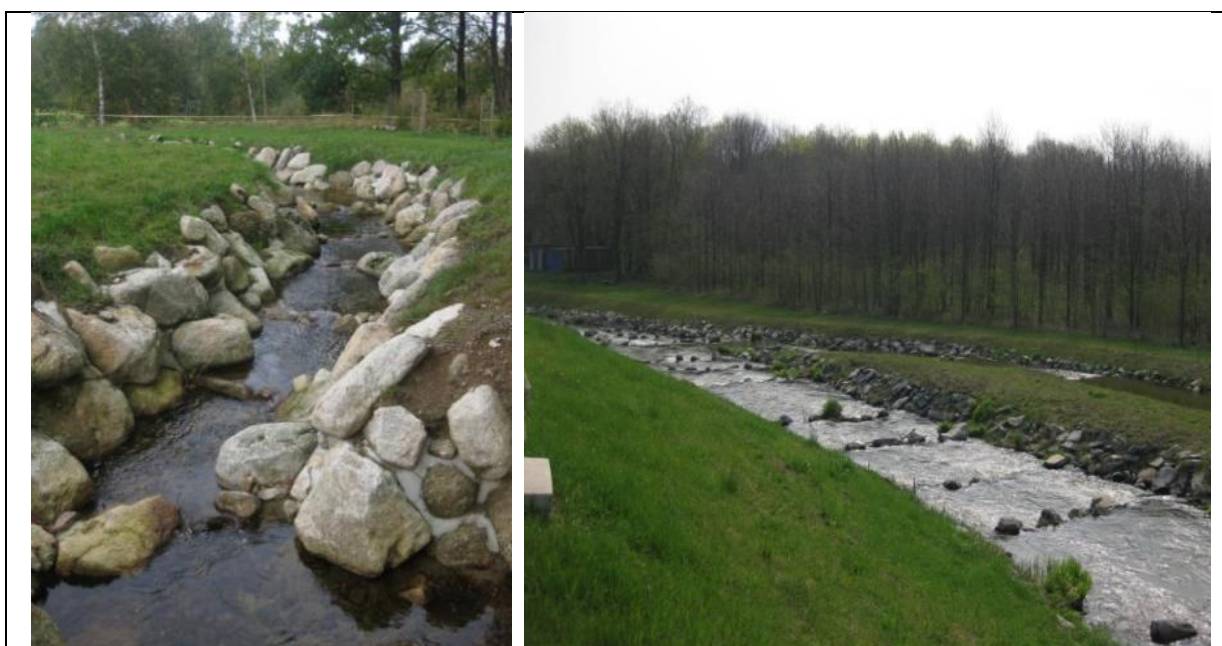
Obr. 3: příklady rybího přechodu typu bypas
