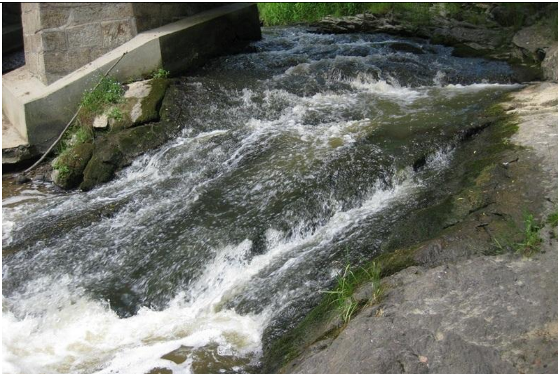
Obr. 17: Ilustrační obrázek – Blanice - neprůchodný stupeň pod silničním mostem, ř.km.33,35
