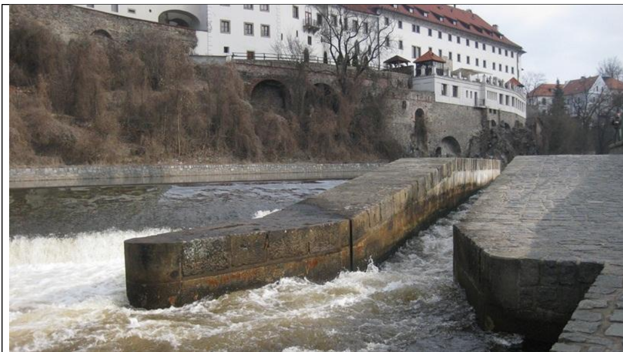
Obr. 16: Ilustrační obrázek – Vltava, Benešův jez v Českém Krumlově (ř.km 282,970) se sportovní propustí využitelnou pro kartáčový rybí přechod
