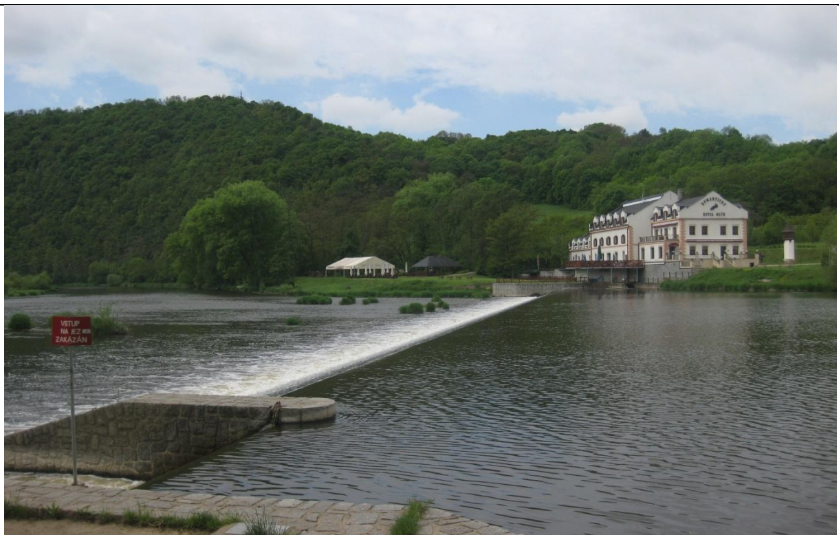
Obr. 5: Ilustrační obrázek, jez Karlštejn, Berounka ř.km. 24,489
