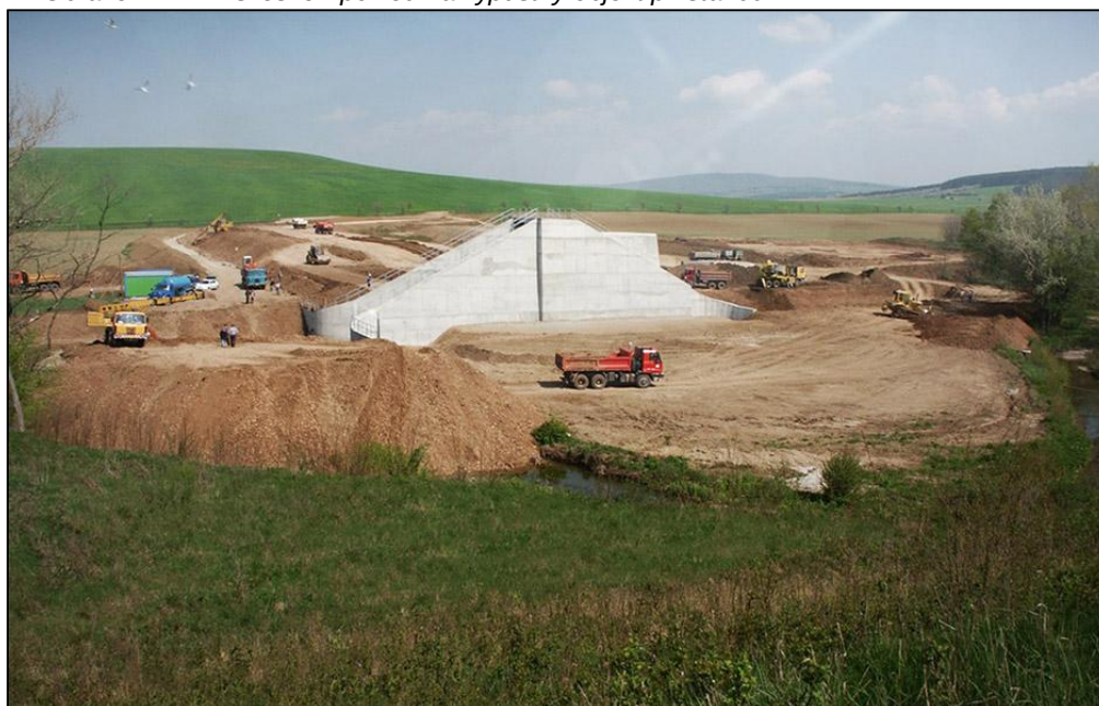
Obrázek 4 - VD Oreské - pohled na výpustný objekt při stavbě
