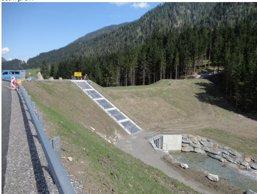
Obrázek 8 - VD Flachau - pohled ze vzdušného líce hráze na výstavbu korunového bezpečnostního přelivu
