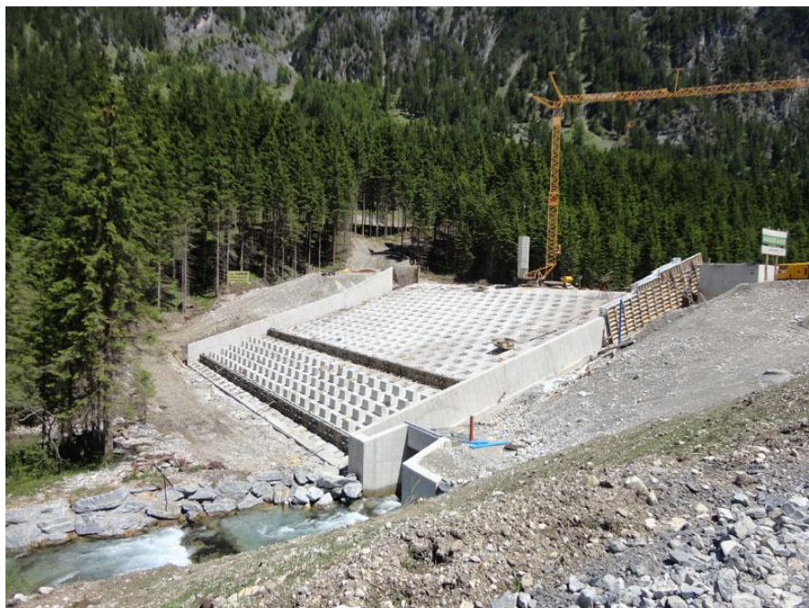
Obrázek 8 - VD Flachau - pohled ze vzdušného líce hráze na výstavbu korunového bezpečnostního přelivu
