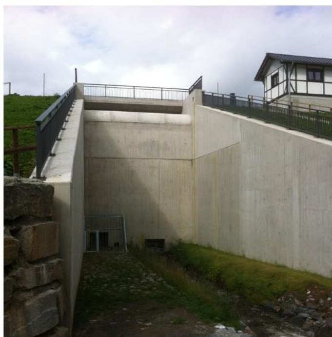
Obrázek 6 - VD Warstein - pohled na návodní líc hráze a výpustný objekt
