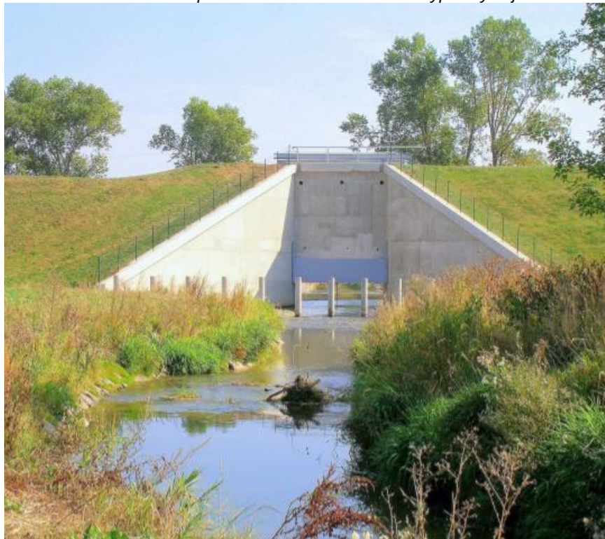
Obrázek 5 - VD Žichlínek - pohled na návodní líc hráze a výpustný objekt
