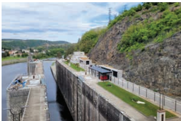
VD Štěchovice – rekonstrukce budov zázemí VD
