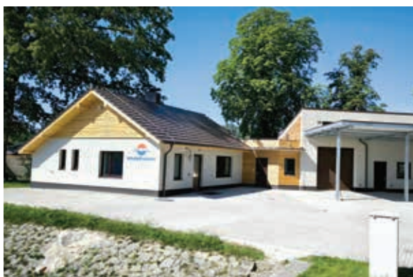
VD Hluboká nad Vltavou – rekonstrukce provozní budovy s výstavbou krytých stání
