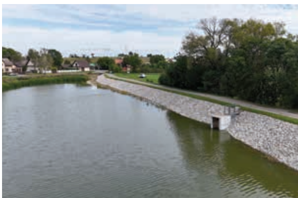
Švarcava – MVN Kuchařik – oprava hráze
