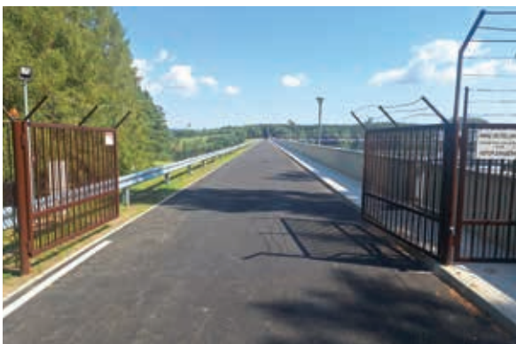
Želivka – VD Švihov – oprava vozovky a chodníku na hrázi
