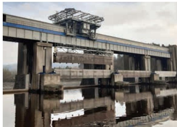
Jeřáb Vrané – zkouška manipulace s hradidlem
