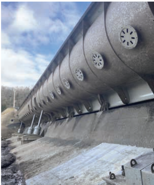
Vltava – Dolany – oprava technologie jezového pole
