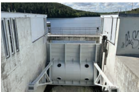
Malše – VD Římov – oprava PKO segmentů
