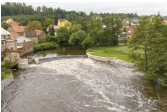
Mže – jez Kozolupy – oprava jezu
