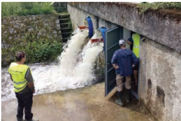
VD Mačice – odbahnění a rekonstrukce spodních výpustí
