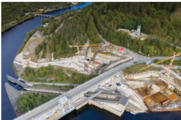
VD Orlik - zabezpečení VD před účinky velkých vod
