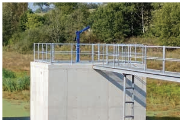
VD Mačice – odbahnění a rekonstrukce spodních výpustí
