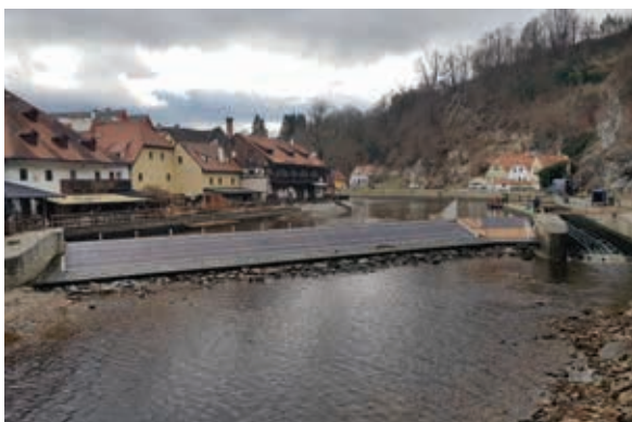
Vltava – jez Jelení lávka – oprava přelivné plochy
