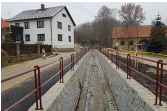
DVT Babický potok, Horní Chrást – oprava opevnění
