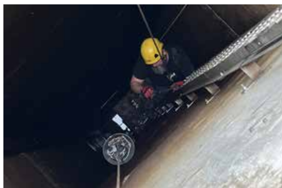
Měření deformací v šachtě uzávěru obtoku PK Štěchovice
