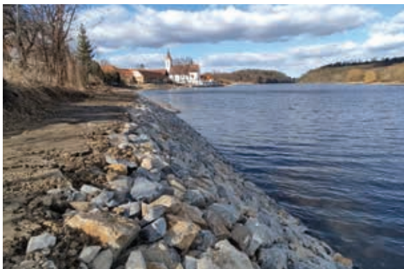
Vltava, Purkarec – stabilizace břehových nátrží
