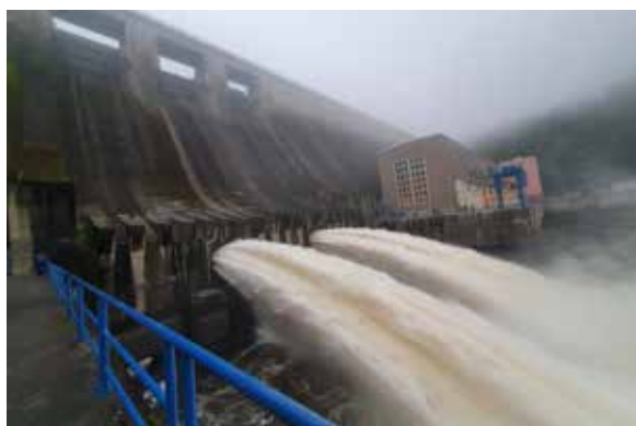
Provozní zkouška uzávěrů spodních výpustí na VD Orlik
