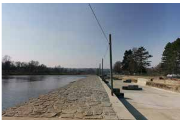
VD Troja – dokončená stavba – dělicí zeď
