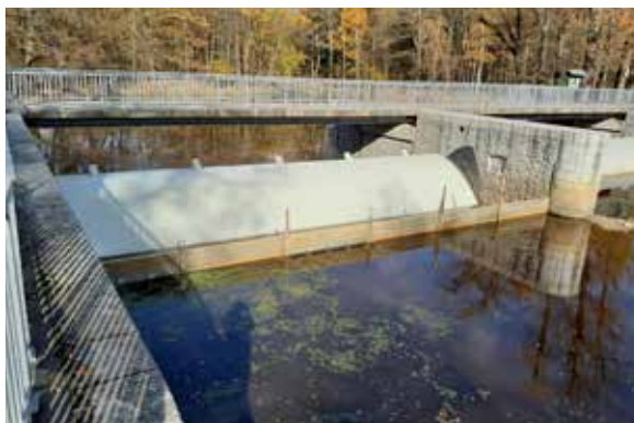
Lužnice, Novořecké splavy – oprava nátěru klapky
