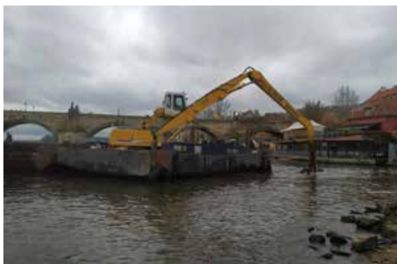
Vltava, Praha – Malá Strana – odstranění nánosů
