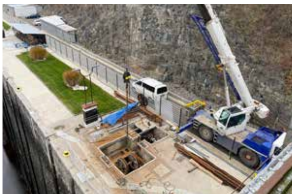
Vltava, VD Štěchovice – oprava stavítek středního a dolního ohlavi
