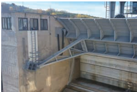
Vltava, VD Kamýk – oprava povrchových ochranných a konstrukce
