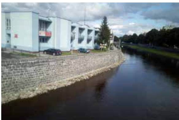
Otava Strakonice – oprava opěrné zdi
