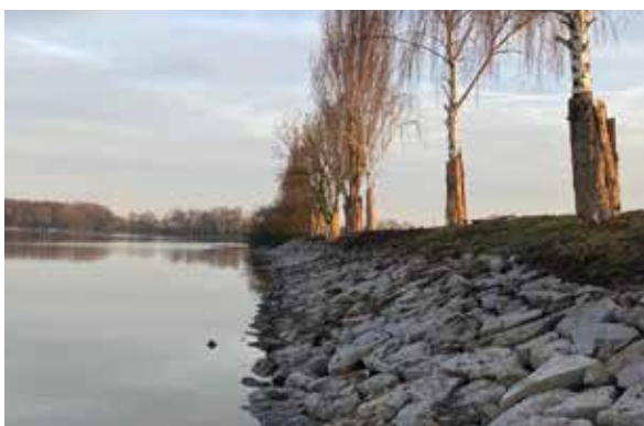
Vranský potok, MVN Šlapanice – oprava pravého břehu
