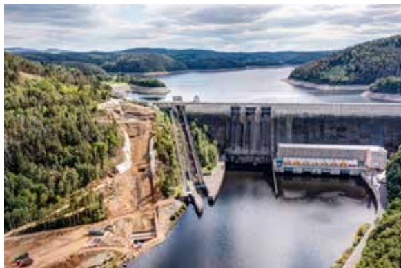
VD Orlík – pohled na provedené zemní práce
