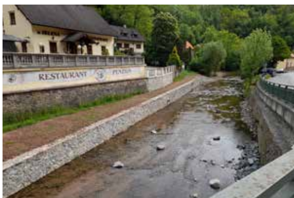
Rakovnický potok, Křivoklát – oprava opevnění koryta
