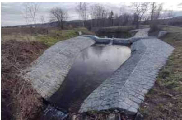
DVT Chlumecký potok, Skřipel – oprava štěrkové přehrážky
