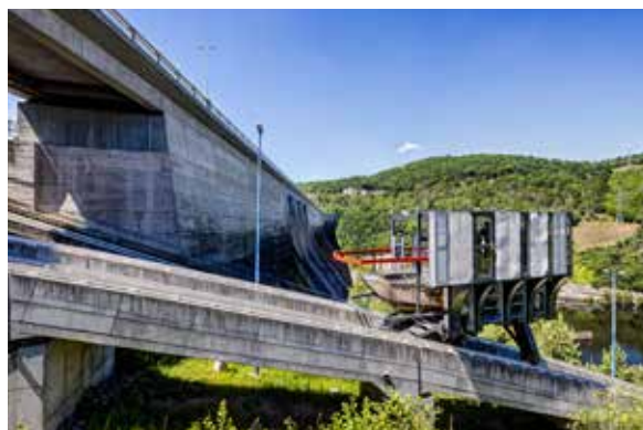
VD Orlík – modernizace lodního výtahu
