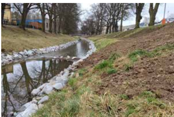
Rakovnický potok, Rakovník – oprava břehového opevnění
