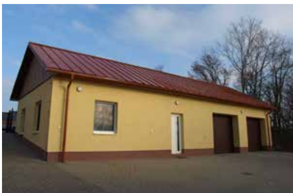
VD Klabava – nová provozní budova
