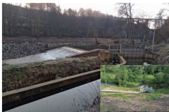
Klabava – oprava jezu Dilo
