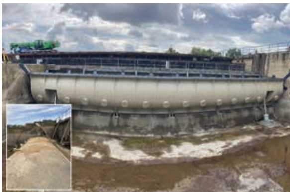
VD Modřany – oprava technologie levého jezového pole
