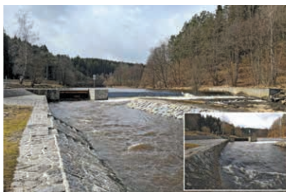
Herbertov – oprava pilíře
