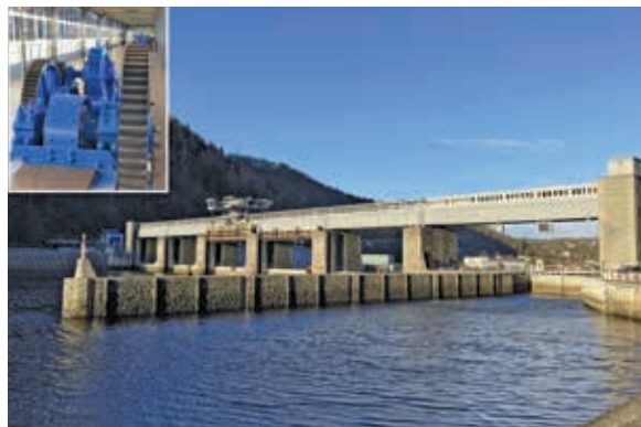
VD Štěchovice – oprava mostovky
