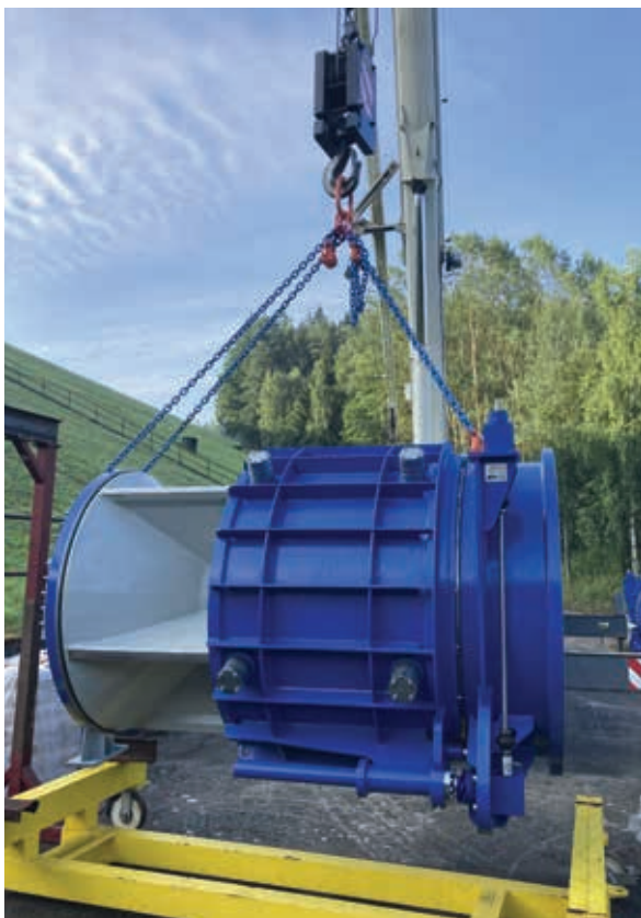
VD Švihov – rekonstrukce regulačních uzávěrů spodních výpustí
