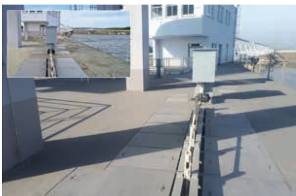
Želivka, VD Švihov – sanace betonových konstrukcí plošiny na kótě 381,30
