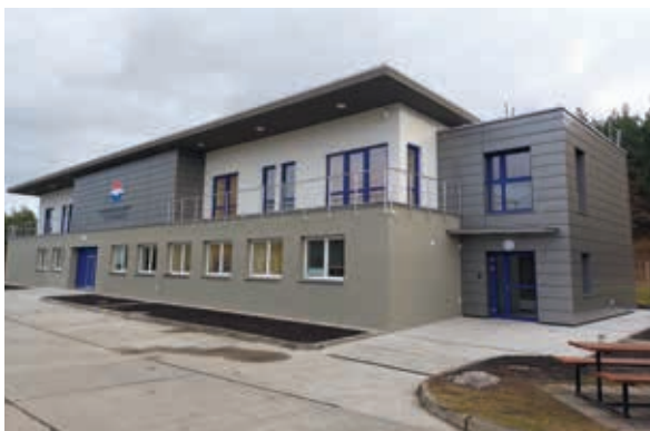
Hněvkovice – provozní budova
