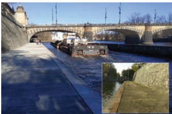
Vltava, VD Smíchov ř. km 53,5 - 53,7 – DPK – oprava pochozích plat
