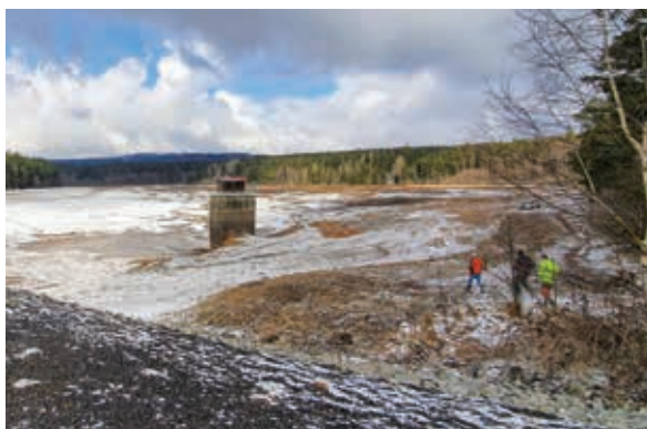
VD Láz – prohlídka TBD při příležitosti vypuštěné nádrže
