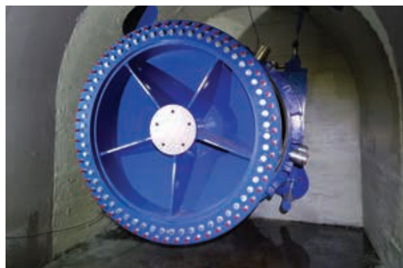
VD Švihov – rekonstrukce regulačních uzávěrů spodních výpustí
