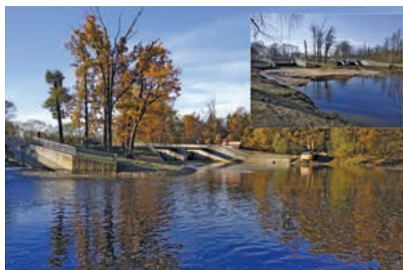
Lužnice, Novořecké splavy – odstranění nánosů z podjezí
