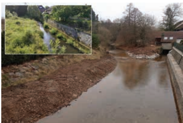
Klabava, Kamenný Újezd – oprava opěrné zdi
