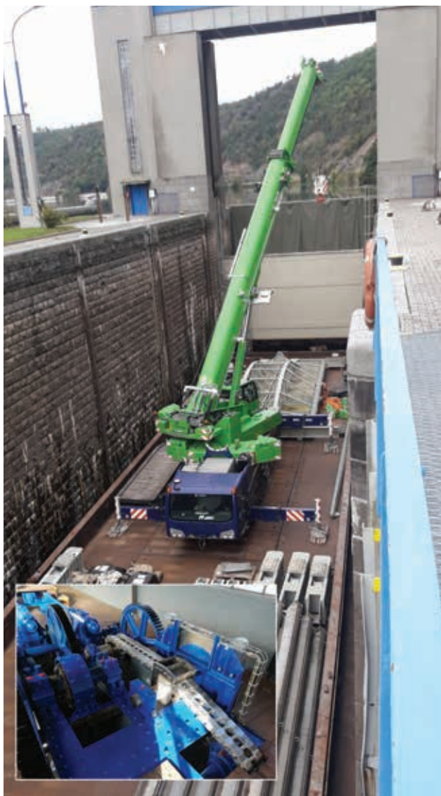
Vltava, VD Vrané – oprava konstrukce a pohonu horních vrat plavební komory
