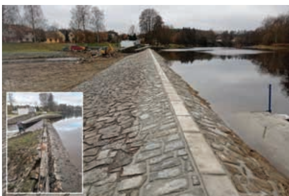
Otava, Katovice – oprava jezu
