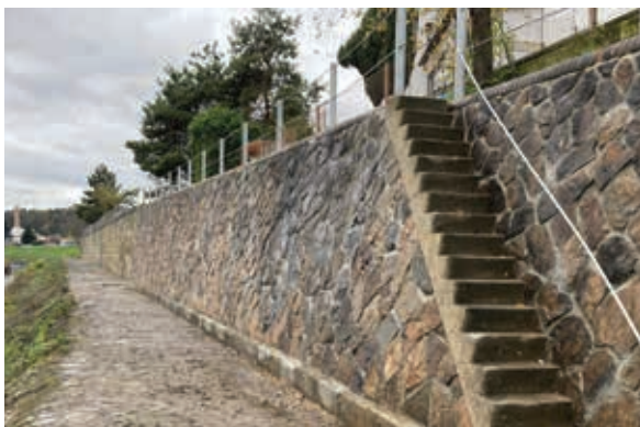
Vltava, Miřejovice – oprava opěrné zdi LB
