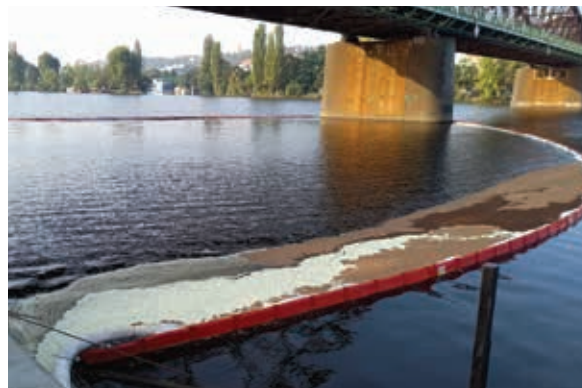
Havárie Vltava – železniční most Výtoň
