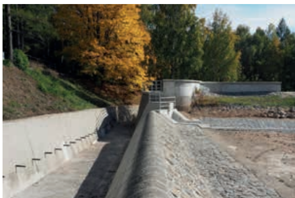
Pilský potok, VD Pílská – oprava betonových konstrukcí bezpečnostního přelivu, skluzu a hráze
