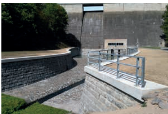
Klíčava, VD Klíčava – sanace betonových částí vývaru a čištění kamenných zdí
