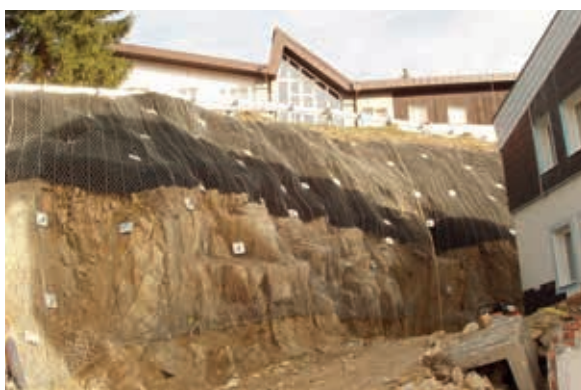
VD Lipno – sanace skalního masivu
