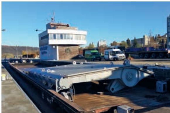
Vitava, VD Modřany – oprava horních vrat plavební komory
