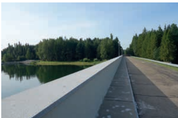
ŽELIVKA – VD ŠVIHOV – OPRAVA VLNOLAMU, CHODNÍKU A ZABRADLÍ NA SO
