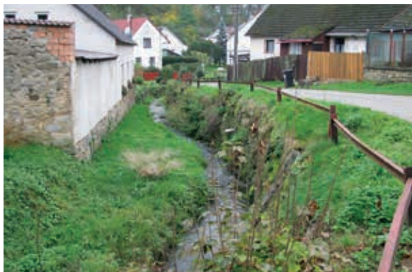
DVT KAMENITÝ POTOK – ÚPRAVA KORYTA PŘED REALIZACÍ
