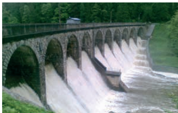
VODNÍ DÍLO SEDLICE NA ŽELIVCE – VODNÍ LÍČ HRÁZE
