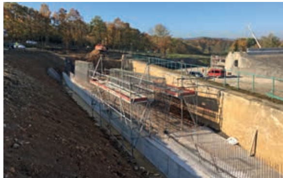
VODNÍ DÍLO KLABAVA – REKONSTRUKCE BEZPEČNOST. PŘELIVU
