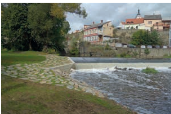
MŽE-STŘÍBRO – OPRAVA PRAVOBŘEŽNÍ ZDI JEZU
