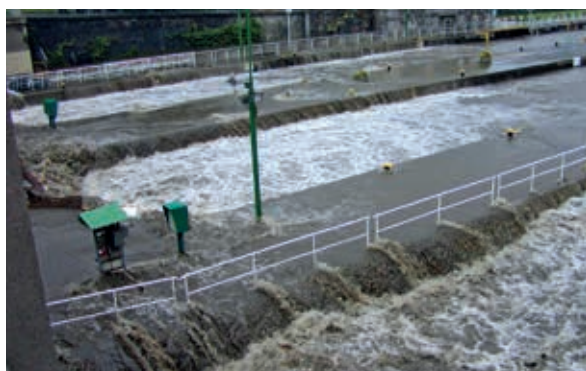
PLAVEBNÍ KOMORA ŠTVANICE
