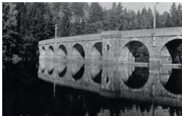
VODNÍ DÍLO SEDLICE NA ŽELIVCE
