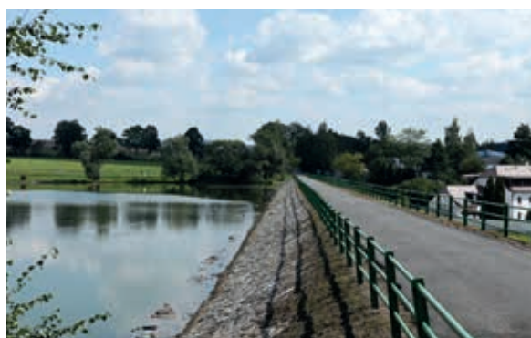
VODNÍ NÁDRŽ PILSKÁ – POHLED NA HRÁZ
