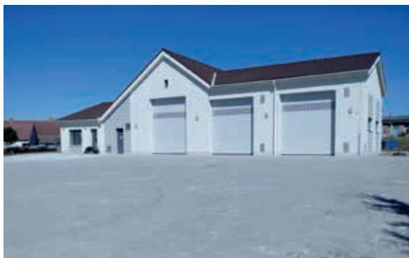
VESELÍ NAD LUŽNICÍ – PROVOZNÍ ZÁZEMÍ
