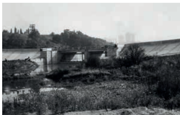
VODNÍ DÍLO ČESKÉ ÚDOLÍ – NÁVODNÍ LÍČ HRÁZE
