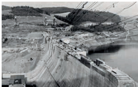
VODNÍ DÍLO ORLÍK – POHLED NA HRÁZ Z LEVÉHO BŘEHU
