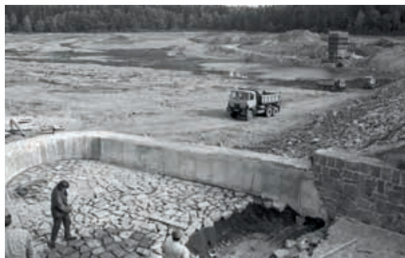
VODNÍ DÍLO LÁZ – STAVBA BEZPEČNOSTNÍHO PŘELIVU
