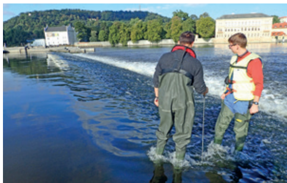
Technickobezpečnostní prohlídka Staroměstského jezu
