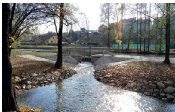
Sázava, Havlíčkův Brod – rekonstrukce pravobřežní zdi a propusti
