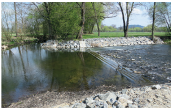
Úhlava, jez Poborovice – rekonstrukce pevného jezu
