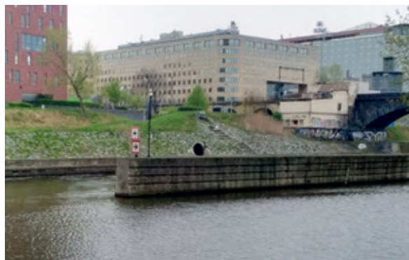
Vltava, Karlín, oprava opevnění – po odstranění škod
