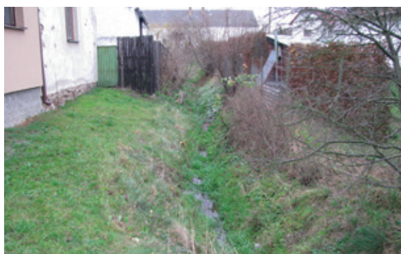
DVT Křížanovský potok, oprava opevnění koryta – před realizací
