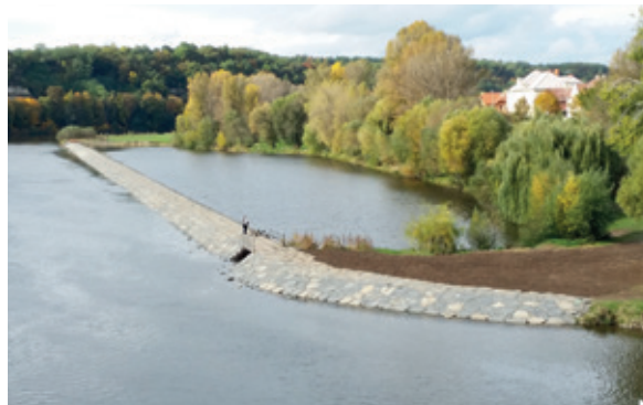
Vltava, zdrž Miřejovice – koncentrační hráz – rekonstrukce opevnění
