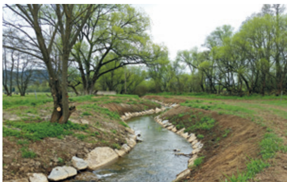
Úšovický potok, Úšovice – oprava opevnění
