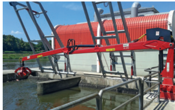
MVE Klecany – rekonstrukce technologie
