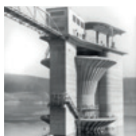
Stavba VD Želivka
