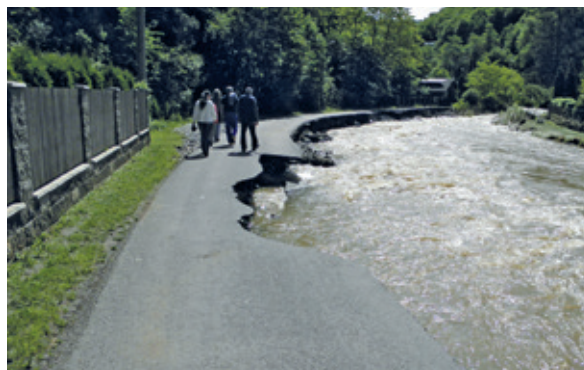
Kocába, Štěchovice, oprava opevnění – po povodni
