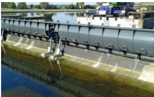
Vltava, VD Vraňany, oprava technologie levého jezového pole
