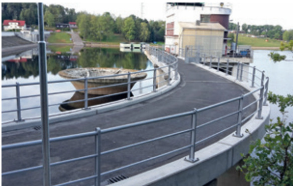
VD Hracholusky – rekonstrukce přemostění
