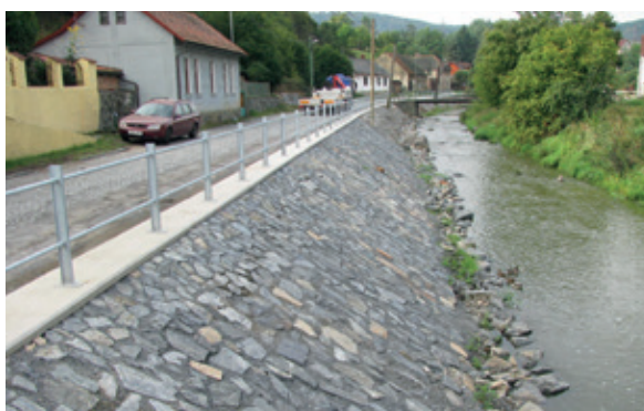
Kocába, Nový Knín – úprava opevnění
