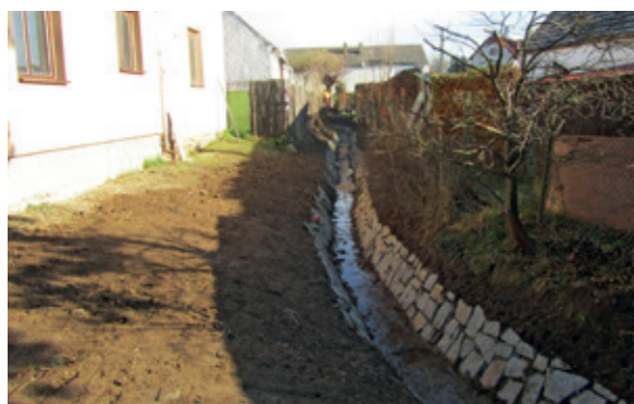
DVT Křížanovský potok, oprava opevnění koryta – po realizaci
