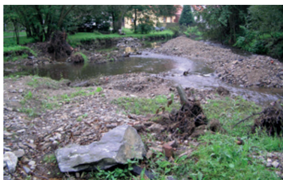
Zlatý potok, Čichtice, obnovení průtočného profilu – po povodni
