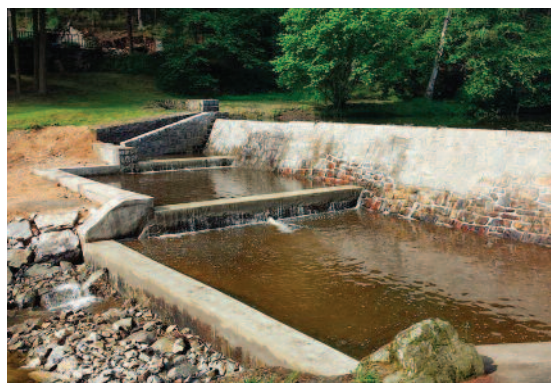
Křemžský potok – jez Dívčí kámen po odstranění povodňových škod
