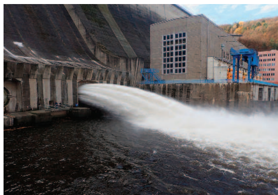
Provozní zkouška spodních výpustí na VD Orlík
