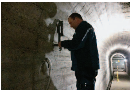
Měření relativních vstříčných posunů pomocí hydrostatické nivelace na VD Orlík
