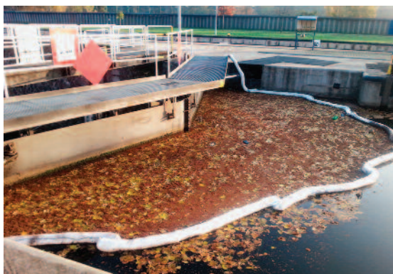
Sorpční norná stěna – plavební komora Podbaba
