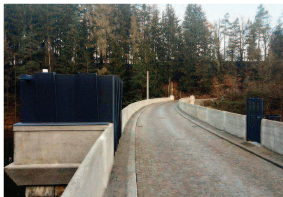
VD Sedlice – rekonstrukce koruny a návodního líce hráze
