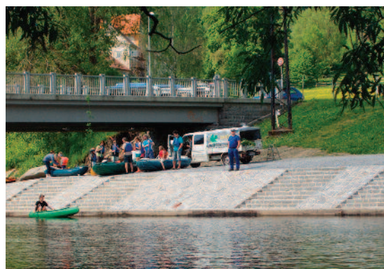
Vltava, Vyšší Brod – ř. km 318,843–318,664 – stavební úpravy pravého břehu
