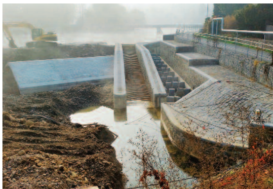
Rekonstrukce jezu Černošice, Berounka ř. km 8,143, část díla SO 02 Rybí přechod
