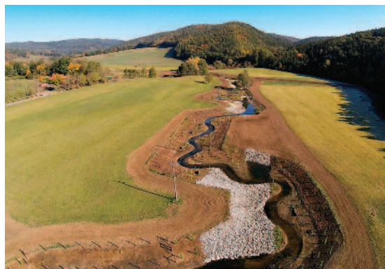
Loděnice, Nenačovice – revitalizace toku
