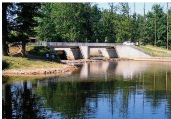
Lužnice – Novořecké splavy po odstranění povodňových škod
