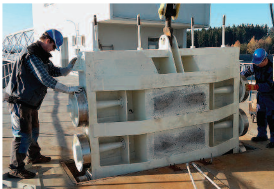
VD Želivka – modernizace zdvihacích mechanismů a oprava tabulí rychlouzávěru spodních výpustí
