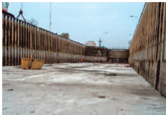
Vodní dílo Dolánky – rekonstrukce dna plavební komory
