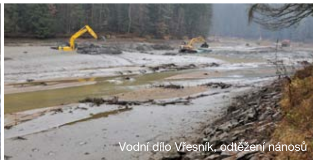
Vodní dílo Vřesník, odtěžení nánosů
