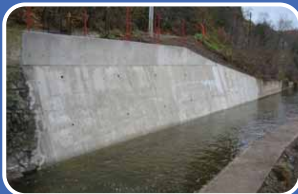
Berounka – Sýkořice, oprava opěrné zdi levého břehu
