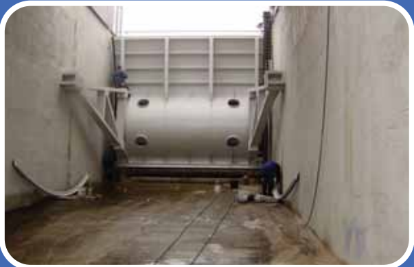
Malše – VD Římov, oprava nátěrů segmentů
