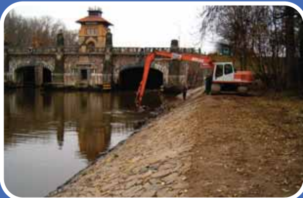
Vltava – plavební kanál Hořín, sanace břehu
