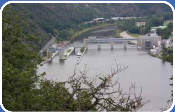
Vltava – VD Vrané, oprava nátěrů mostovky
