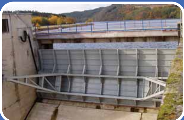
Vltava – VD Kamýk, oprava bočních segmentů
