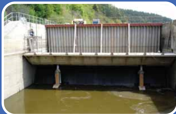
Vltava – VD Kořensko, oprava nátěrů klapky
