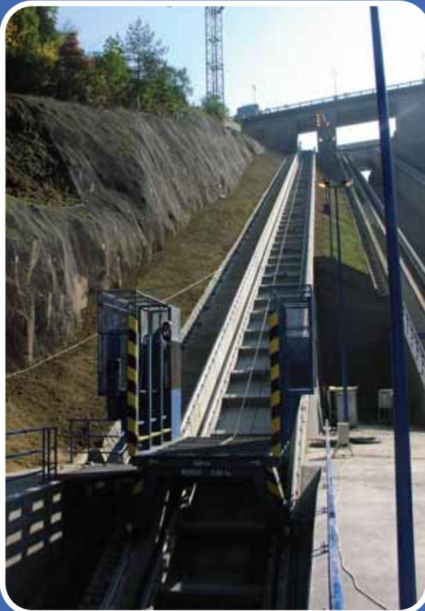
Vltava – VD Orlík, oprava plavebních zařízení
