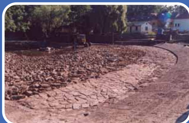
Lužnice – Tábor, oprava jezu Pokorný
