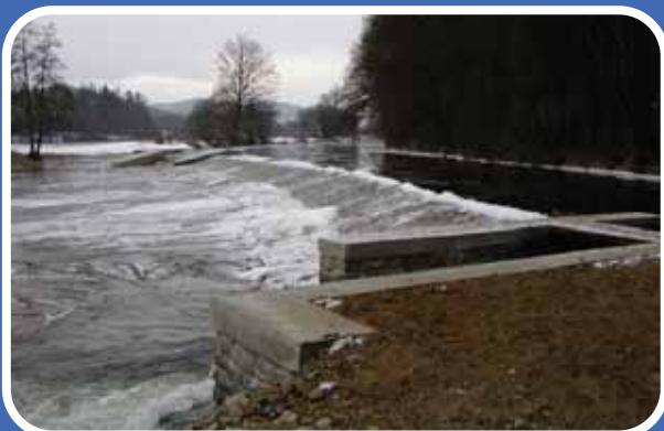
Otava – Prácheň, oprava jezu
