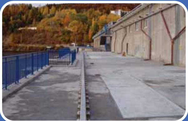
Vltava – VD Orlík, oprava návodní plošiny
