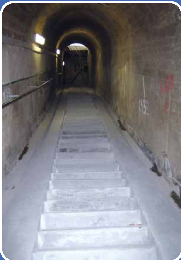
Mže – VD Hracholusky, oprava schodů štoly
