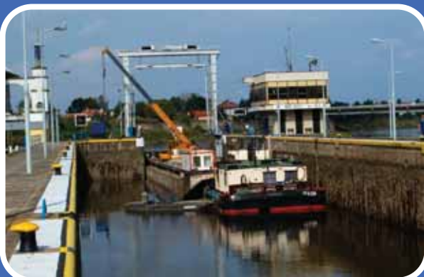
Vltava – velká plavební komora Miřejovice, oprava dna
