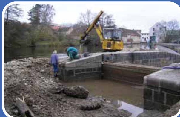
Otava – Katovice, oprava jezu a hráze
