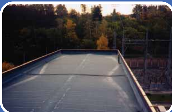
Vltava – VD Vrané, oprava střechy strojovny
