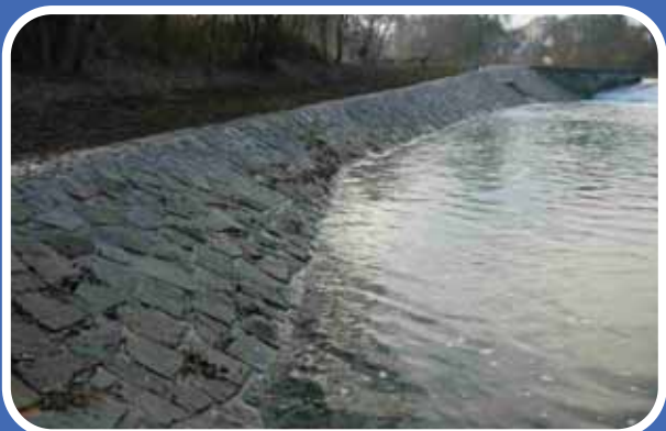
Radbuza – Plzeň-Doudlevec, oprava dlažeb
