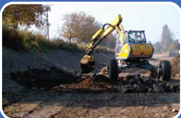
Vltava – laterální kanál Vraňany-Hořín, oprava opevnění
