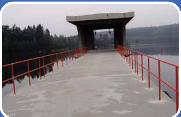
Trnava – VD Trnávka, oprava mostovky
