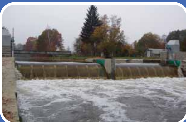
Blanice – Vodňany, rekonstrukce jezu
