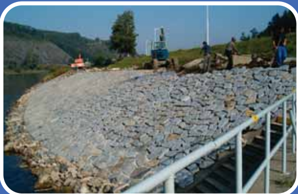
Vltava – VD Dolany, oprava břehového opevnění
