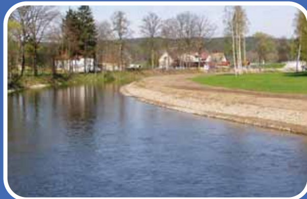
Malše – Plav, oprava koryta
