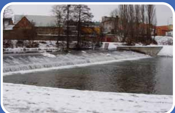
Radbuza – Plzeň-Doudlevice, rekonstrukce jezu
