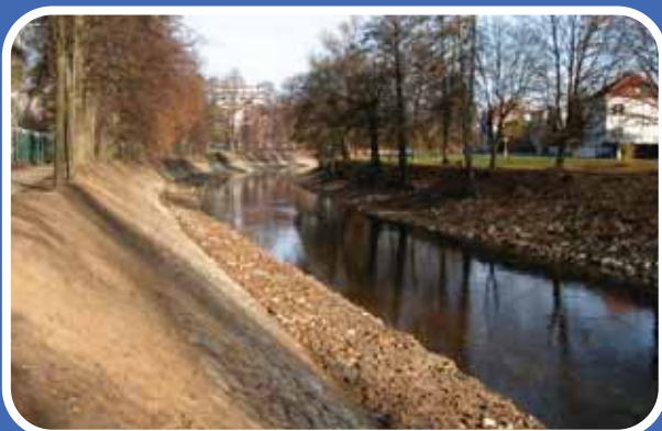
Malše – České Budějovice, oprava koryta
