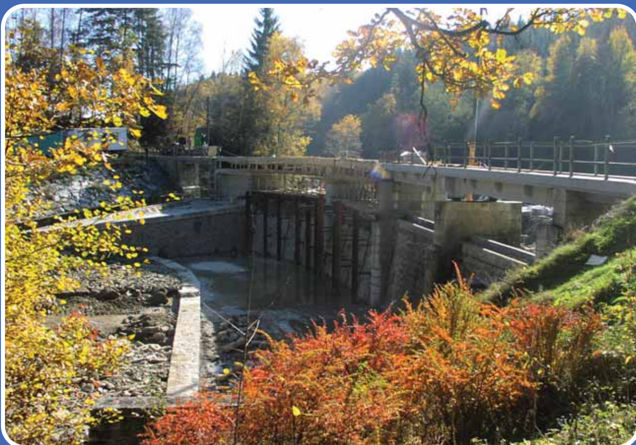
Černá – VD Soběnov, oprava hráze
