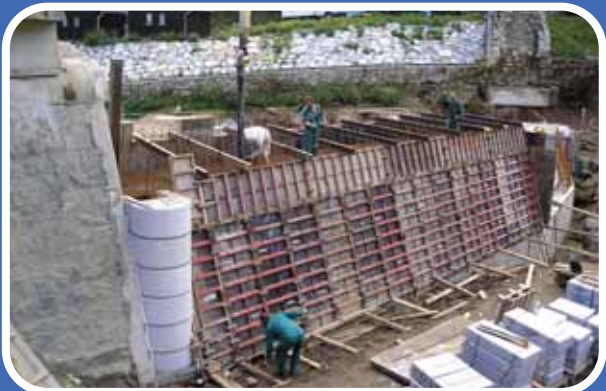
Černá – VD Soběnov, oprava hráze
