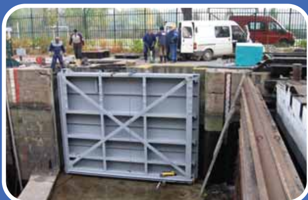
Vltava – Praha-Smíchov, oprava vrat plavební komory
