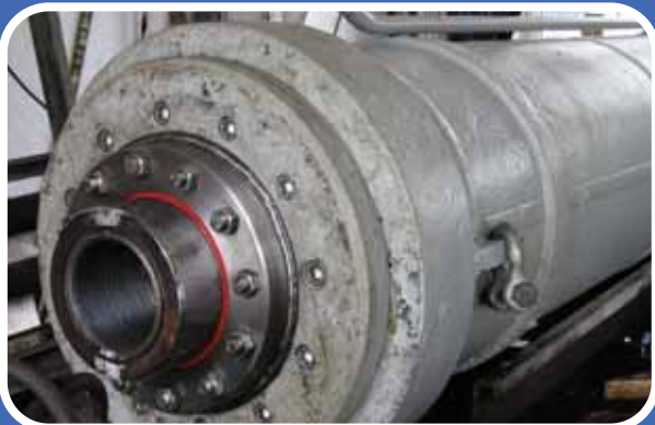
Vltava – VD Klecany, oprava pravého pole
