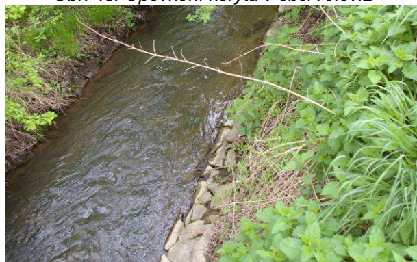
Obr. 45: Opevnění koryta v extravilánu obce Jemníky
