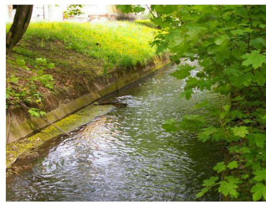
Obr. 20: Betonové koryto na konci vesnice Olovnice je navrhováno odstranit a nahradit kamennou rovnaninou a změnit tvar koryta
