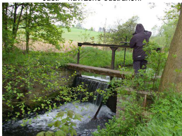
Obr. 38: Rozdělovací objekt u rybníku Otrok tvoří migrační překážku- zde je navržen rybí přechod
