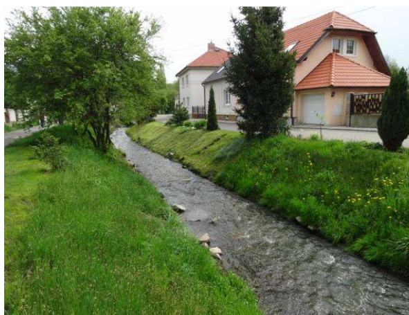
Obr. 11: Přítomnost balvanů v upraveném korytě zvyšuje diverzitu proudění a je důležitá pro zlepšení
