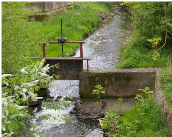
Obr. 36: Hradítko před vtokem do zatrubněné části – navrženo odstranění
