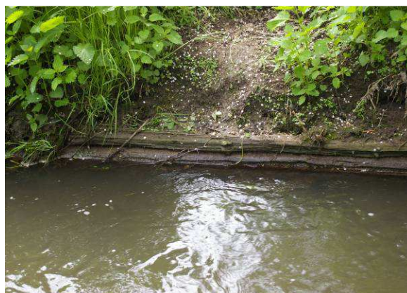
Obr. 25: Laťový plůtek opevňující svahy toku mezi Obcí Neuměřice a Kamenný most je navrženo odstranit
