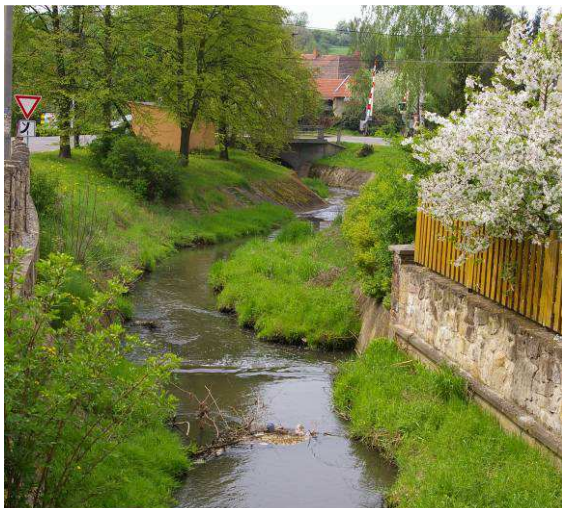
Obr. 22: Betonové koryto v obci Olovnice – navrhováno zachovat tvar koryta, ale jako opevnění břehů použít kamenný zához
