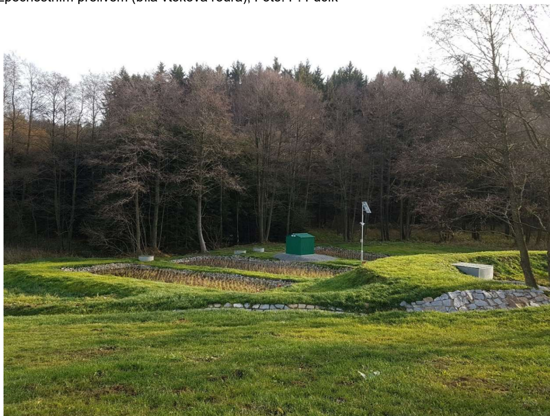
Retenční experimentální mokřad s předřazeným akumulacním objektem. Foto: P. Fučík
