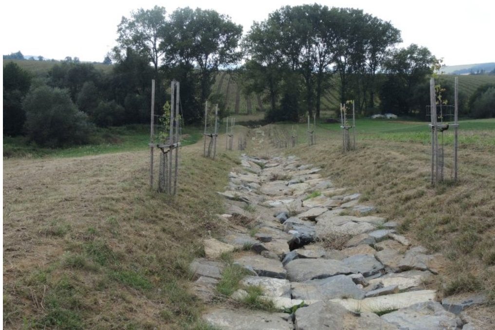
Liniová zeleň podél svodného průlehu v k.ú. Pašovice na Moravě (Zdroj: http://www.spucr.cz )
