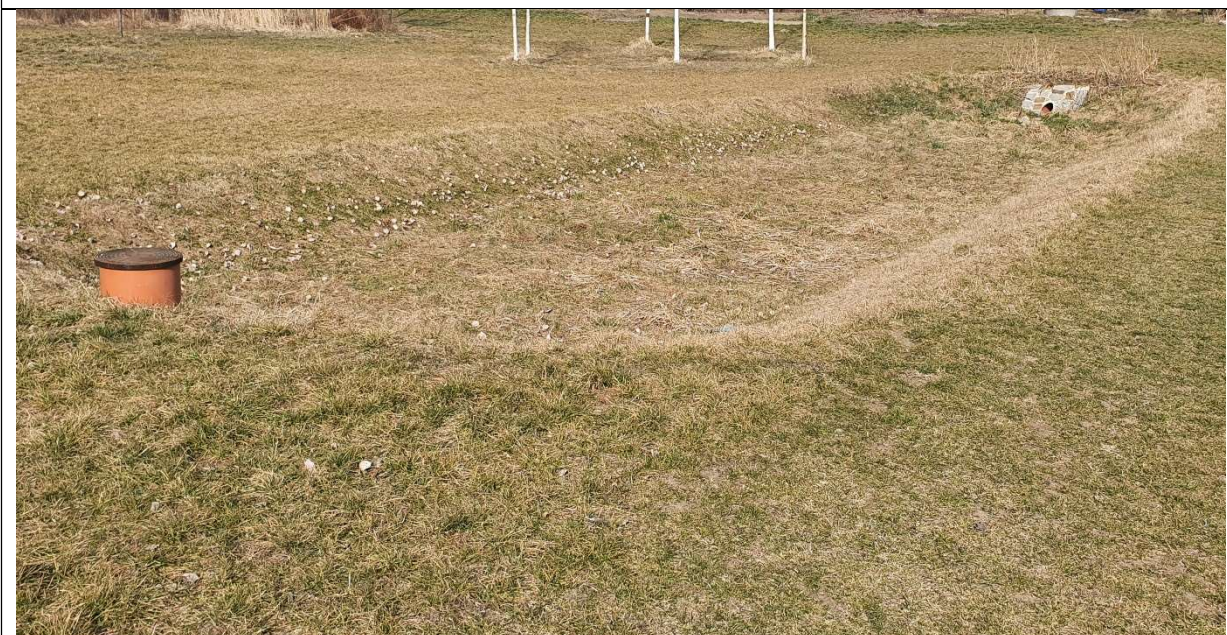
Příklad kombinace vsakovacího průlehu a vsakovací rýhy v k.ú. Syrovice (foto AQUATIS a.s.)
