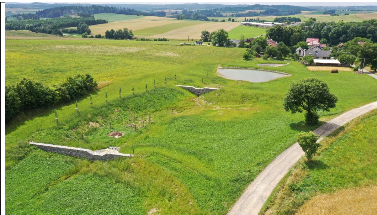
Zděné přehrážky v k.ú. Dlouhé na Moravě (okres Žďár nad Sázavou) (zdroj: Karásek , VÚMOP)
