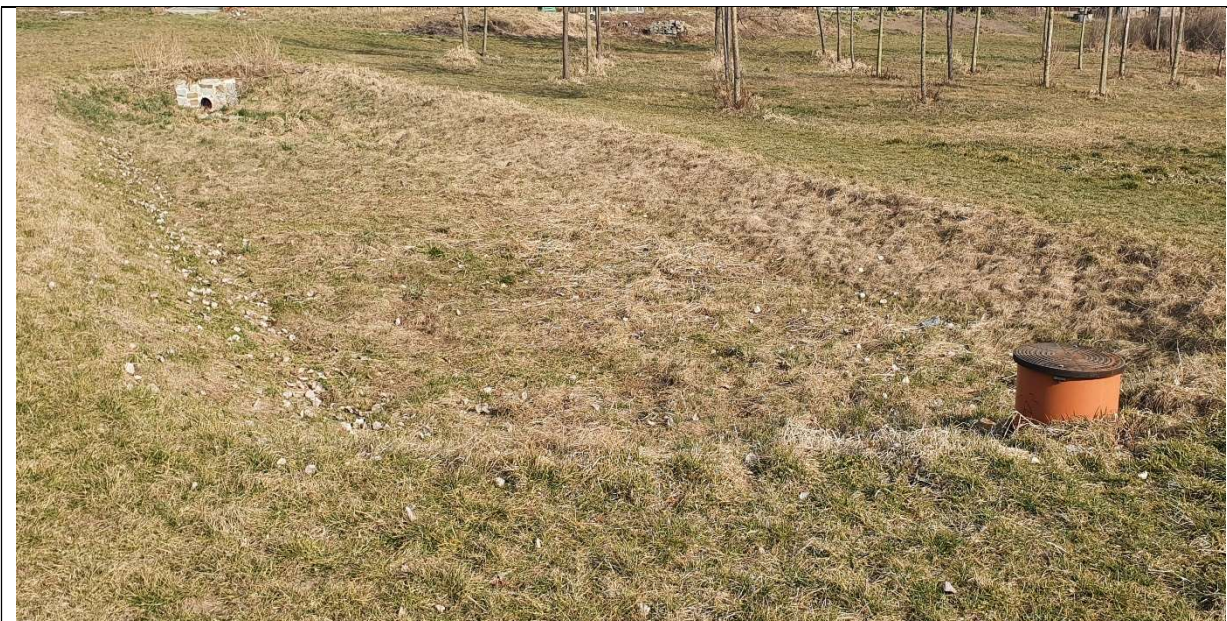
Příklad kombinace vsakovacího průlehu a vsakovací rýhy v k.ú. Syrovice (foto AQUATIS a.s.)
