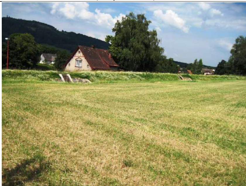
Ochranná hrázka nad obcí Dolní Brusnice se systémem výpustných zařízení (Zdroj: Navrhování TPEO, Václav Kadlec a kol., 2014)
