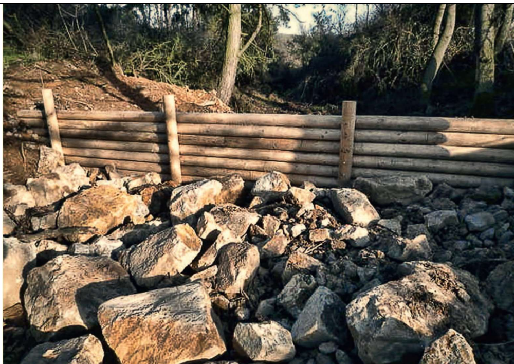
Balvanitý skluz pod vybudovanou přehrážkou na zaniklé cestě (zdroj: Mazín, Státní pozemkový úřad)
