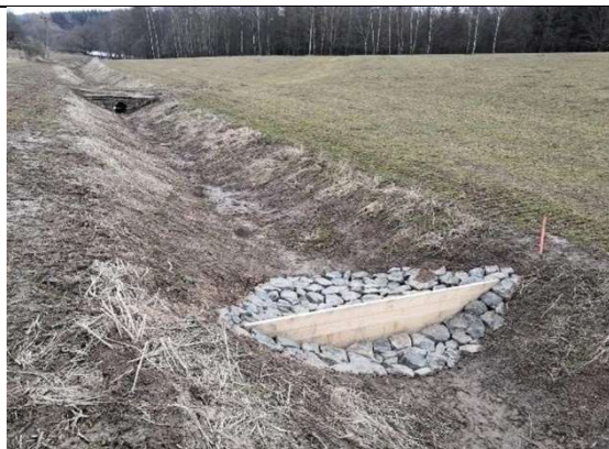
Přehrážky v odvodňovacích příkopech (HOZ) vyptvářející pasivní regulaci odtoku (zdroj: P. Fučík VÚMOP)
