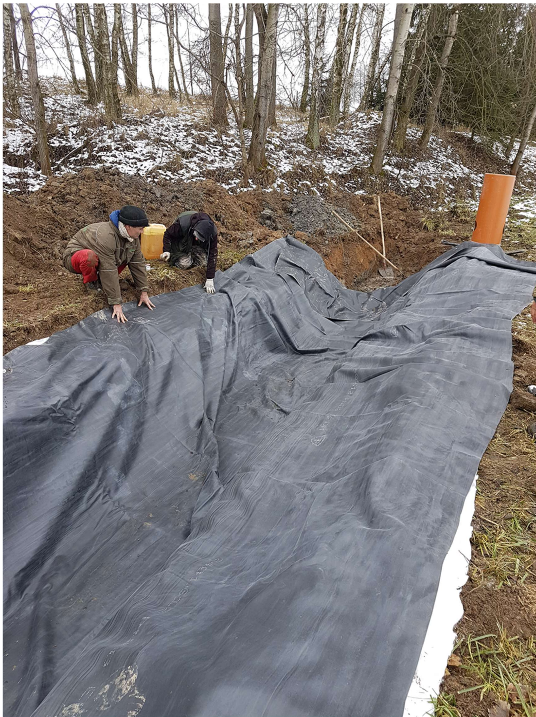
Instalace fóliového lože biofiltru. Foto: P. Fučík
