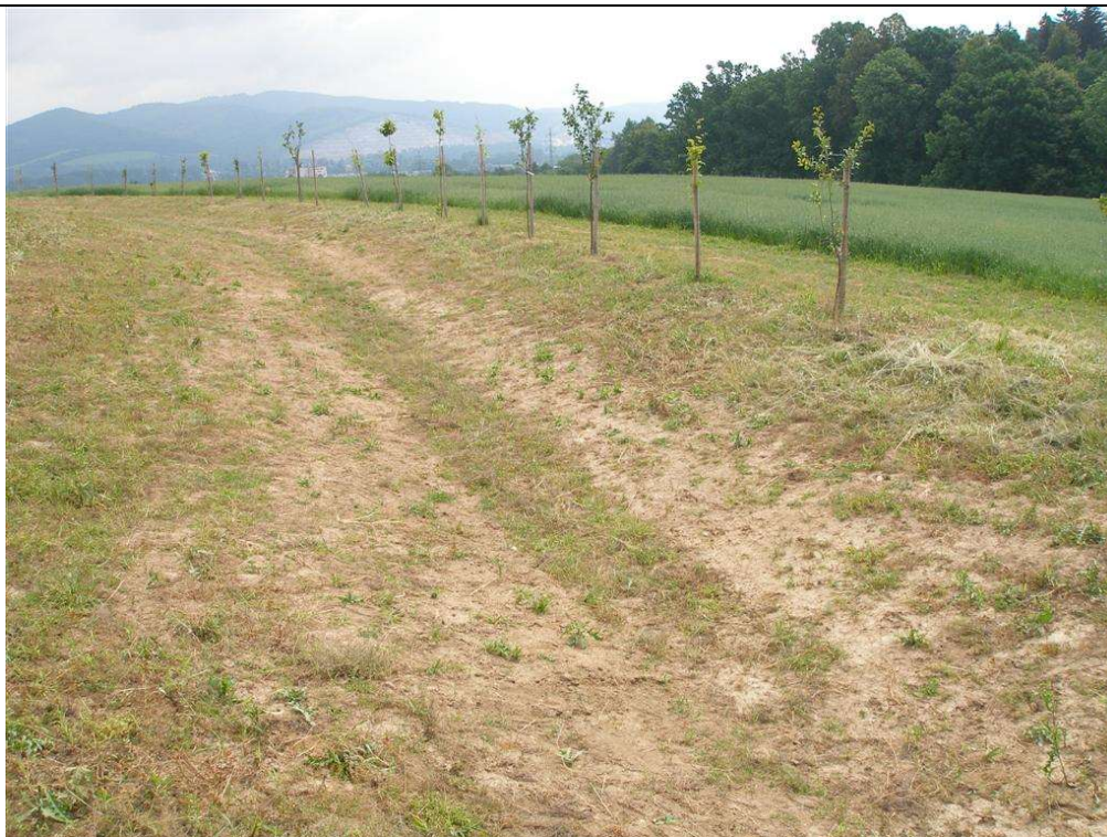
Zatravněný retenční průleh u města Zábřeh na Moravě (zdroj http://www.zabreh.cz/ )
