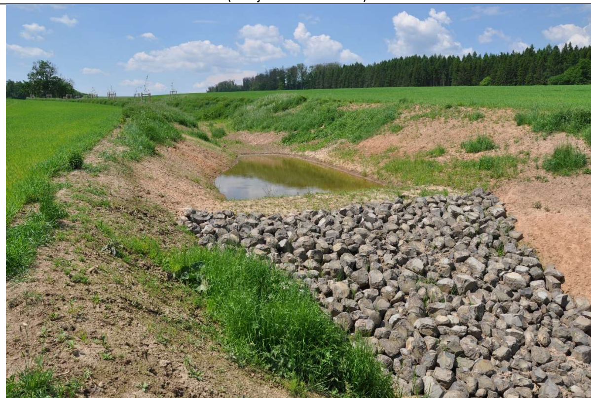
Přehrážky v odvodňovacích příkopech (HOZ) vyptvářející pasivní regulaci odtoku (zdroj: P. Fučík VÚMOP)
