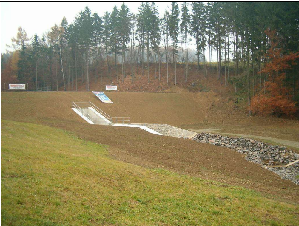
Suchá vodní nádrž Čermná II – koryto pod hrází (foto Sweco Hydroprojekt a.s.)
