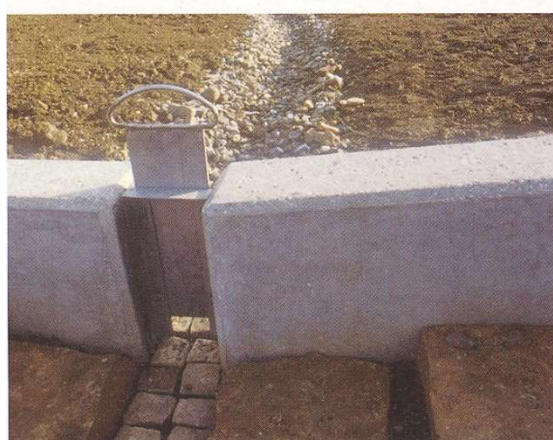
Systém rebulace odtoku v intravilánu v dráze soustředěného odtoku formou přehrážek s hradítky (zdroj: Německo)
