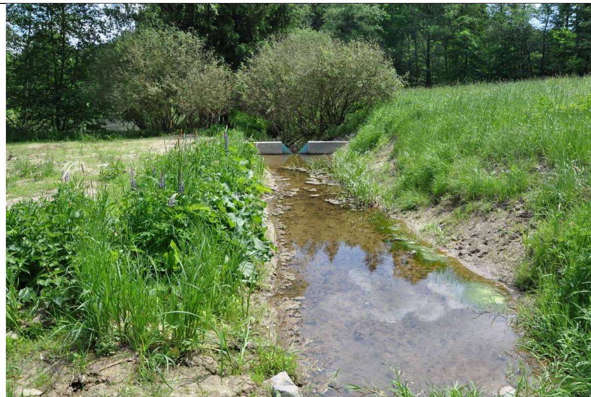
Přehrážky v odvodňovacích příkopech (HOZ) vyptvářející pasivní regulaci odtoku (zdroj: P. Fučík VÚMOP)
