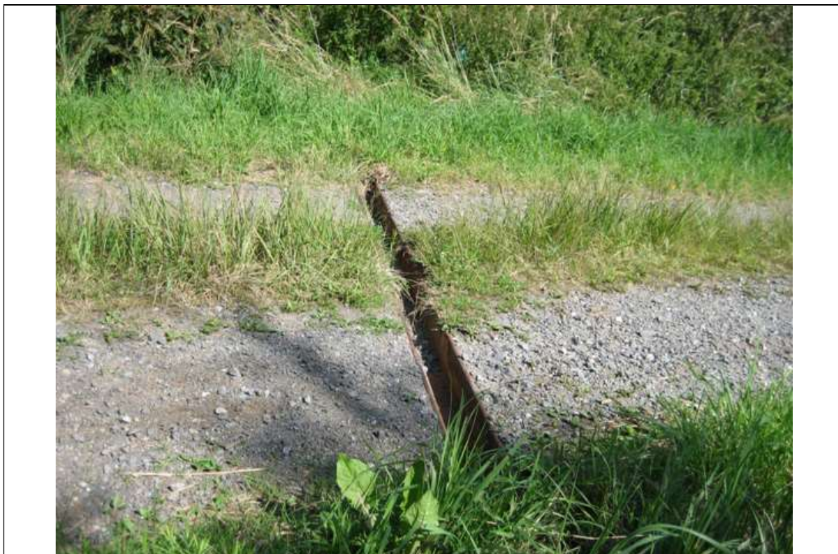
Příklad ocelové svodnice (E-shop L.E.S. CR spol. s r.o. / Katalog / Ocelové svodnice vody)
