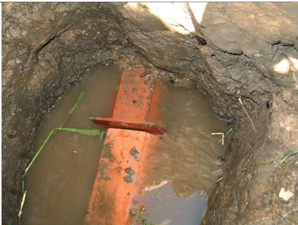
Záslepka na svodném drénu (Foto: Z. Kulhavý)
