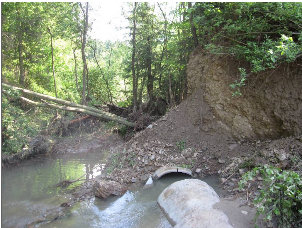
Obrázek č. 3 – Tok Pardidub – Zruč nad Sázavou - poškozený zemní val střelnice
