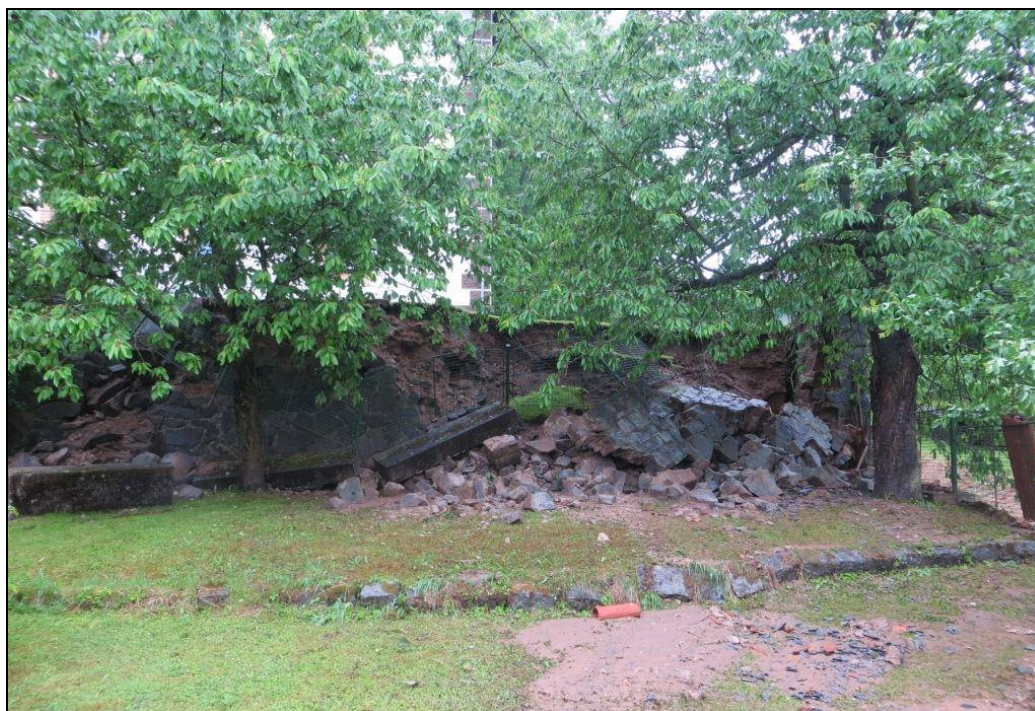
Obrázek č. 2 – Porušení stabilizačního zdiva v areálu PD Kamýk nad Vltavou
