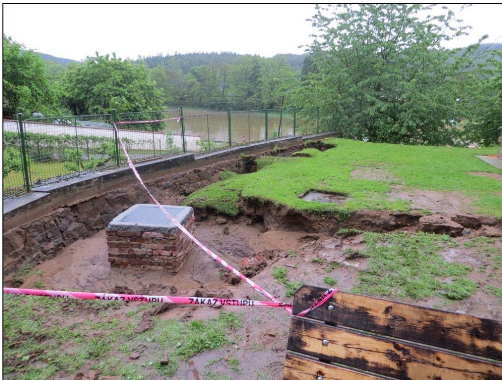
Obrázek č. 1 – Škody v areálu objektu poříčního dozorství Kamýk nad Vltavou
