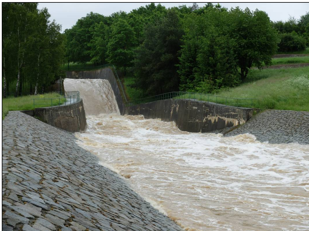
Obrázek č. 9 – VD Klabava – skluz a vývar pod bezpečnostním přelivem
