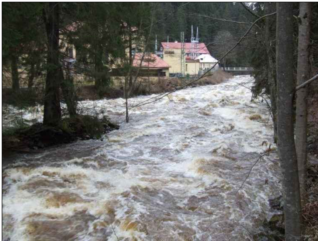
Obr.č. 1 – Vydra nad Čeňkovou pilou
