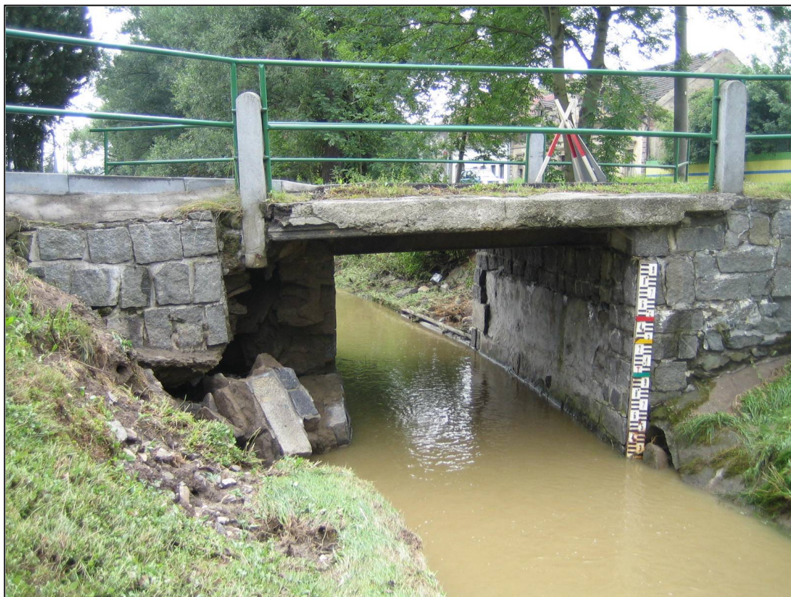
Zubřina – Domažlice Poškozený most k provoznímu objektu Povodí Vltavy (29.7.2006)
