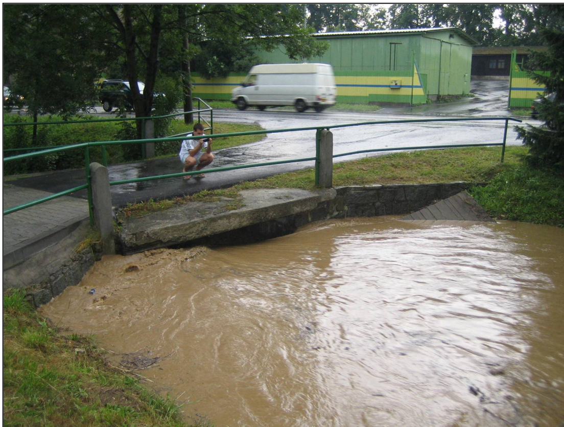
Zubřina – Domažlice Profil mostku u provozního objektu Povodí Vltavy s.p.. - 210 cm 28.7.2006 v 15:25. Průtok odhadnut při kulminaci na 22-25 m 3 .s -1 tj. Q 20
