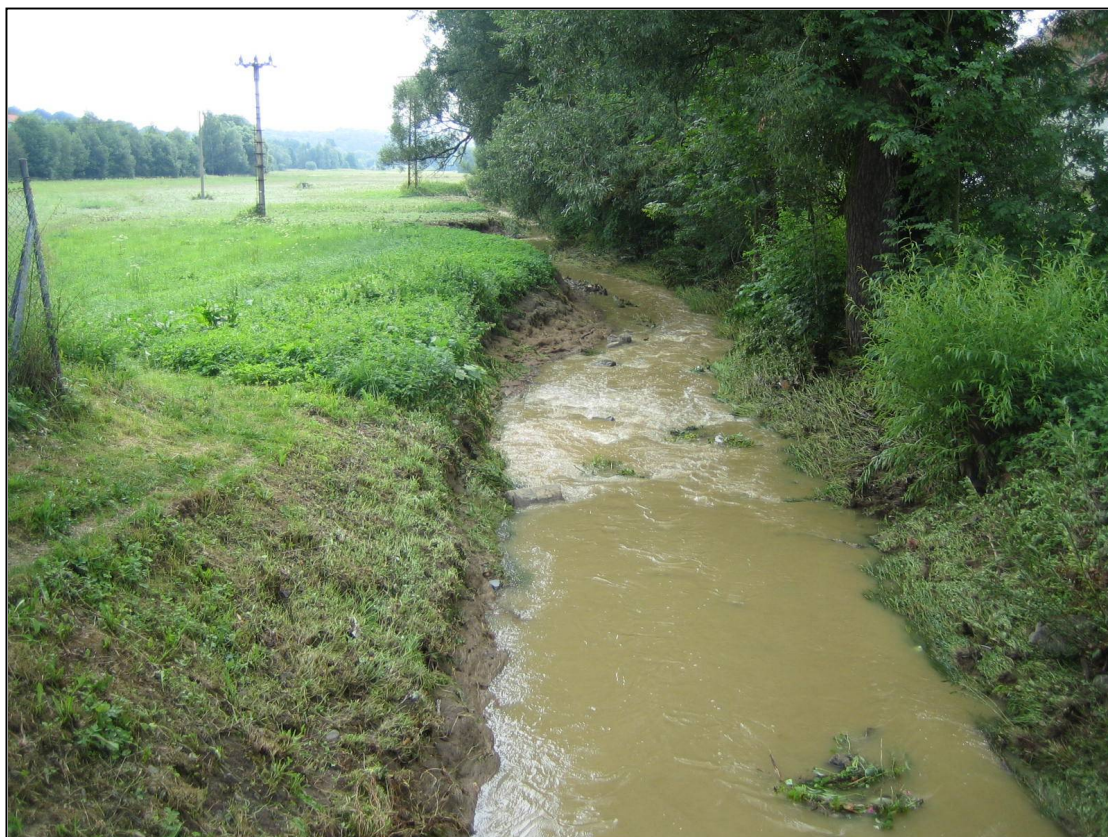
Zubřina – Domažlice Břehové nátrže u provozního objektu Povodí Vltavy (29.7.2006)
