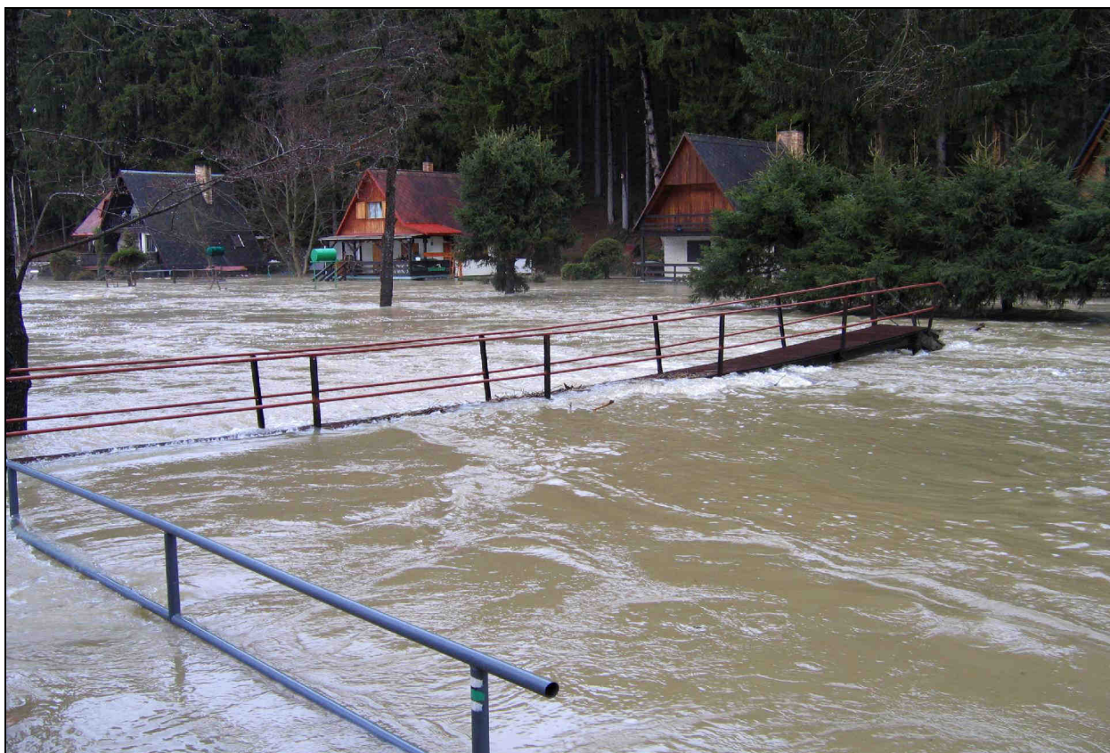
Obr.č. 9 – Stropnice – lávka
