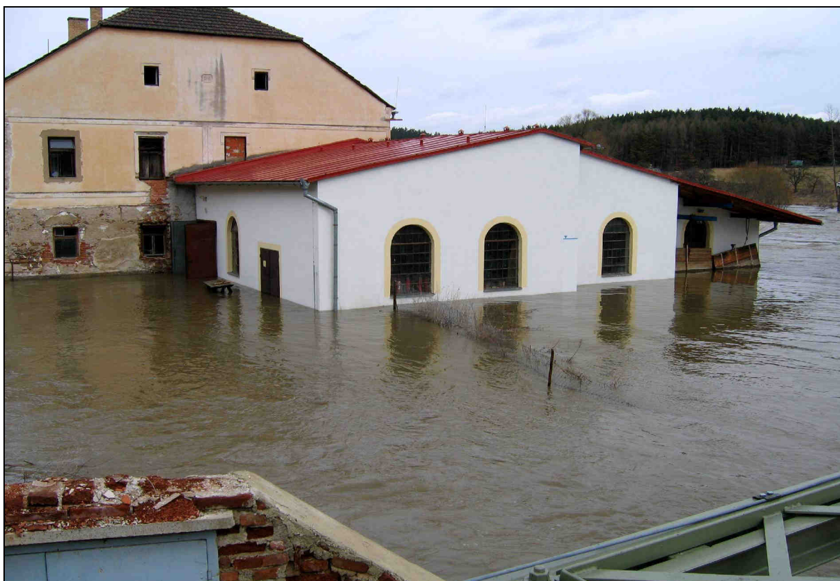
Obr.č. 6 – Lužnice - Dobronice - malá vodní elektrárna
