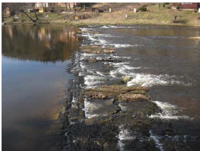
Pohled na poškozený jez
