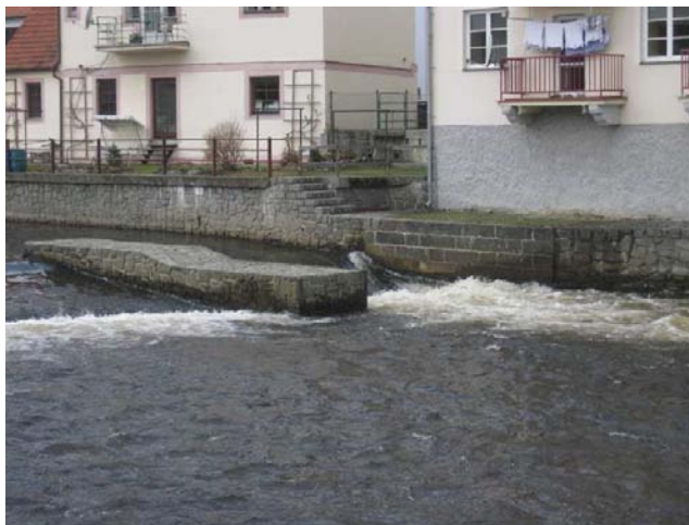
Detail levé strany jezu s propustí
