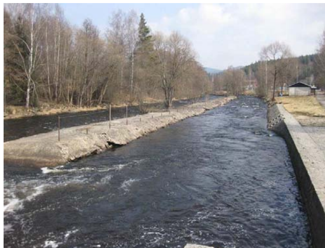
Pohled do podjezí děleného zdí na dvě části
