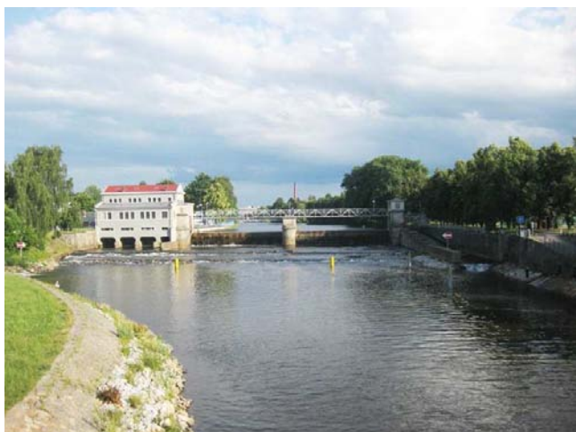
pohled na jez z níže položeného mostu
