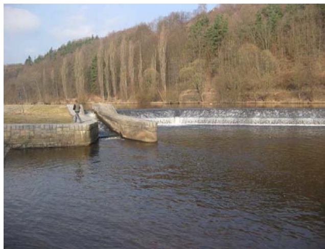
Detail sportovní propusti
