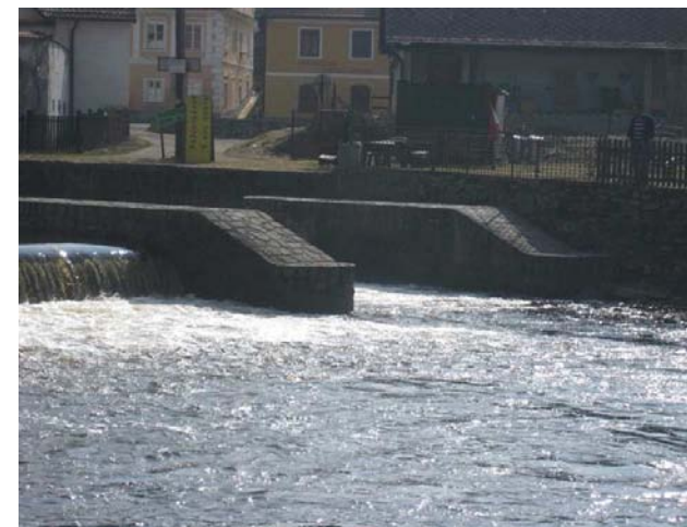
Vorová propust na levé straně jezu
