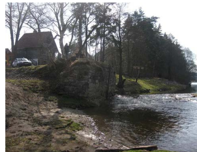
Pohled na poškozený jez, pravý břeh a zbytky mlýnu
