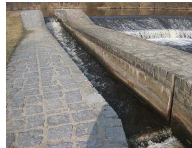
Detail sportovní propusti
