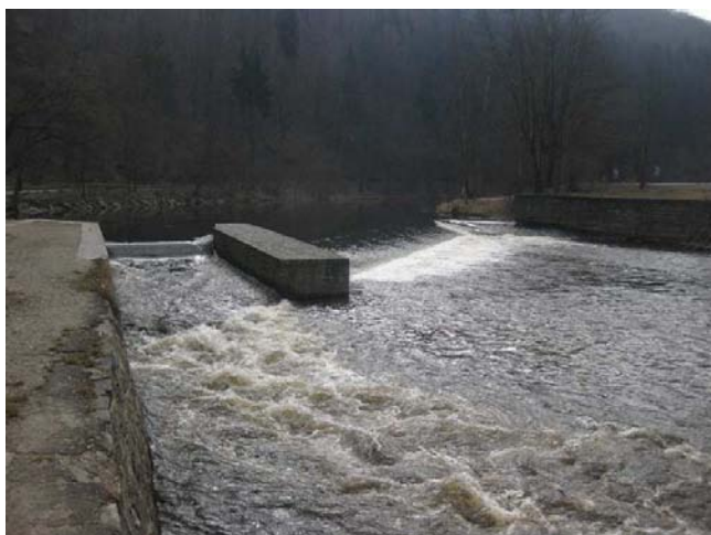
Pohled na jez, na pravé straně propust
