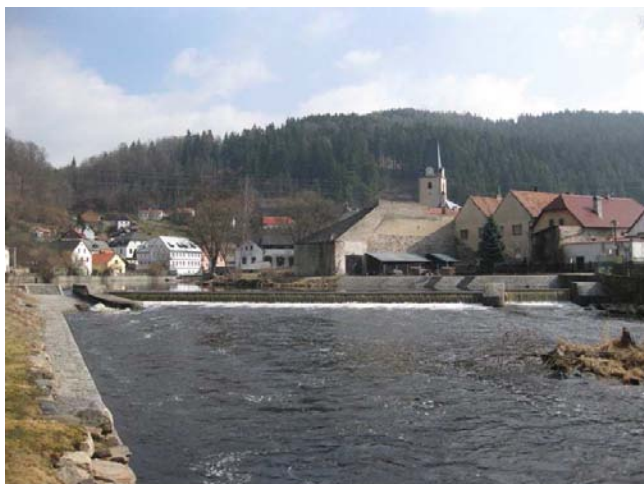
Pohled na jez, sportovní propust na pravém břehu
