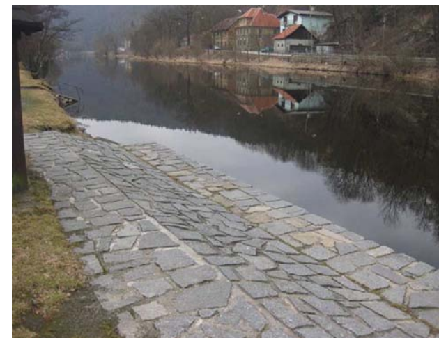
Detail výstupního místa, chybí schůdky
