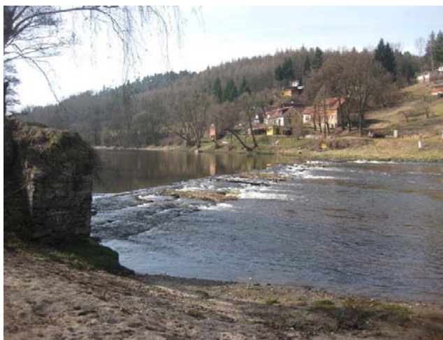
Pohled na poškozený jez
