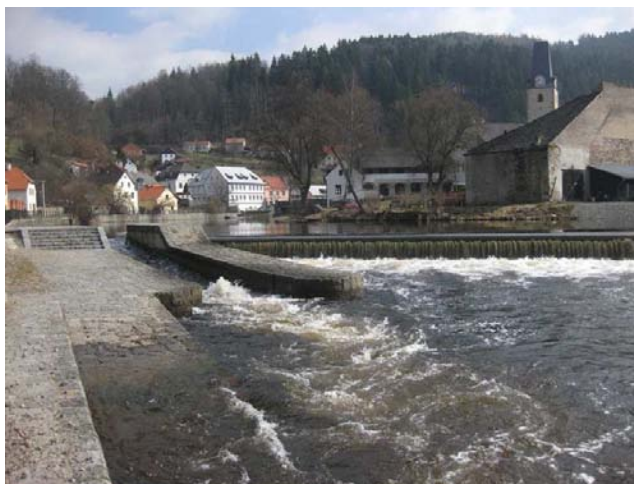
Detail sportovní propusti
