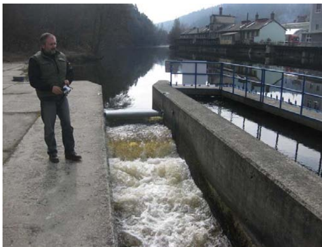
Detail sportovní propusti
