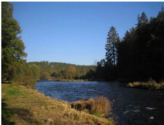
Pohled na poškozený jez
