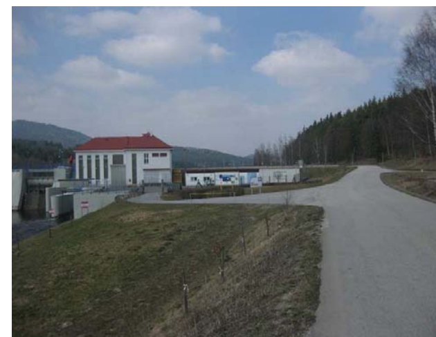
Pohled na MVE
