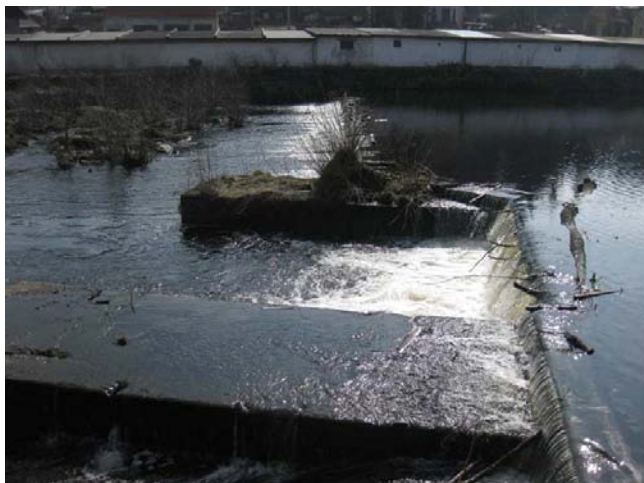
Pohled na jez
