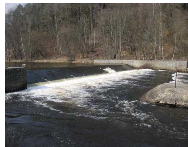
Detail levé části jezu
