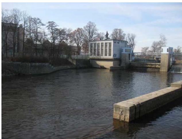
Pohled na pravý břeh a MVE
