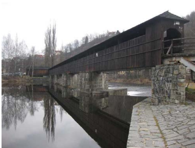
Pohled na jez a rechle shora
