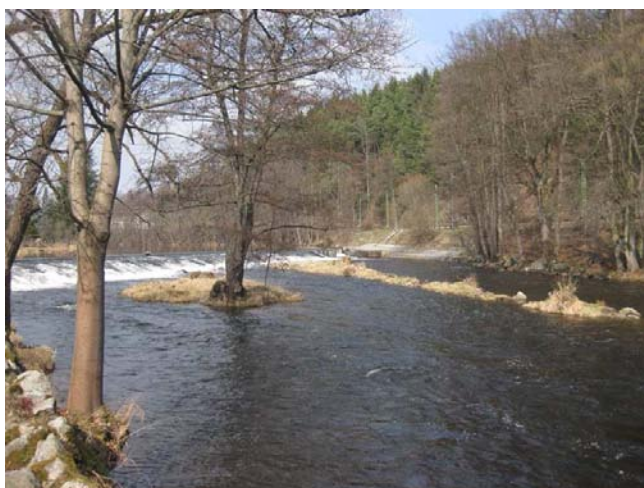
Pohled na jez, na levé straně je vorová propust
