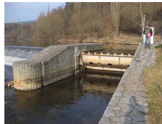
jalová propust hrazená klapkou
