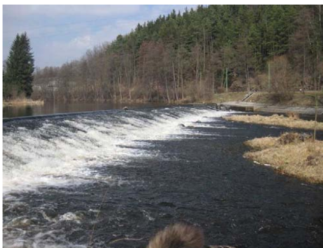
Pohled na jez
