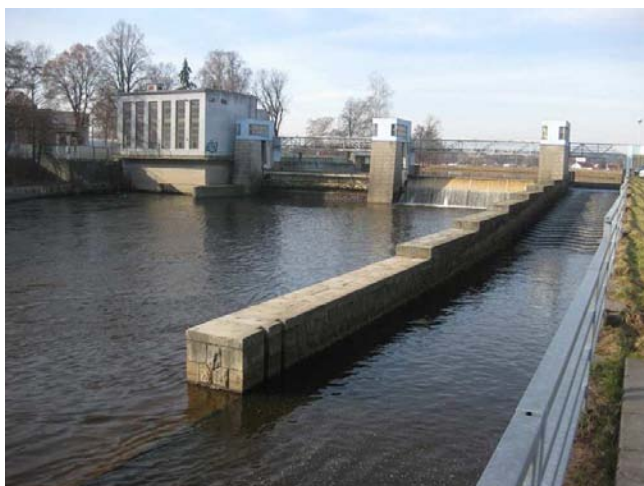
Pohled na jez, vpravo vorová propust, vlevo MVE
