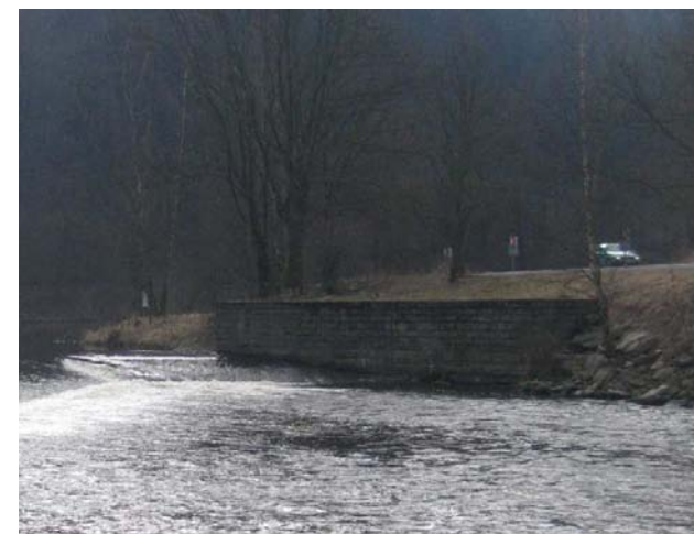
Detail levého břehu
