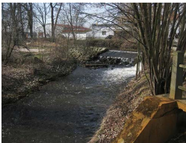
jízek na náhonu u budoucí MVE
