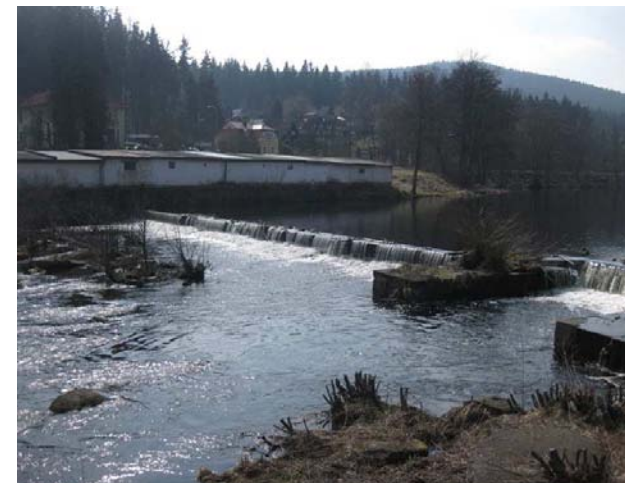
Pohled na jez
