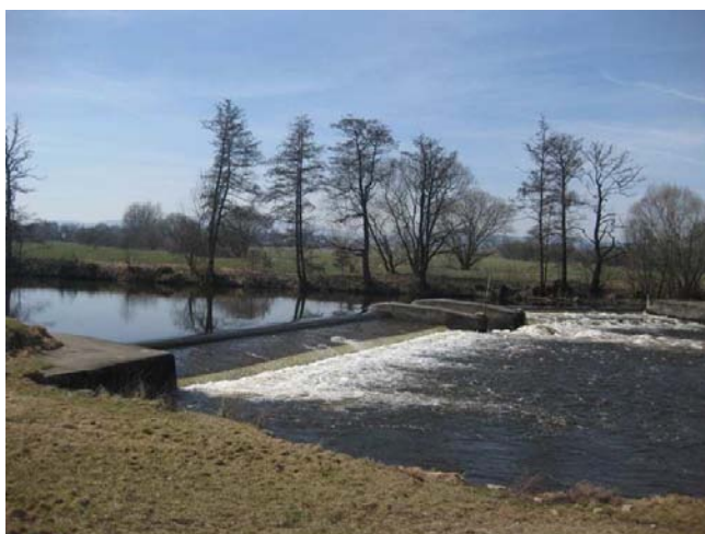
Pohled na hlavní jez, náhon začíná na levém břehu
