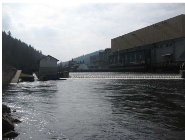
Pohled na jez, MVE a sportovní propust
