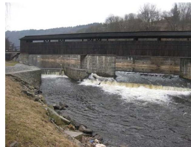
Pohled na jez a rechle, detail pravé strany s propustí
