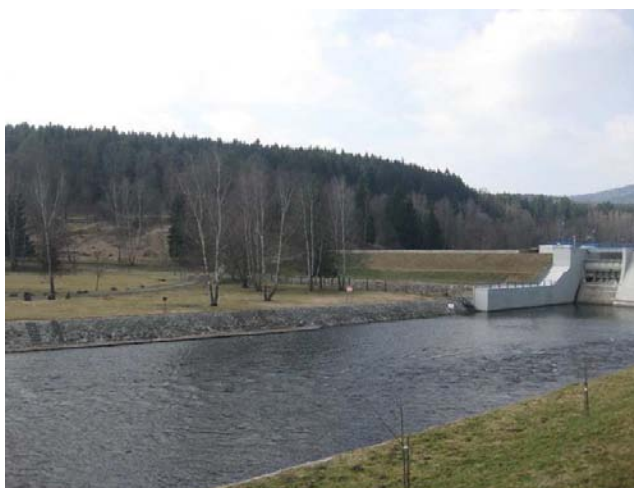
Pohled na podjezí
