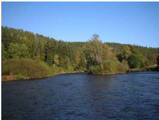
Pohled na poškozený jez
