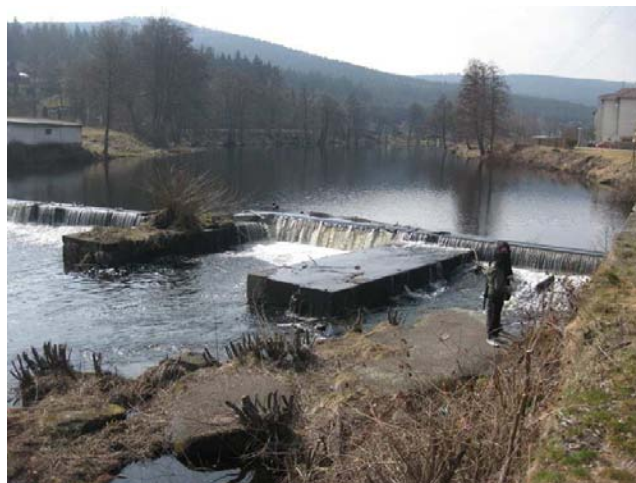
Pohled na jez, detail pravé strany s propustí
