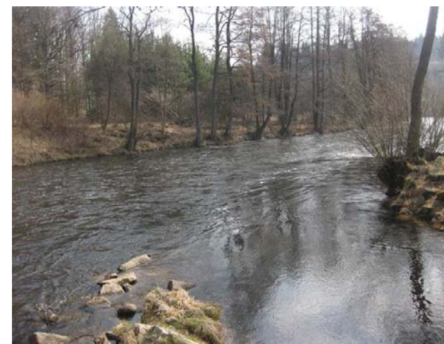
Pohled na podjezí
