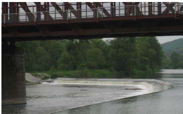
Detail pravého břehu se skluzem pro vodáky
