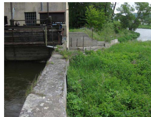
Pohled na MVE a místo vedení RP na levé straně
