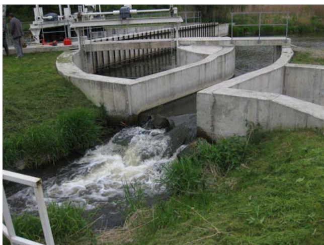
Výstup z RP, pravděpodobně neprůchodný
