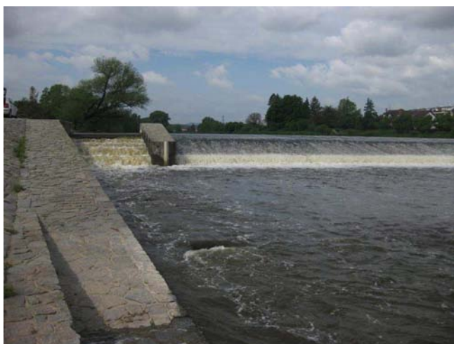
Pohled na pravou část jezu
