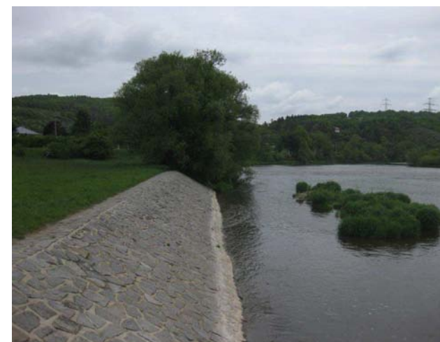
Zpevněné podjezí na levém břehu
