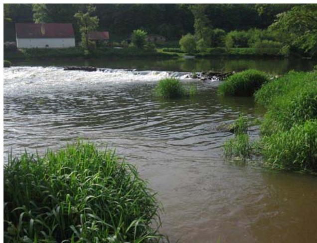
Stávající stav jezu, levá strana a ústí Třemošné
