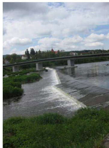
Pohled na jez od MVE
