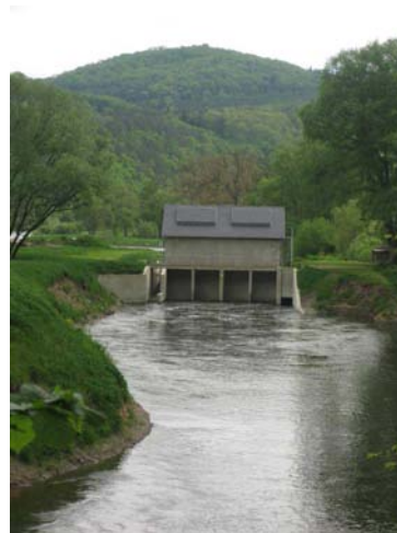
Pohled na MVE
