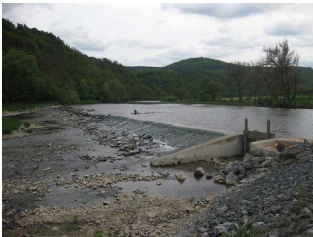
Pohled na jez
