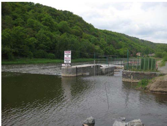
Pravá strana jezu se vstupem do náhonu a vodácké dráhy
