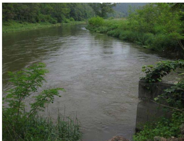
Odpad z levé MVE přímo do Berounky
