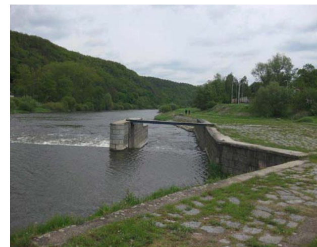
Pohled na propust z nadjezí – místo budoucí MVE
