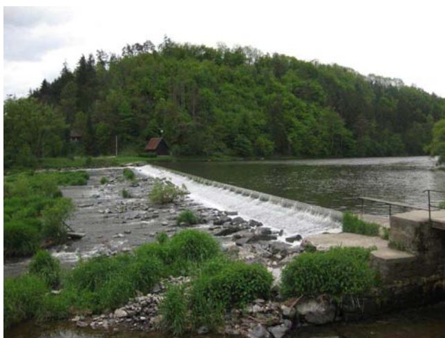
Pohled na jez, v levé části štěrková propust
