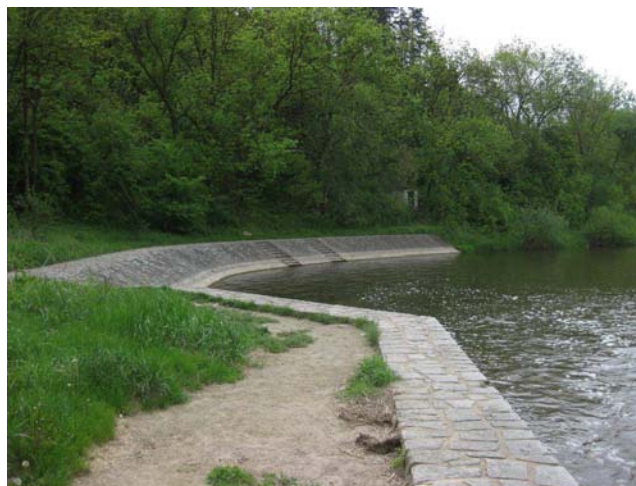
Detail zpevněného břehu v podjezí
