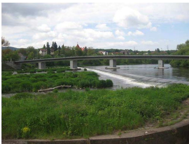
Pohled na jez od MVE
