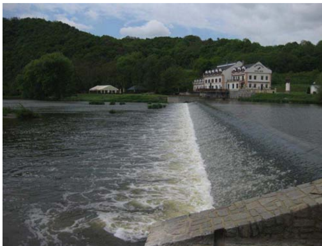
Pohled na jez
