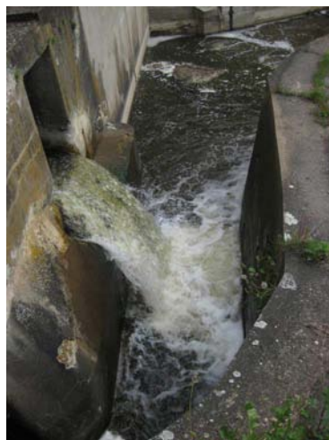
Pohled na jalovou propust a odpad od MVE
