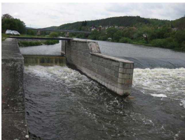
Pravá strana jezu se štěrkovou propustí
