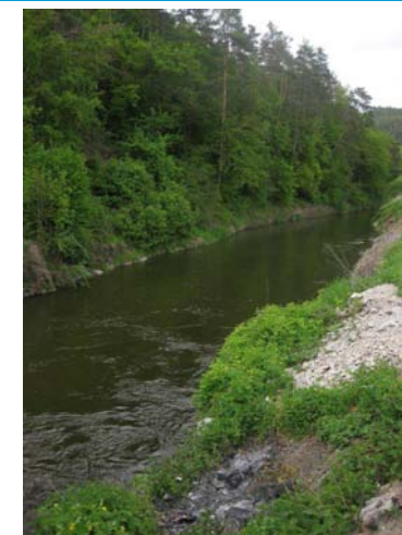
Odpadní kanál od MVE
