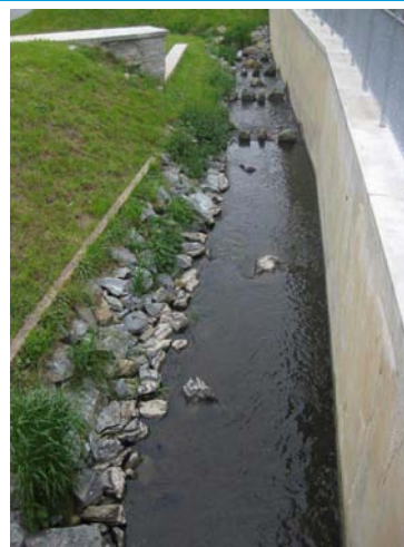
RP s nedostatečným průtokem
