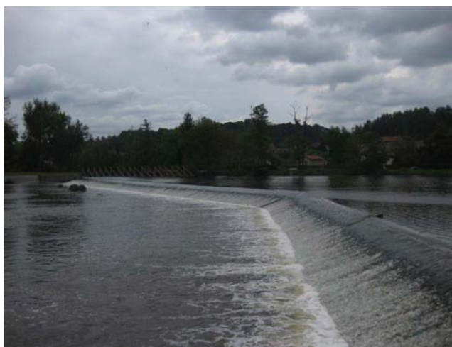
Pohled na jezovou hranu
