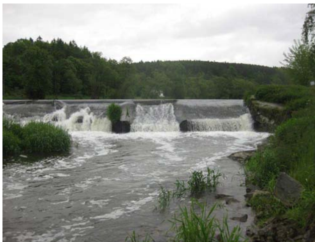
Detail levé strany jezu
