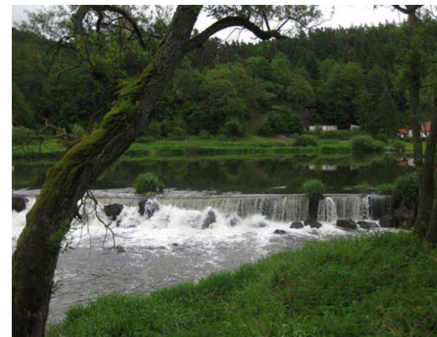
Detail levé části jezu
