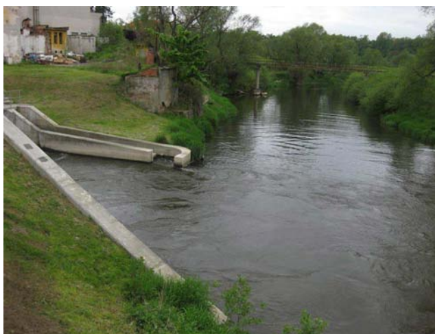
Štěrbinový RP, vstup
