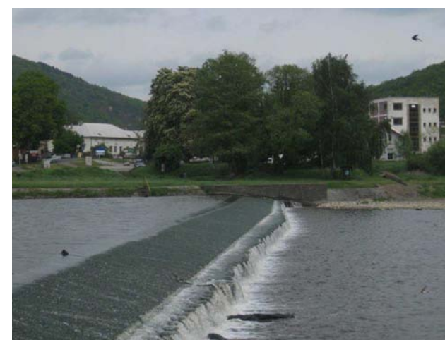
Detail levého břehu
