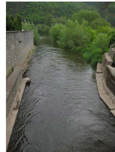
Odpadní kanál od MVE
