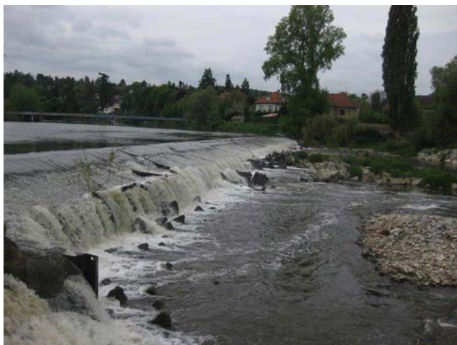
Pohled na jez z pravé strany od MVE
