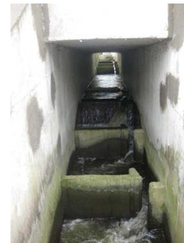
Štěrbinový RP, ucpané štěrbininy
