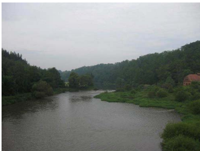
Celkový pohled na jez
