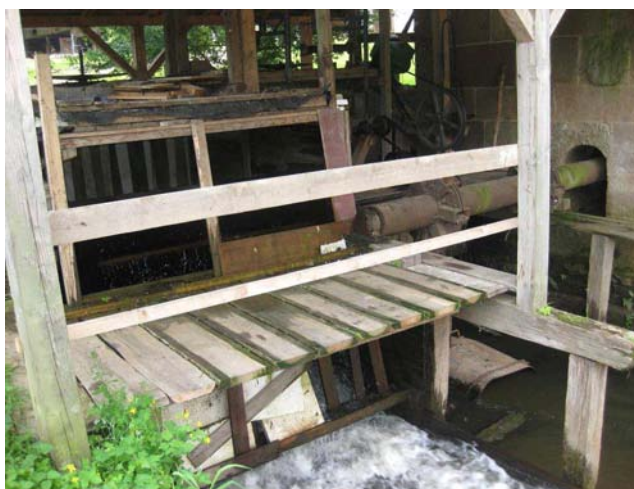
Funkční vodní kolo, MVE nefunkční
