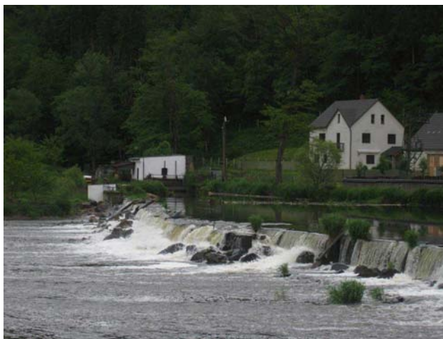
Pohled na jez z levého břeh
