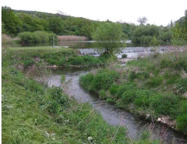
Vstup do RP na jezu, špatné řešení
