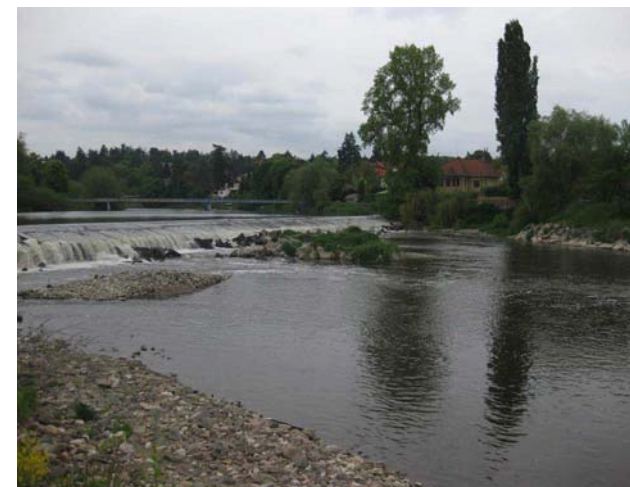
Pohled na podjezí
