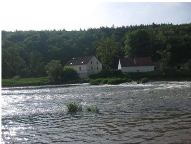
Stávající stav jezu, pravá strana
