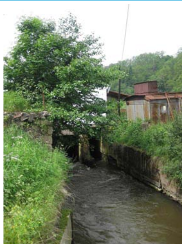
Odpadní kanál od MVE
