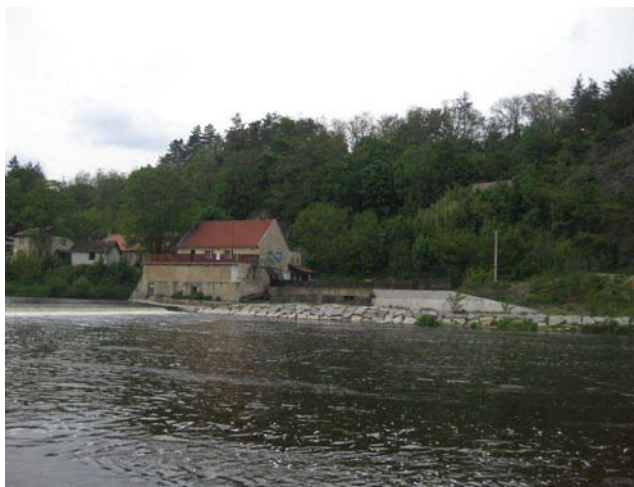
Levá strana jezu s nefunkční MVE
