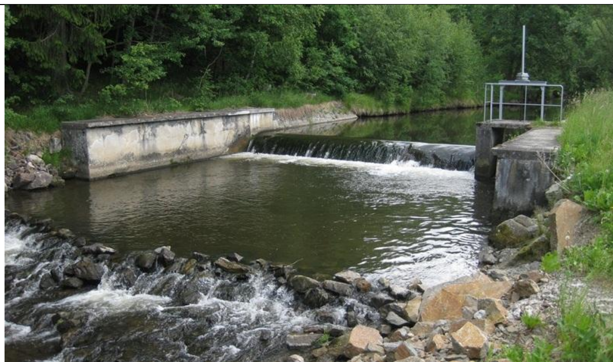
Obr. 4: Ilustrační obrázek –stupeň Dolní Dvořiště (ř.km 67,846)
