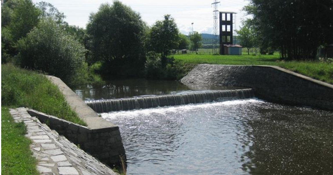
Obr. 3: Ilustrační obrázek – stabilizační Stupeň Kaplice (ř.km 48,618)
