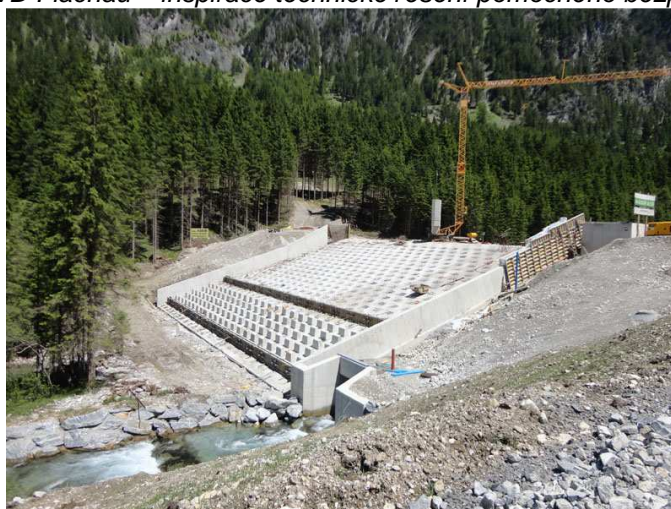
Obrázek 8 - VD Flachau – inspirace technické řešení pomocného bezpečnostního přelivu
