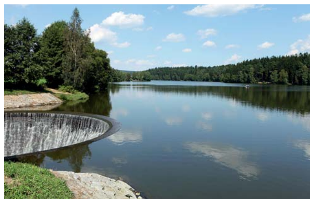
Vodní nádrž Strž
